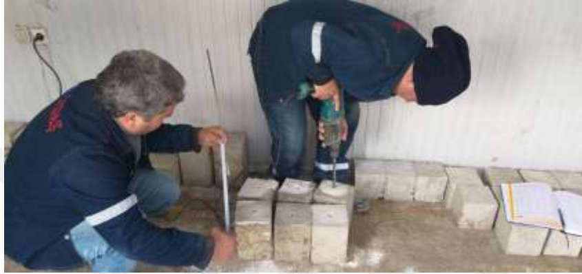
Resim 3.3 Betonlara ankraj deliği açılması
