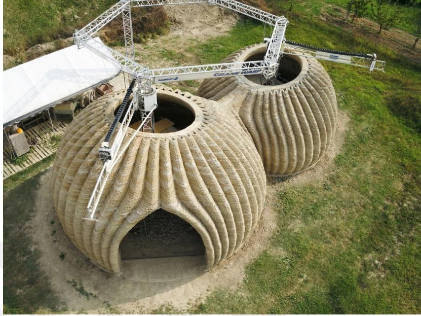
Şekil 2.3. TECLA Projesi – 3D Baskı ile Doğal Malzeme Kullanımıyla İnşa Edilmiş Sürdürülebilir Konut Prototipi
