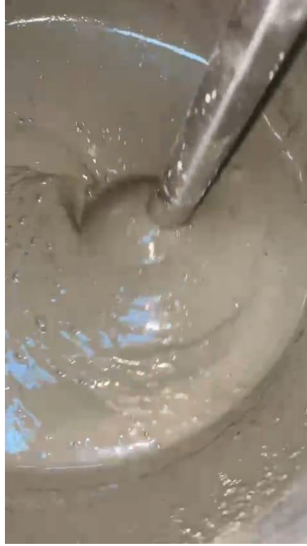
Şekil 3.11. Harcın el blenderı ile karıştırılması
