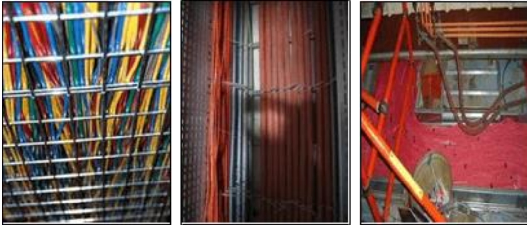
řekil 2.1. Kabloların yoėun bir řekilde gruplanarak bina iinde dřenmesi
