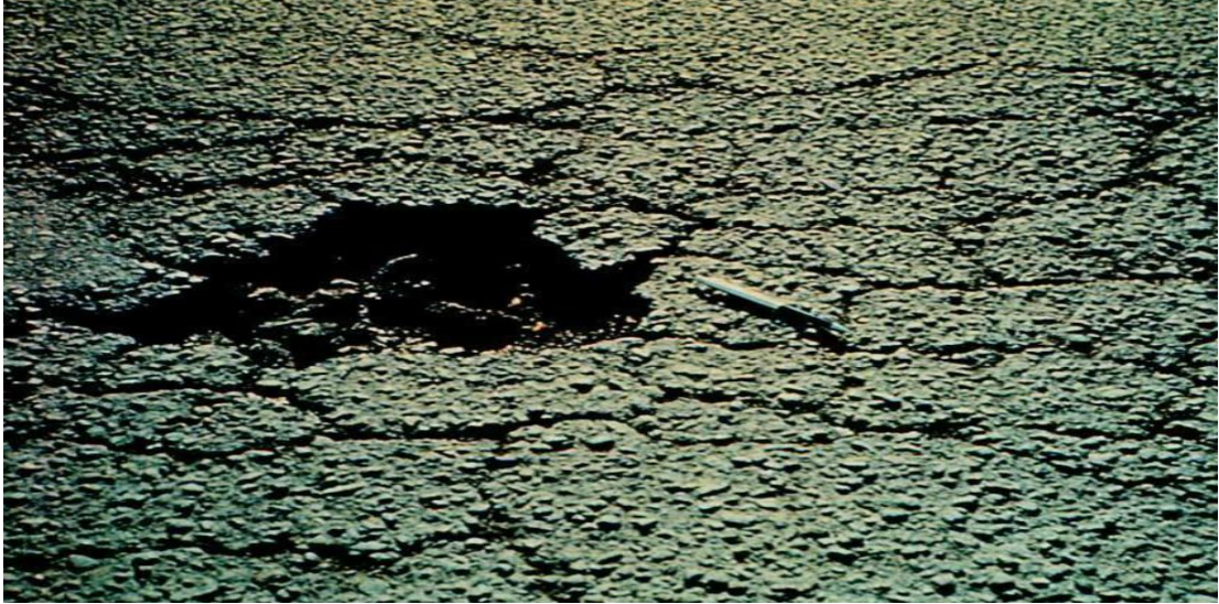
Şekil 2.6 Tipik bir çukur bozulması
