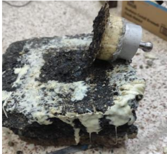
Şekil 4.23. Asfalt kaplama yüzeyine termoset beton kaplama uygulamasında numunede kopma şekli
