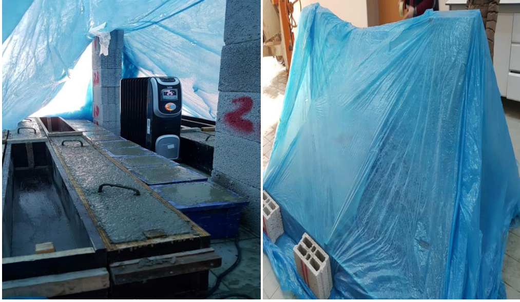
Şekil 3.38. Lentoların priz alması için hazırlanan ortam
