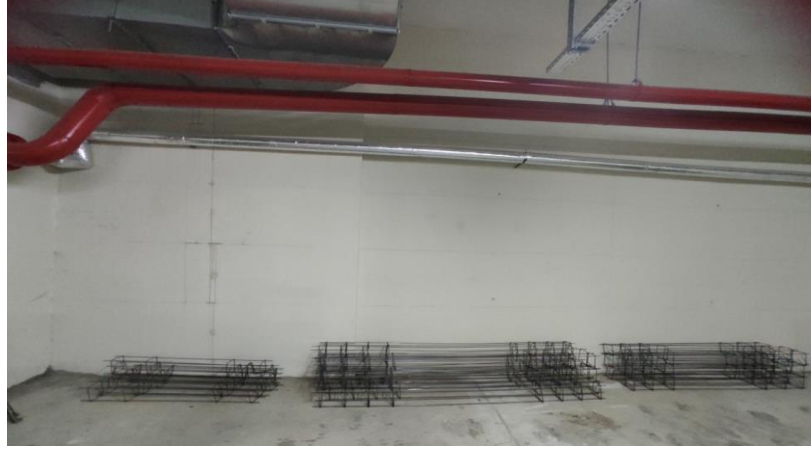
Şekil 3.33. Tm boyutlar iin hazırlanan donatı kafesleri
