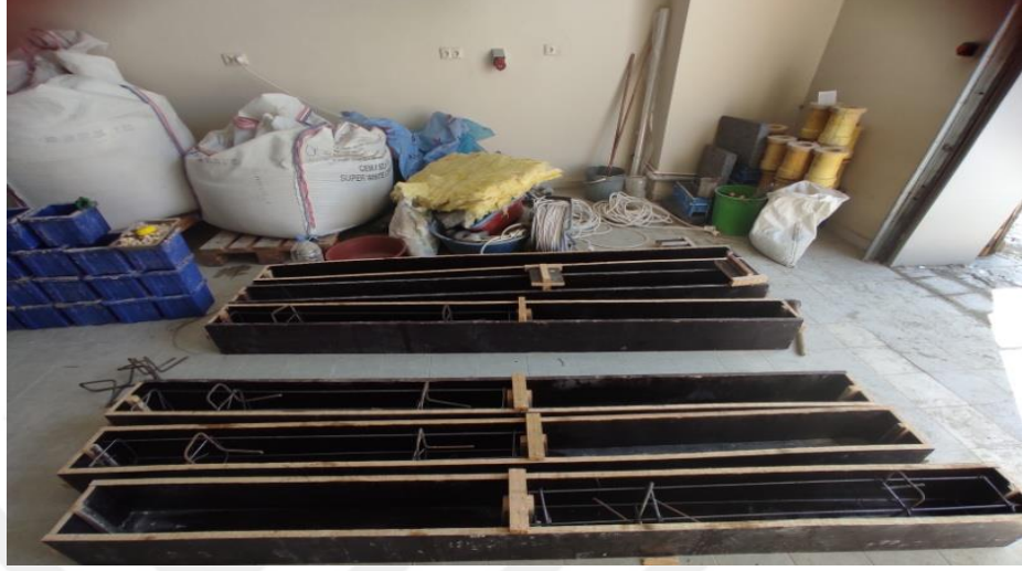
Şekil 3.35. Beton dökümü öncesi kalıp içerisine yerleştirilen donatı kafesleri
