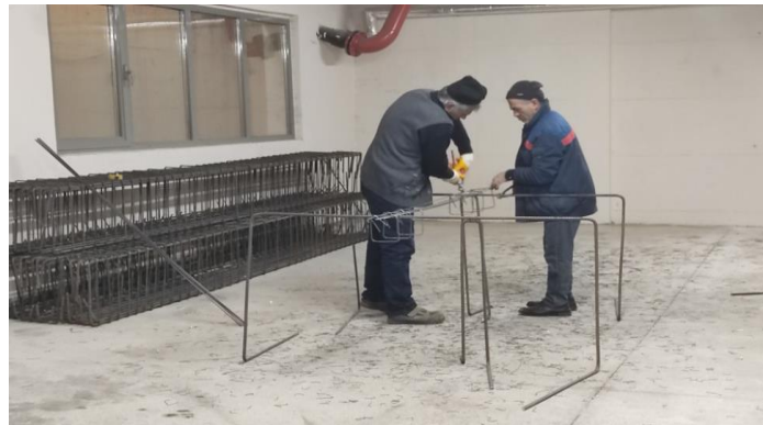
Şekil 3.32. Lentolar için donatı kafeslerinin hazırlığı
