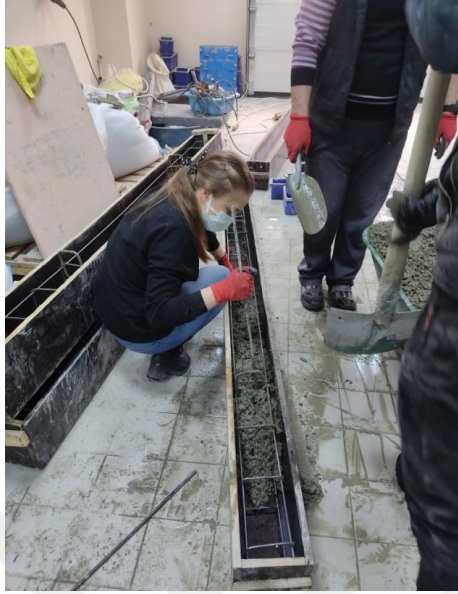
Şekil 3.37. Lentolar için beton dökümü çalışmalarından görüntüler
