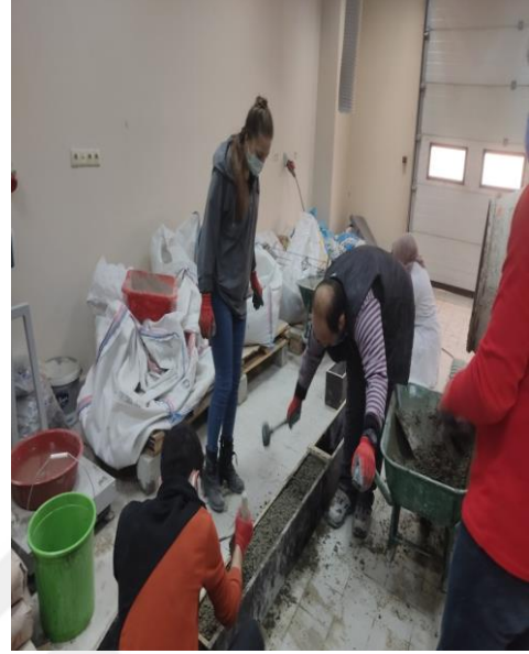
Şekil 3.37. Lentolar için beton dökümü çalışmalarından görüntüler
