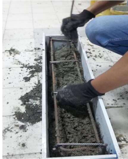
Şekil 3.24. Beton karışımının lento kalıplarına yerleştirilmesi
