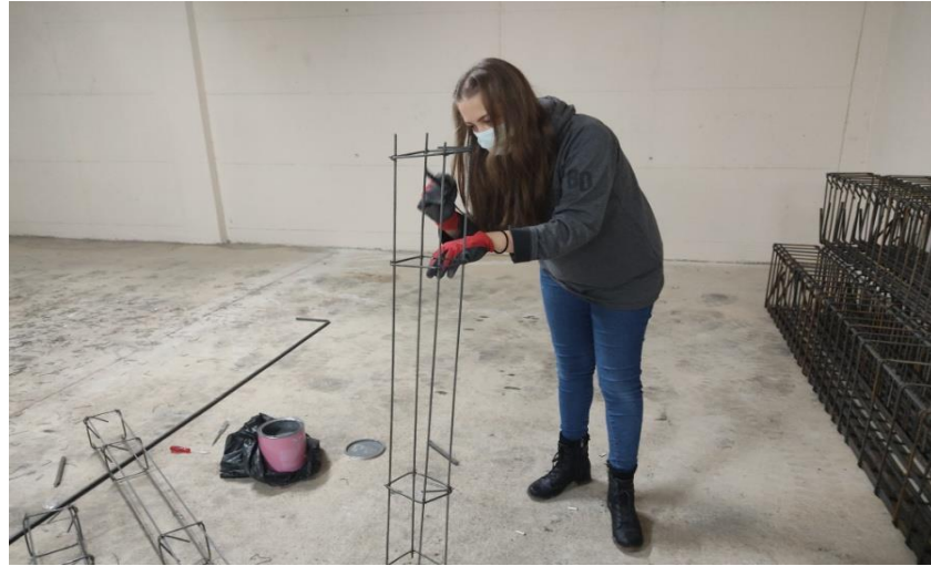
Şekil 3.34. Lento donatısına antipas uygulaması
