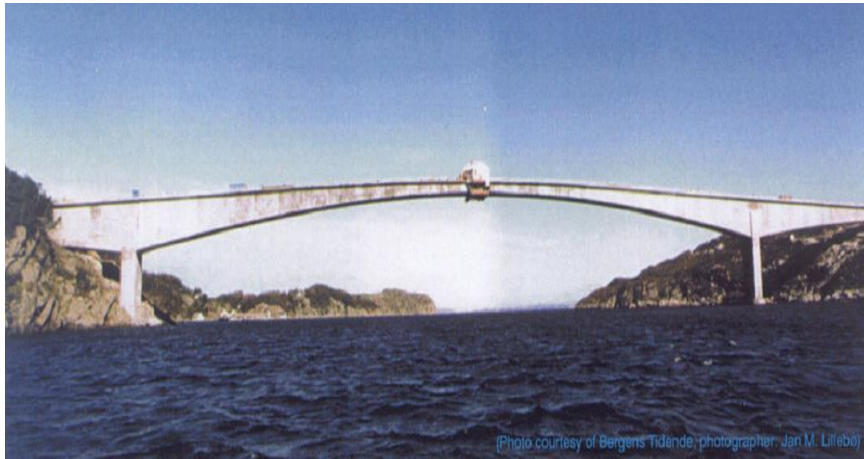
Şekil 2.5. Stolmen Köprüsü, Norveç
