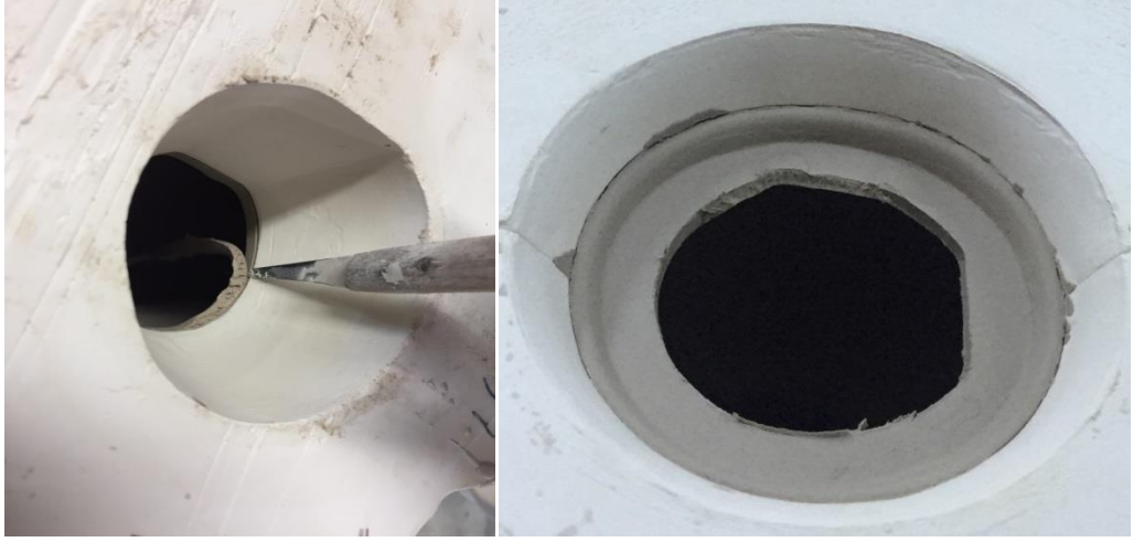
Görsel 78: Kestamit Parçayla Kesilme Aşaması
