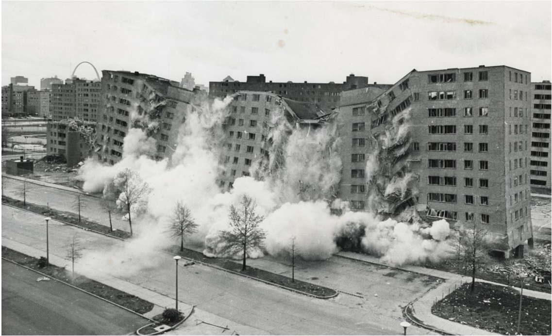
Şekil 2.15 St. Louis’deki Pruitt-Igoe’nin yıkım anından bir fotoğraf [25]
