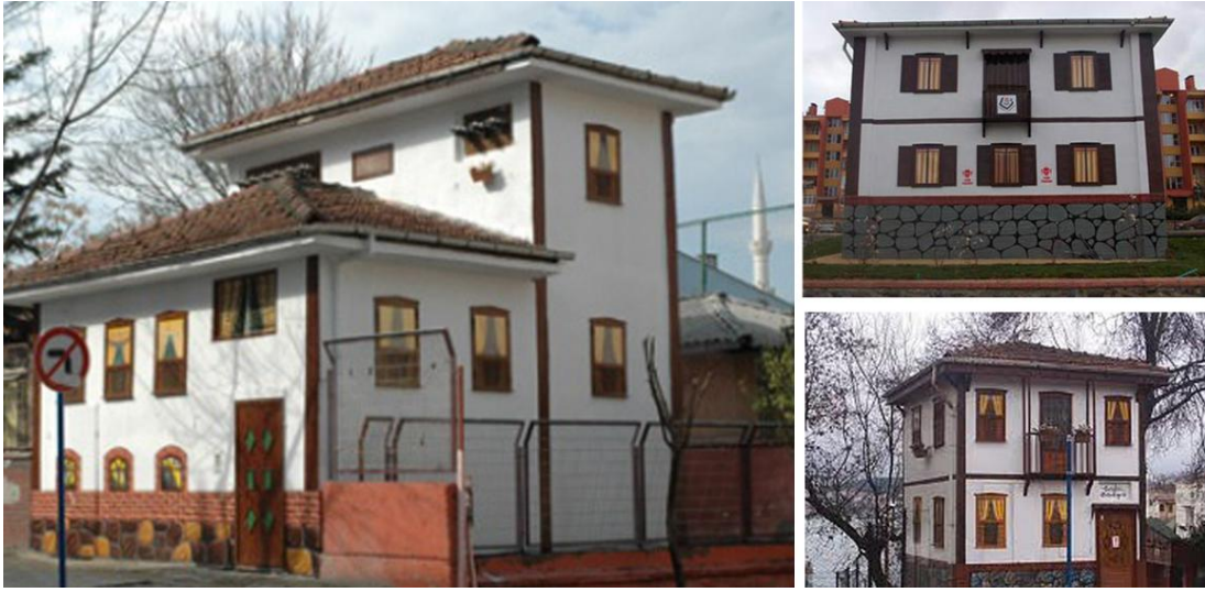
Şekil 3.14 Trafo yapısı, Avcılar İstanbul [70]
