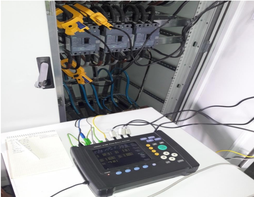
Şekil 2.6. Ölçüm cihazının sistemle entegrasyonu
