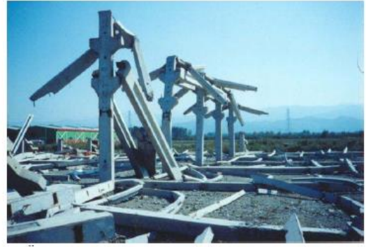
Örnek yapının 1999 Marmara depremi sonrası durumu
