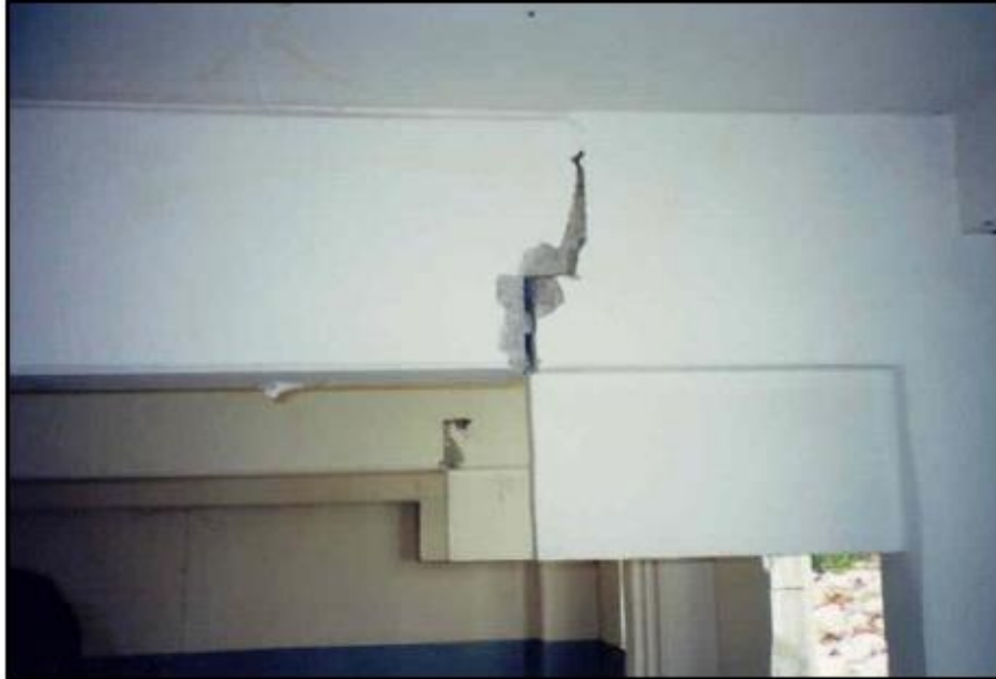
Şekil 2.3 Moment aktaran bağlantı hasarı (Atalay, 2010)
