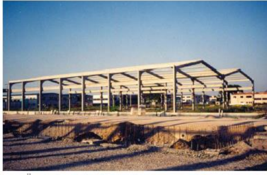
Örnek yapının 1999 Marmara depremi öncesi durumu
