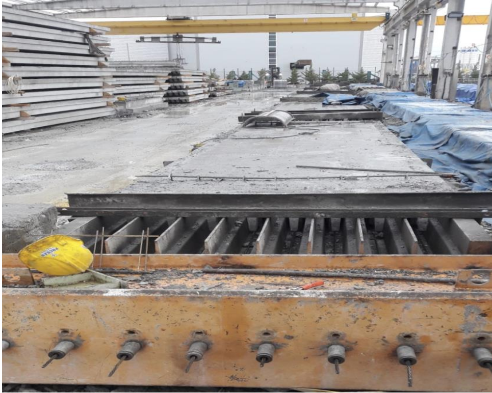
Şekil 1.22. Öngerme işlemi sonrası halat durumu
