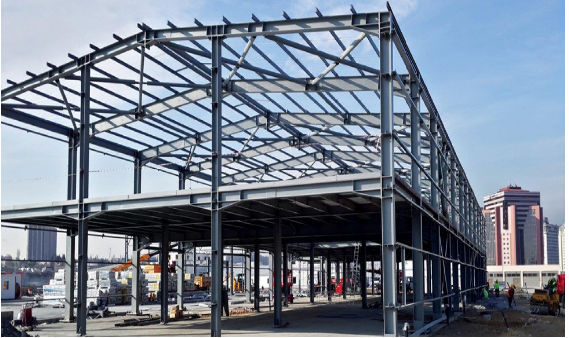
Şekil 1.3. Prefabrik çelik taşıyıcı sistem üretim alanı (URL 3)
