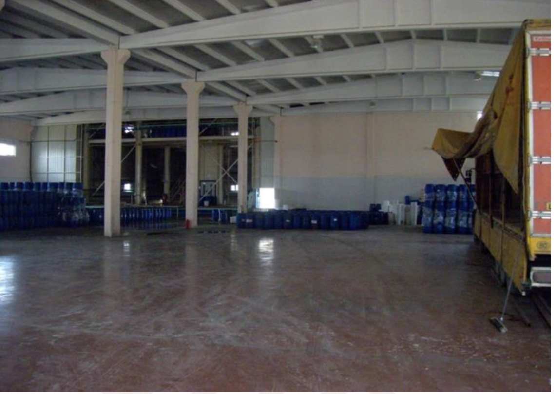
Şekil 1.12. Prefabrik depo örneği (URL 12)
