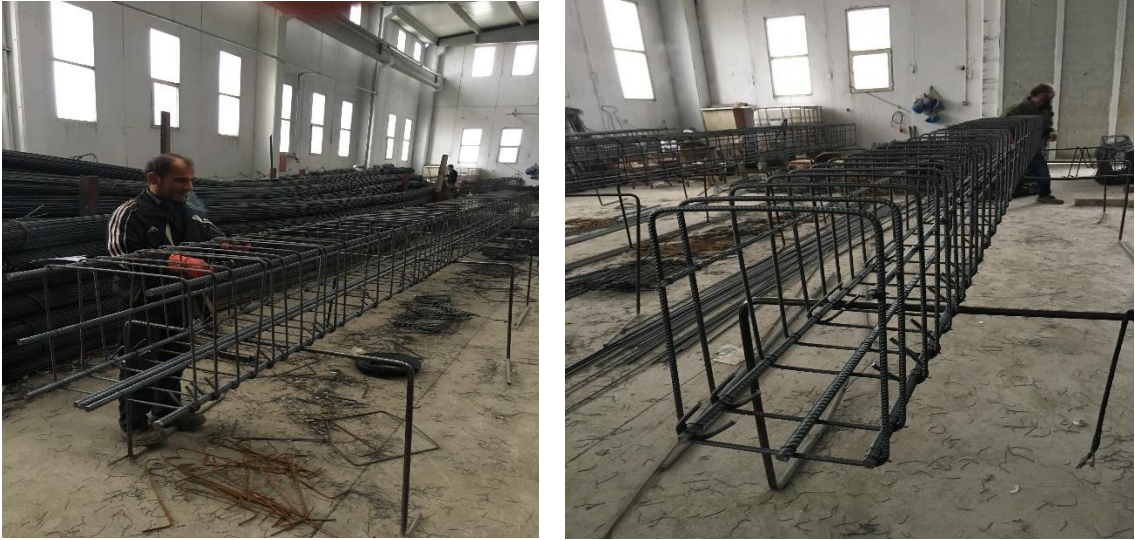
Şekil 1.29. Donatı ve etriye bağlama işlemi
