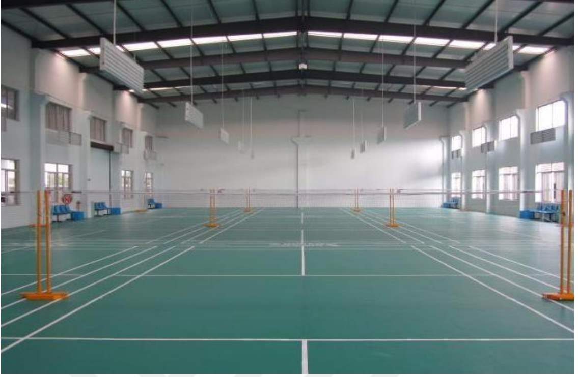
Şekil 1.4. Prefabrik spor salonu örneği (URL 4)
