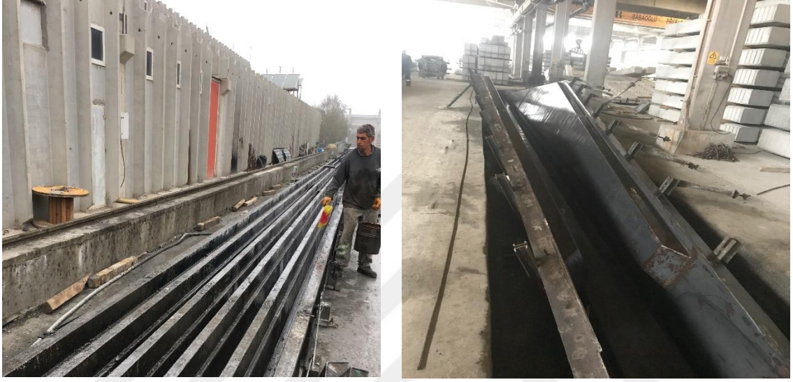
Şekil 1.28. Kalıp temizleme ve yağlama işlemi
