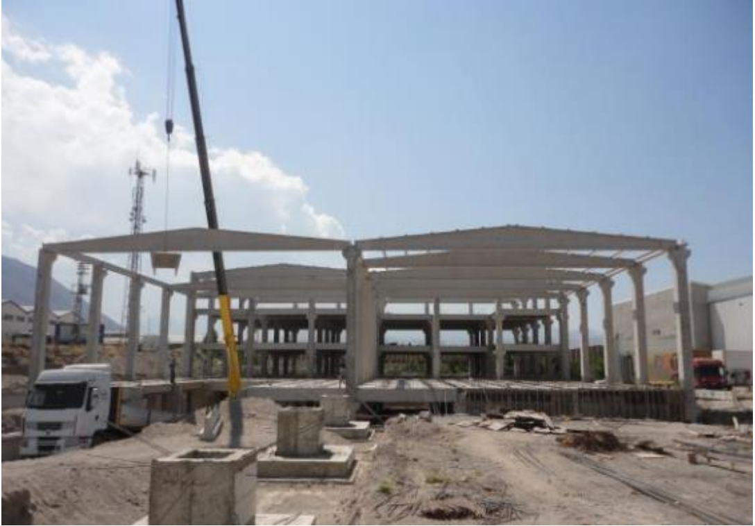
Şekil 1.33. Prefabrik sanayi yapısının montajı
