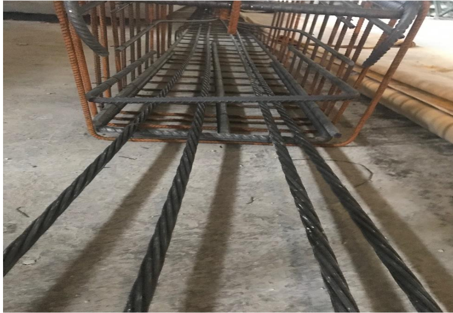
Şekil 1.19. Kiriş tabanına sürülmüş halatlar
