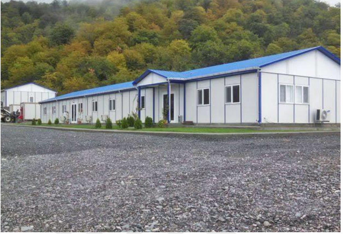
Şekil 1.8. Prefabrik şantiye örneđi (URL 8)
