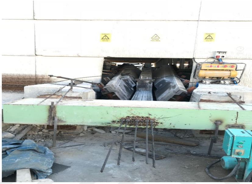
Şekil 1.20. Kesilmiş halat örneği
