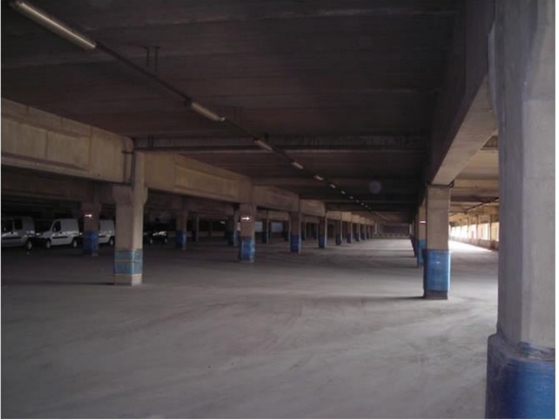
Şekil 1.13. Prefabrik taşıyıcı sistem park alanı (URL 12)
