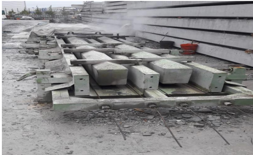
Şekil 1.21. Öngerme işlemi öncesi halat durumu
