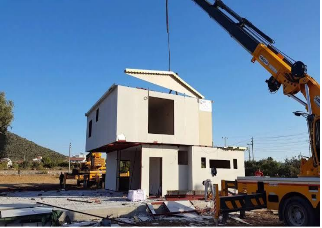
Şekil 1.34. Prefabrik konut yapısının montajı
