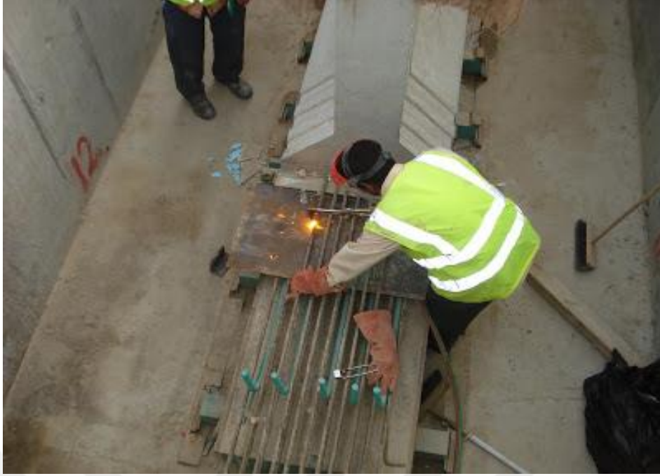
Şekil 1.26. Öngermeli halatların kesilme örneği (URL 16)
