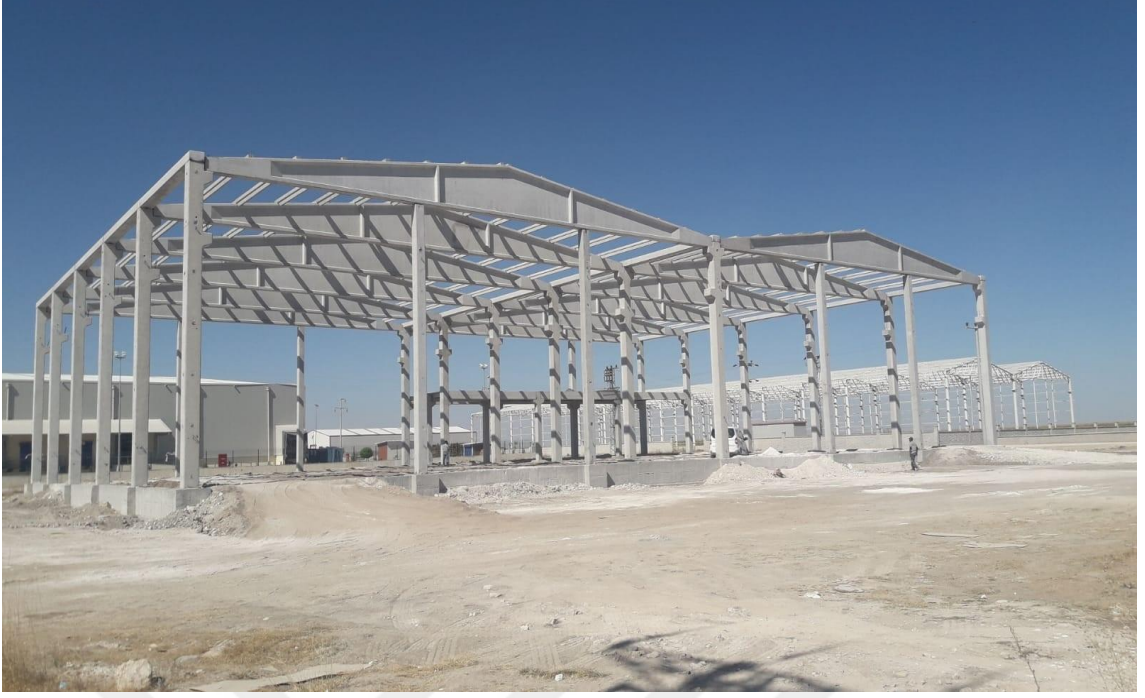
Şekil 1.14. Prefabrik sanayi yapısı örneği
