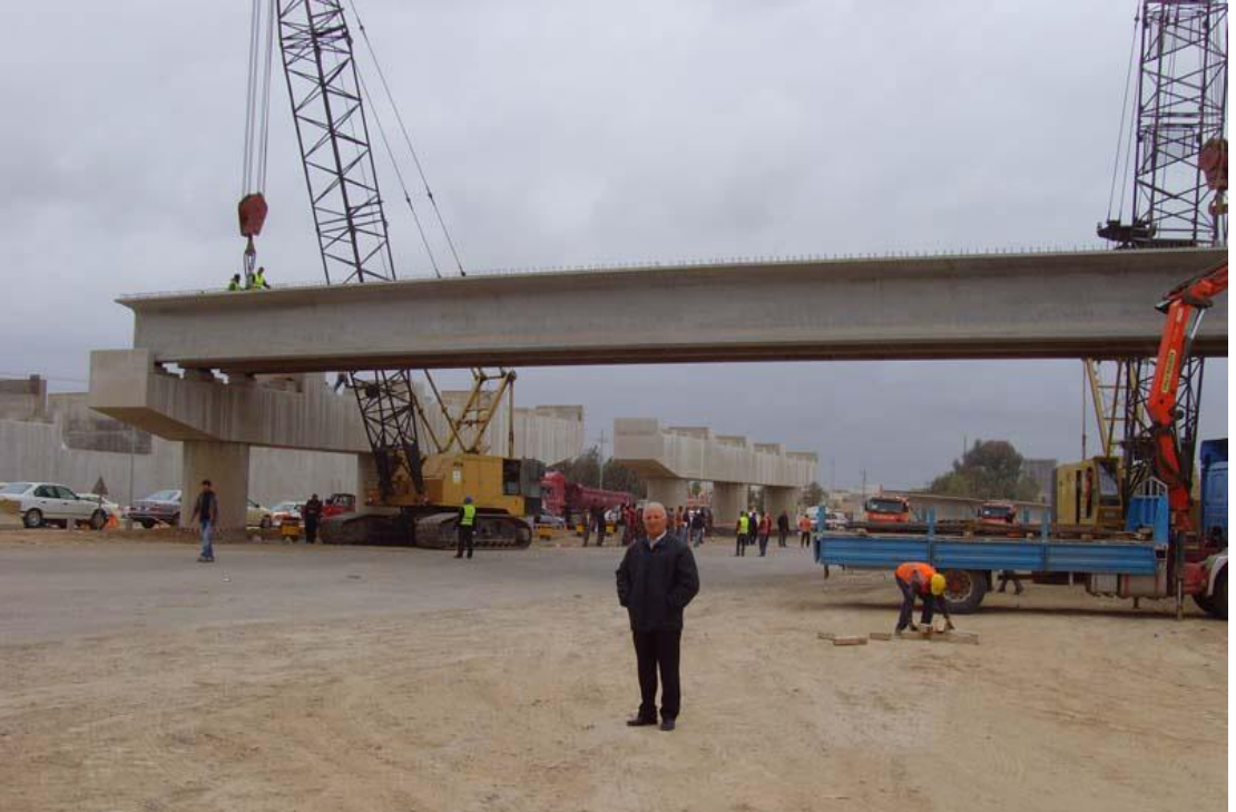
Şekil 1.35. Prefabrik sanat yapısının montajı (URL 14)
