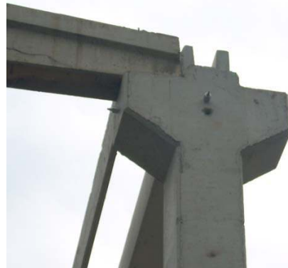
Şekil 2.16. Üretim tesisinin çerçeveleri üzerine yerleştirilen ivmeölçerlerin yerleşim düzeni
