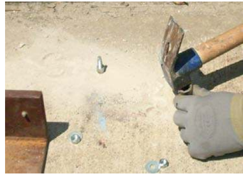
b. Dübel ve çelik vida montajı
