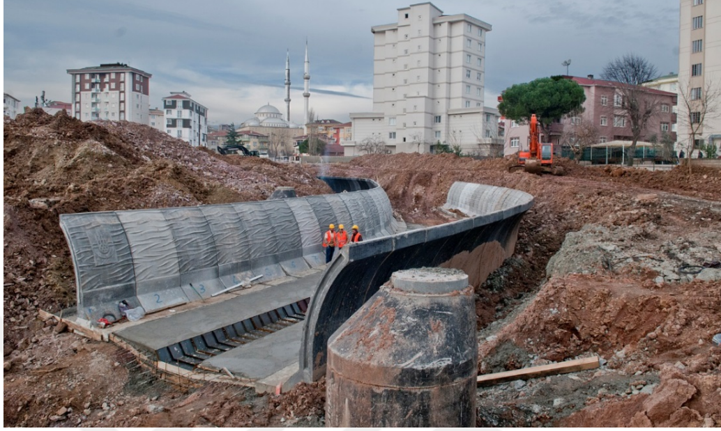
Şekil 2.10 Prefabrik Yay Kesit Elemanı[23]
