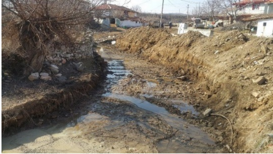
Şekil 3.10 Akarsu Yatağı Tesviyesi [25]
