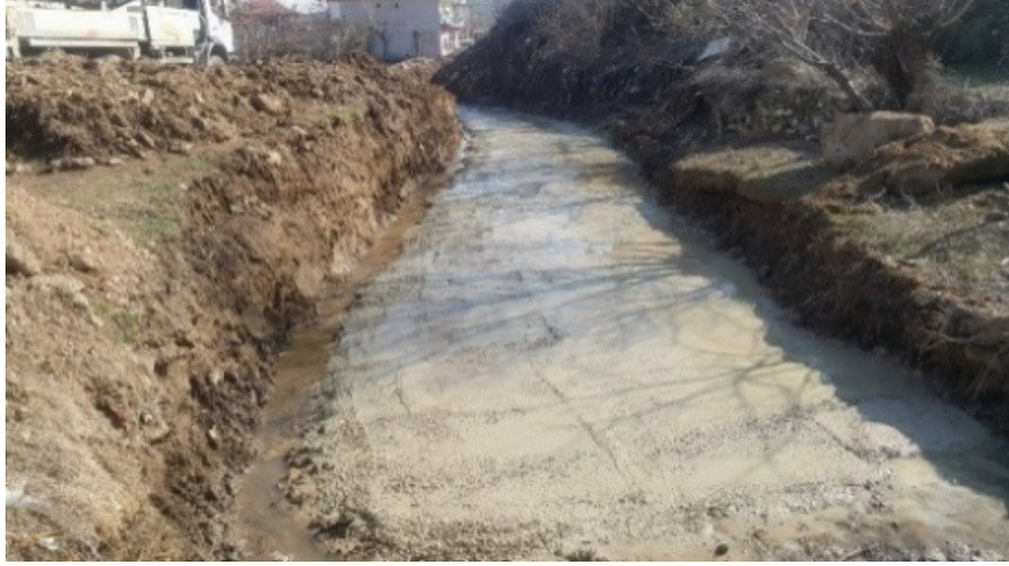
Şekil 3.11 Akarsu Yatağı Grobeton İmalatı [25]
