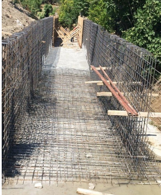
Şekil 3.12 Akarsu Islahında Donatı Uygulaması [26]
