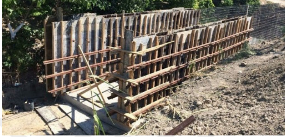
Şekil 3.13 Akarsu Islahında Kalıp Uygulaması [26]
