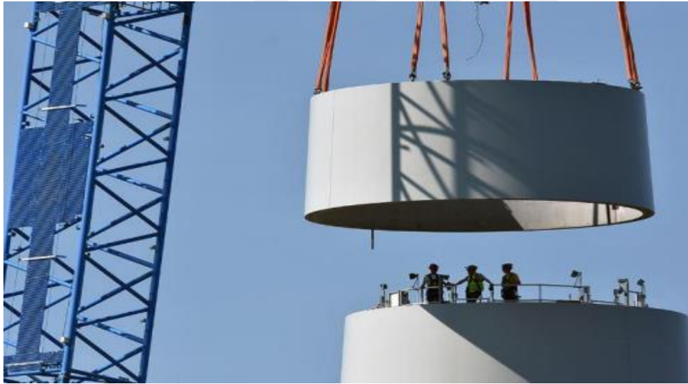
Şekil 3.11: Rüzgâr türbin kule parçalarının montajı
