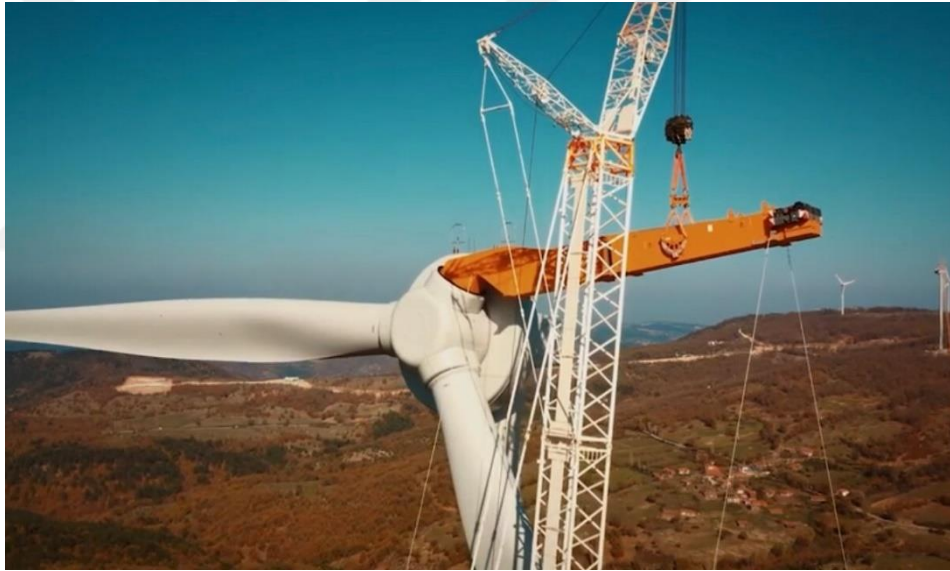
Şekil 3.14: Rüzgâr türbin kanatlarının montajındaki dengeleme aparatı
