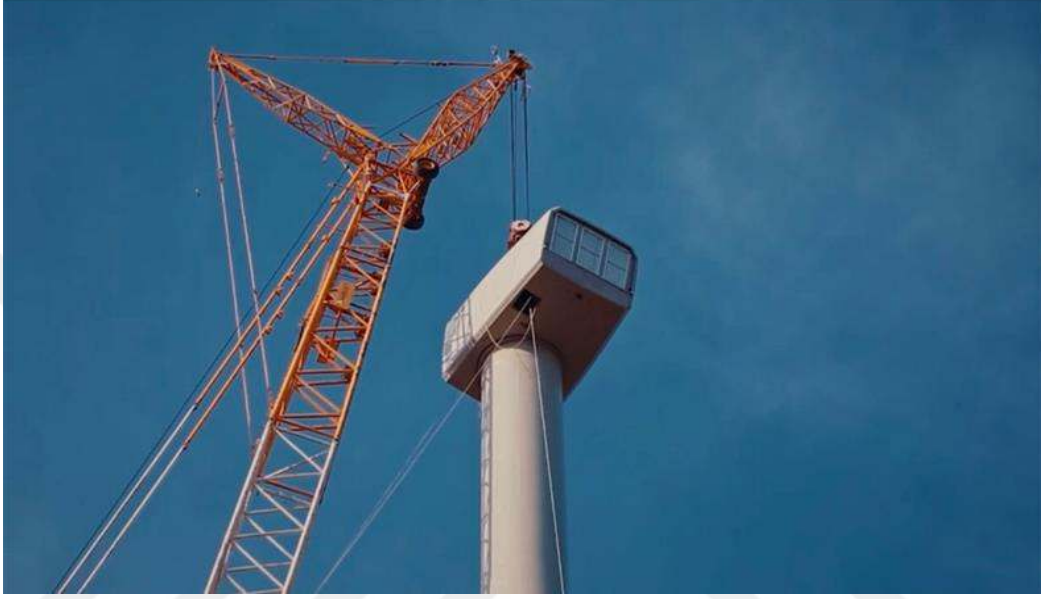
Şekil 3.12: Rüzgâr türbinin nacelle parçası montajı
