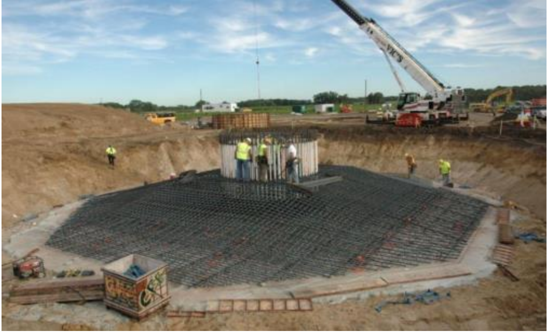
Şekil 3.7: Beton donatının alana yerleştirilmesi
