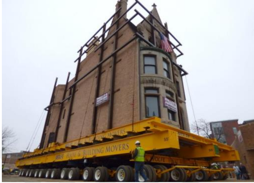
Şekil 2.28: Harriet F. Rees Malikânesi’ nin SPMT ile taşınması
