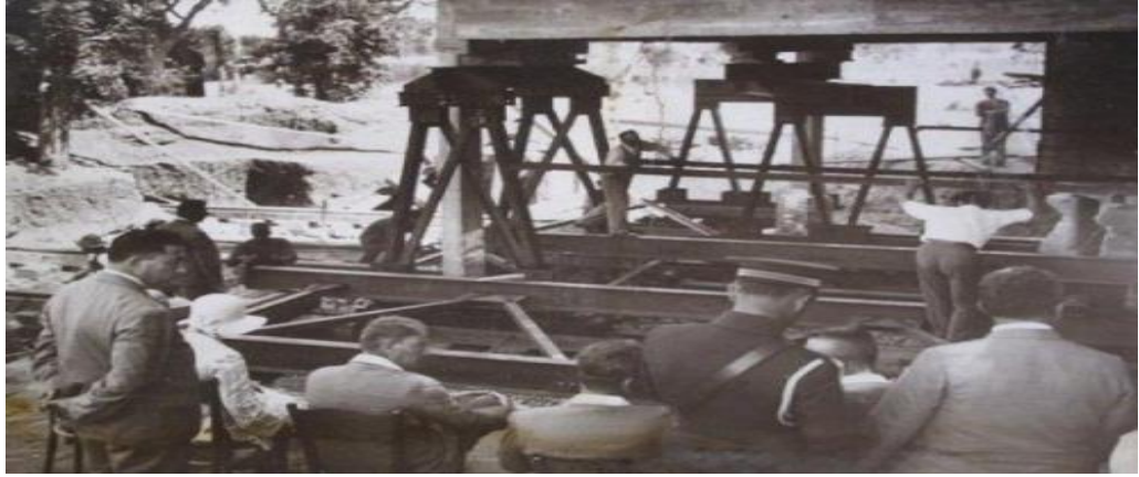
Şekil 2.30: Yürüyen Köşk için kullanılan raylı sistem
