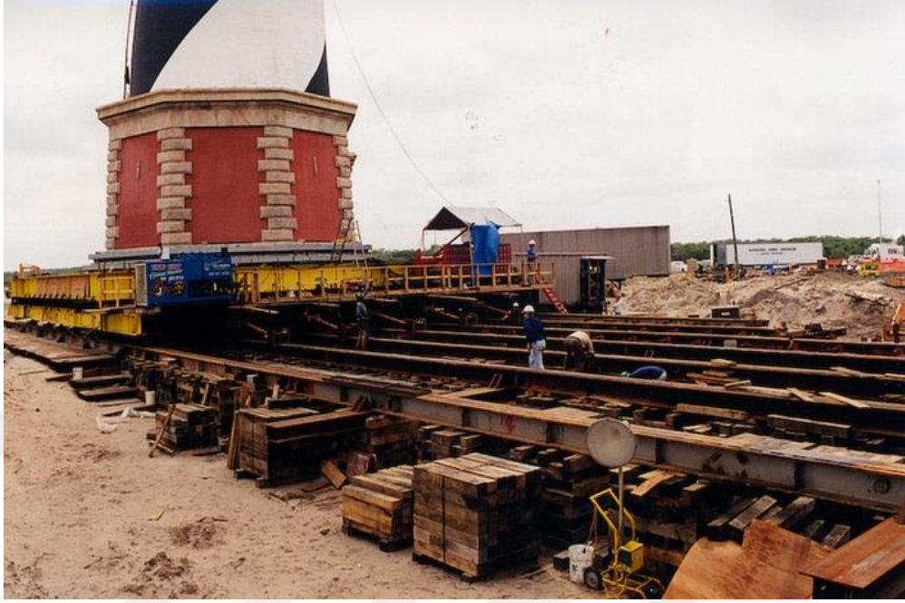
Şekil 2.27: Cape Hatteras Deniz Feneri’nin raylı sistem ile taşınması
