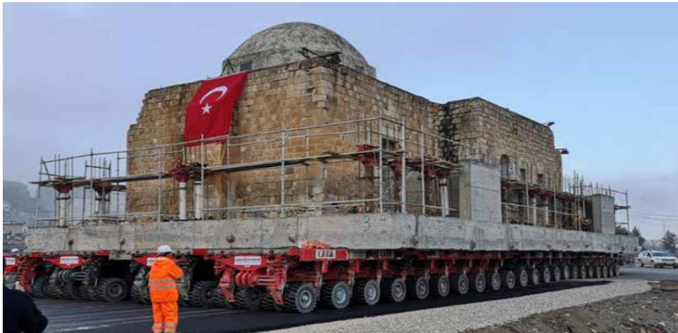
Şekil 2.34: Hasankeyf Kızlar (Eyyubi) Camii’nin SPMT ile bütüncül taşınması
