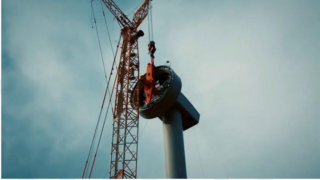
Şekil 3.13: Rüzgâr türbin jeneratör ve hub montajı
