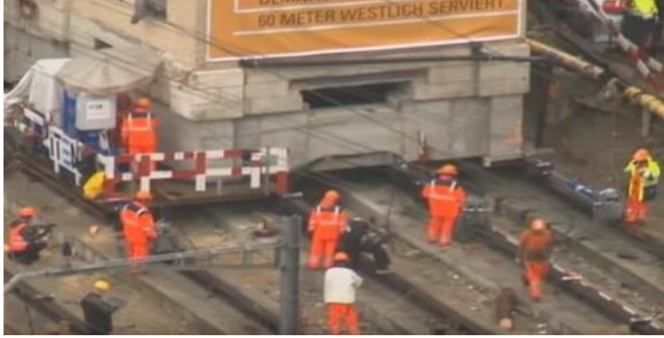
Şekil 2.29: Tarihi Oerlikon Makine Fabrikası'nın çelik ray sistemi ile taşınması
