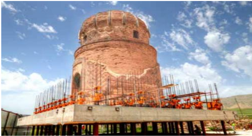
Şekil 2.35: Zeynel Bey Türbesi’nin krikolarla kaldırılması
