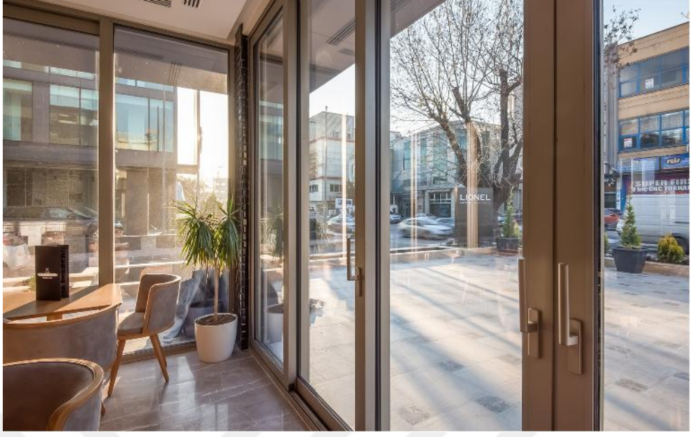
Şekil 6.2. Sürme doğrama ve kapı örneği
