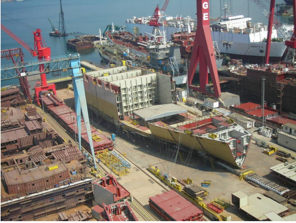
Şekil 7.16 : Blokların kızakta montajının yapılması
