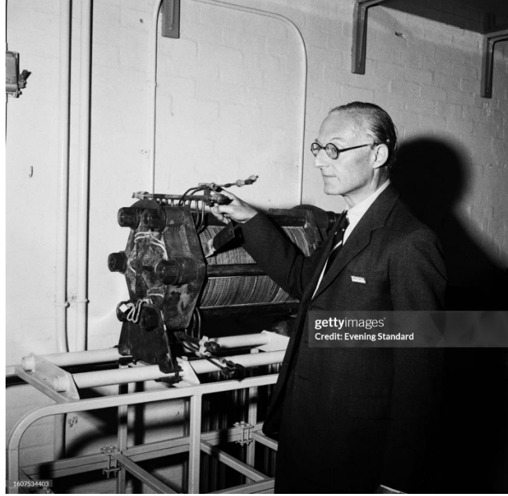
Şekil 4.2. Francis Bacon ve 5 kW’lık alkali yakıt pili yığını
