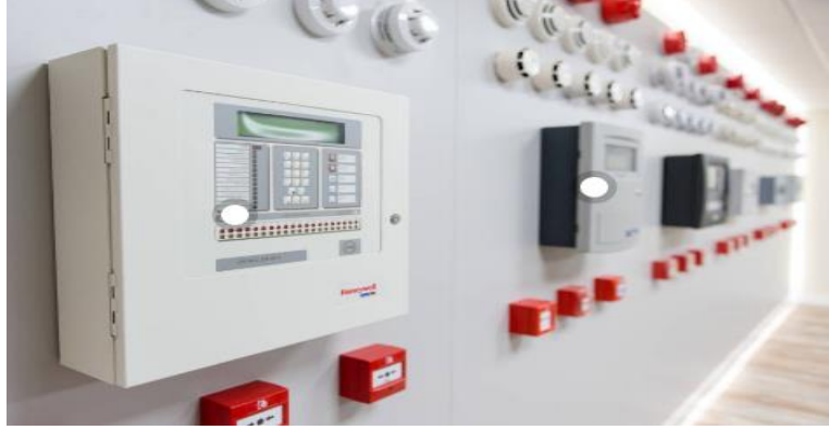
Şekil 1.13 Seralarda kullanılan alarm sistemleri (Kaptanoğlu, 2024)
