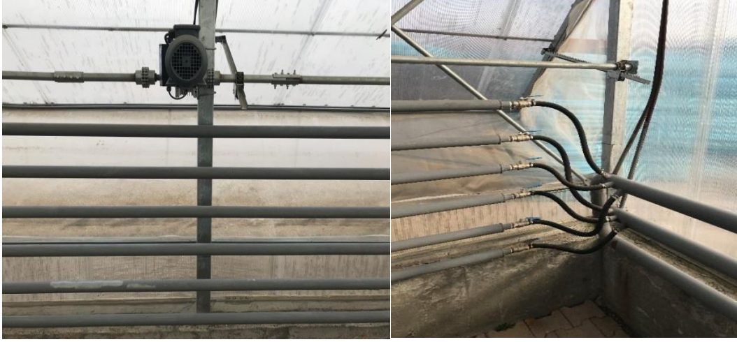
Fotoğraf 3.3. Deneme serasındaki jeotermal su düzeneği.
