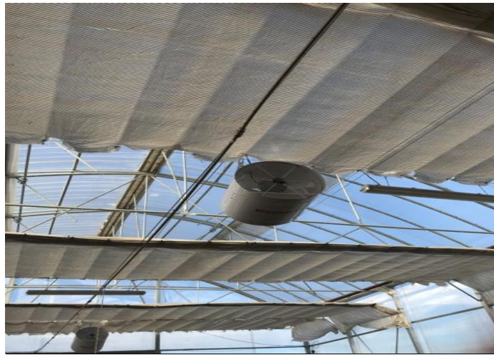
Fotoğraf: 3.4. Serada bulunan fanlar ve güneşi engelleme perdeleri
