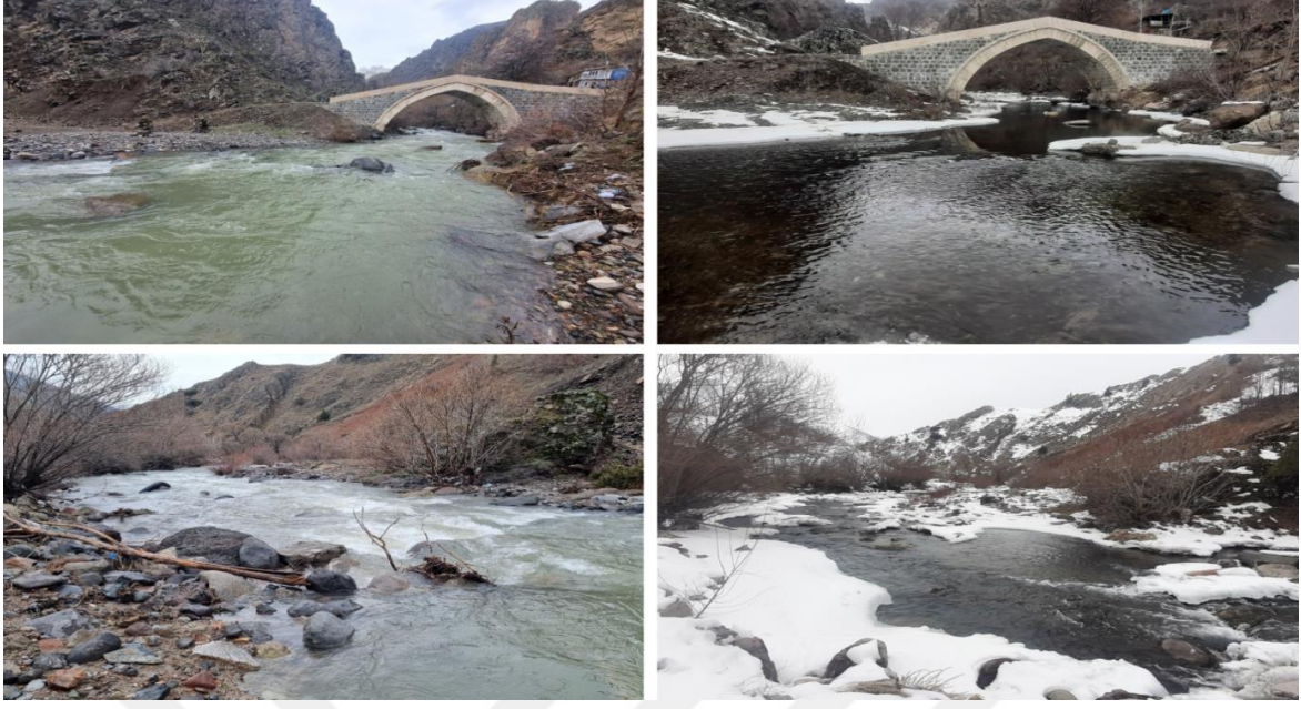
Şekil 3.3. II. İstasyon Pulumur Hanım Köprüsü (Orijinal)
