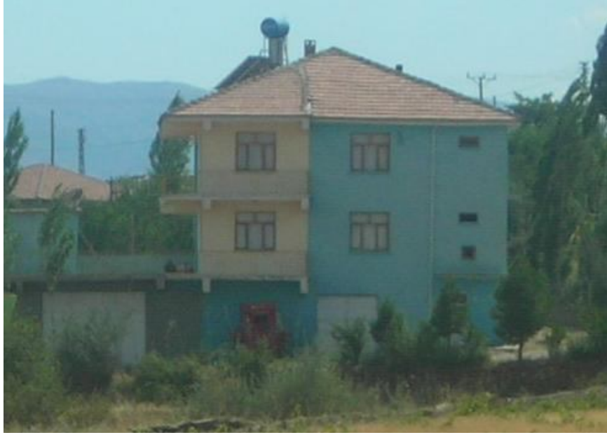
Foto 4.33: Pazarcık Köyü'nde alt katı depo ve garaj olarak kullanılan çok katlı bir mesken
