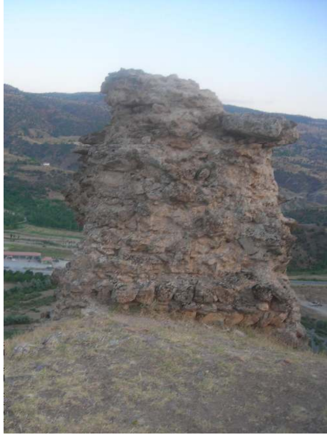
Foto 5.32: Kerar Kalesi'nin duvar kalıntısı
