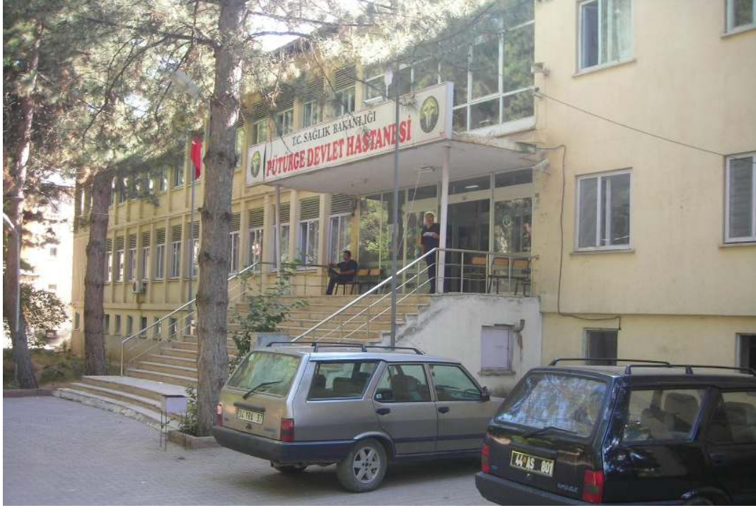
Foto 4.27: Pütürge Devlet Hastanesinden bir görünüm
