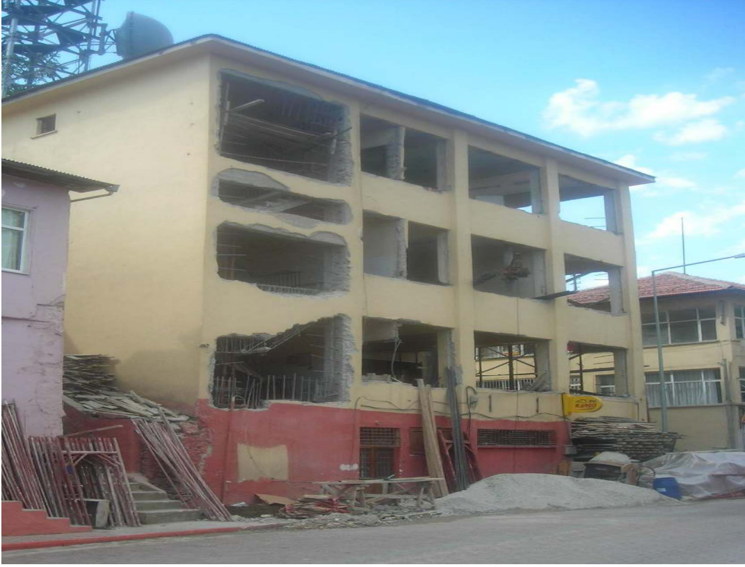
Foto 4.26: PTT hizmet binası tadilat görmektedir
