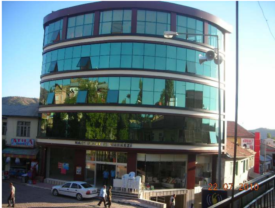
Foto 4.29: Köylü Mahallesi'nde modern yapılı bir iş merkezi
