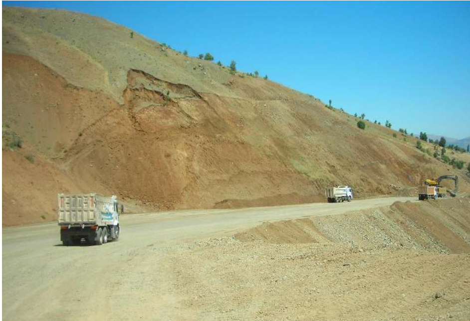
Foto 5.22: Kubbe Dağı mevkiinde sürdürülen yol yapım çalışmasından bir görünüm. Yol yapım çalışması yamaç-denge açısını bozmakta, bu durum, ulaşım güvenliği için büyük risk doğurmaktadır
