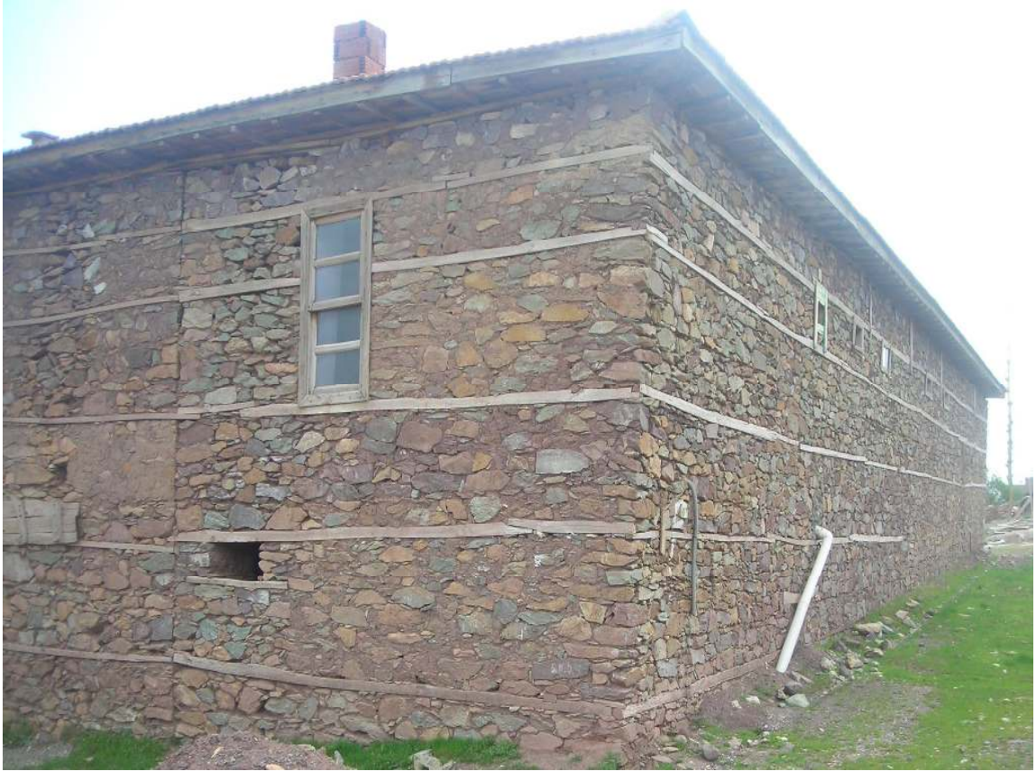
Foto 4.30: Özellikle eski meskenlerde taş malzeme kullanımı yaygındır (Pazarcık Köyü)
