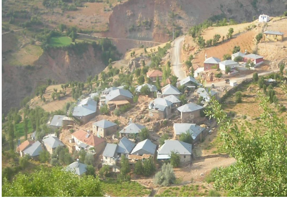
Foto 4.38: Pütürge köylerinde beşik çatı yaygınlaşmaktadır (Büyüköz Köyü)
