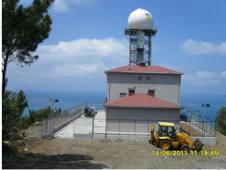
Şekil 3.6. Hatay meteoroloji radar anteni ve yerleşkesi. 5
