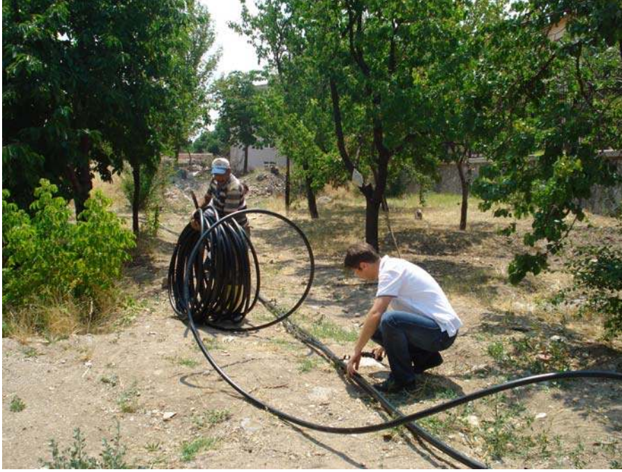
Resim 4.3. U-borusunun kuyu içersine yerleřtirmek için hazırlanışı
