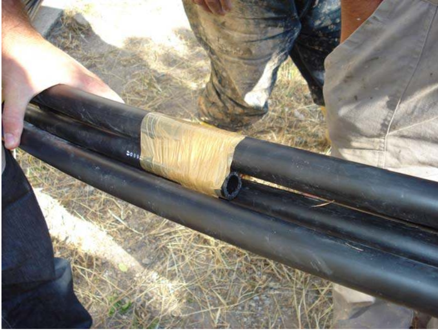
Resim 4.7. Drenaj borusunun görünümü
