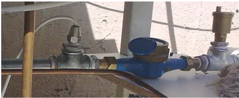
Resim 5.2. Su saatinin bağlantısı
