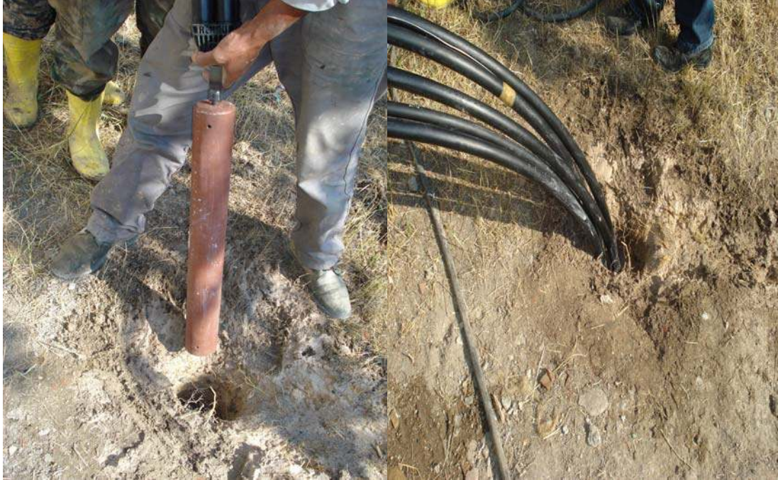
Resim 4.6. U-borusunun kuyu içerisine yerleştirilmesi
