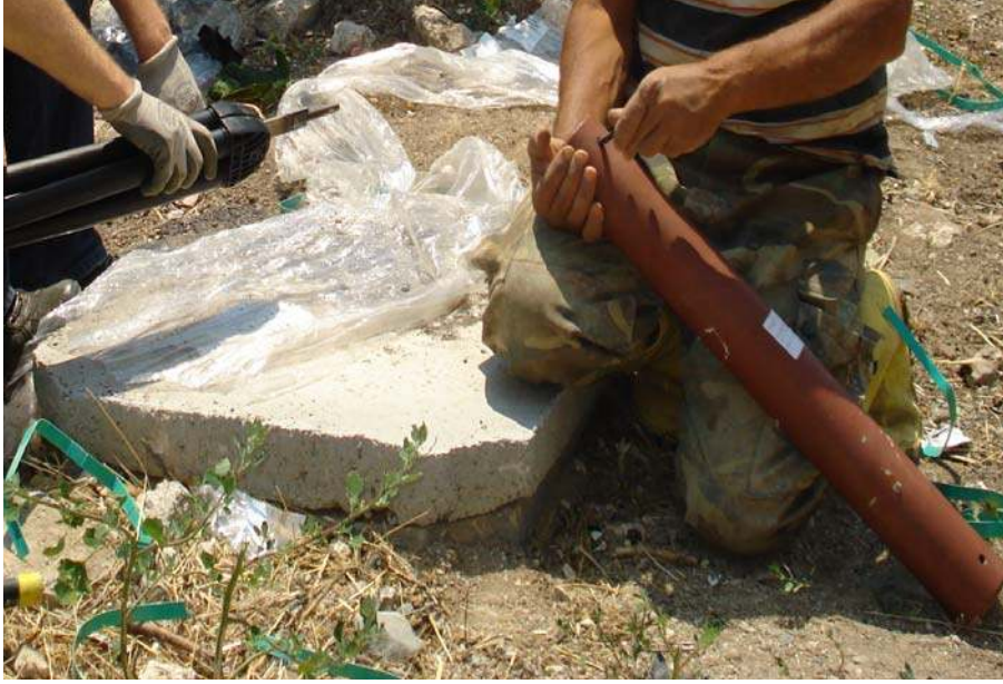
Resim 4.4. U bağlantısı ve ucuna bağlanan ağırlık
