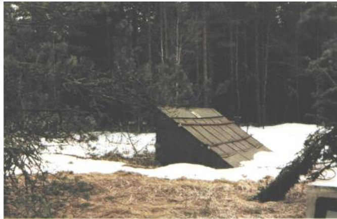
Şekil 4.9. Kaynağın bulunduğu depo (IAEA 1998)
