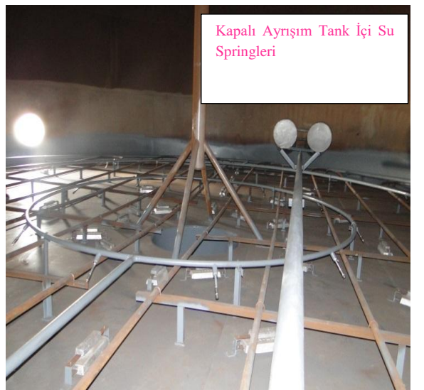
Şekil 3.11. Kapalı Ayrışım Tank Sistemi Kısımları
