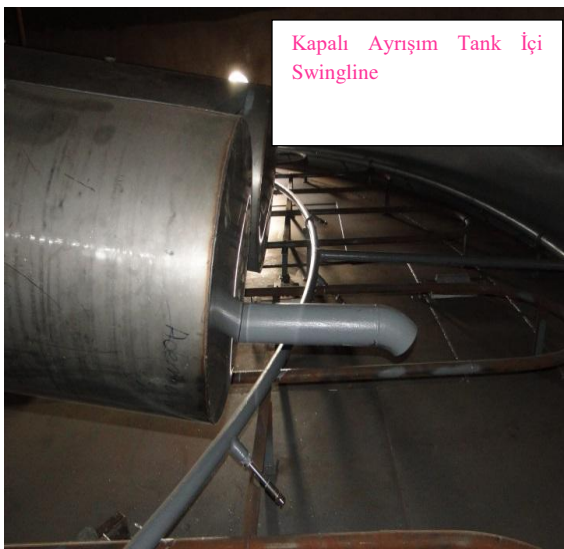
Şekil 3.11. Kapalı Ayrışım Tank Sistemi Kısımları
