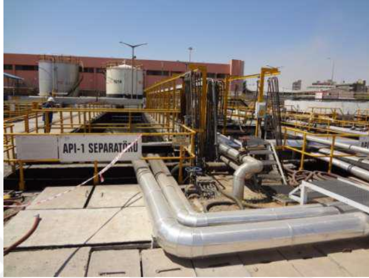
Şekil 3.5. Batman Rafinerisi AAT API Ayırıştırıcıları
