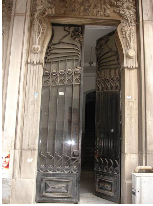
Resim 4.24 Botter apartmanı giriş kapısı
