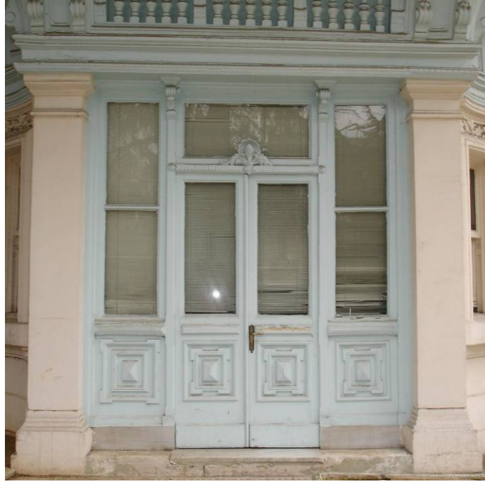
Resim 4.22 Nöbetçi pavyonu giriş kapısı
