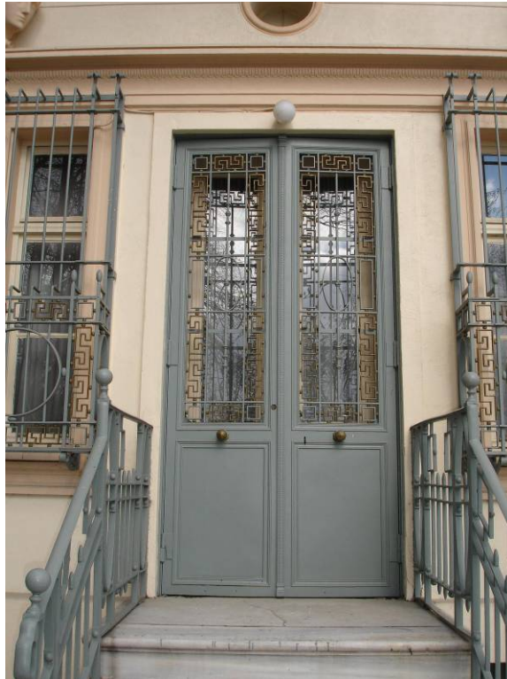
Resim 4.29 Huber Köşkü ek binasının ön cephesindeki giriş kapısı
