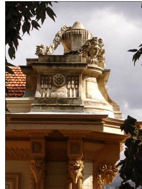
Resim 3.77 Çatı kenarındaki düzenleme
