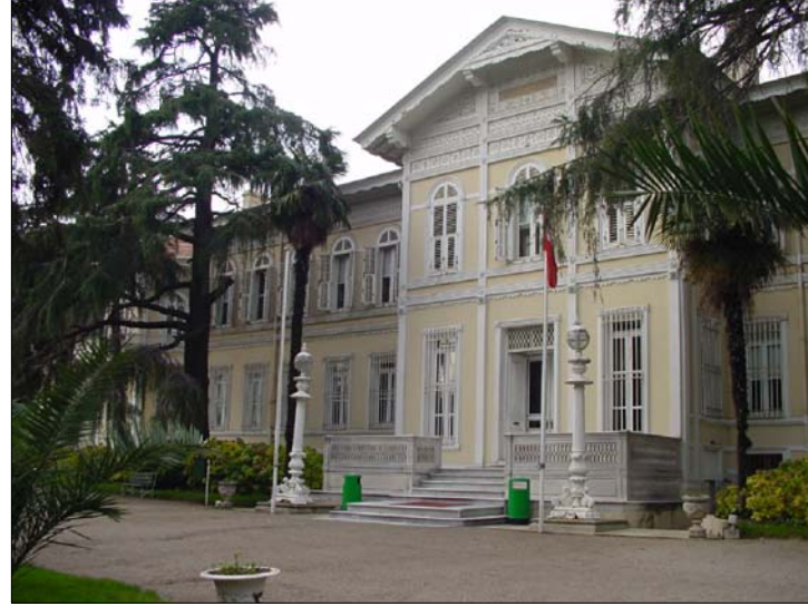
Resim 3.59 Ön cephedeki girişten genel görünüm
