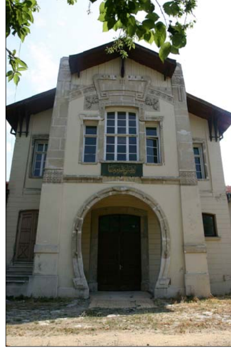
Resim 3.54 Orta bina ön cephesi
