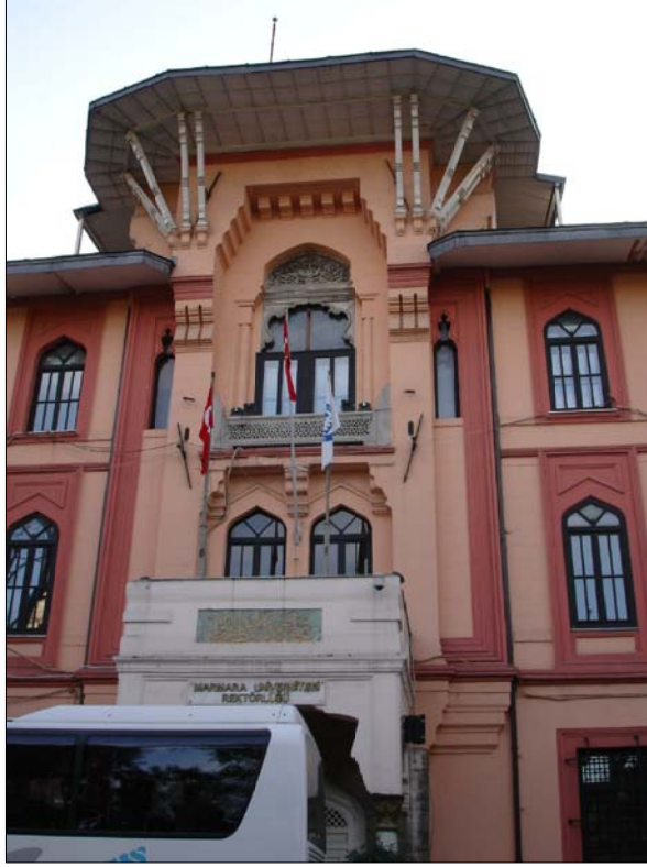
Resim 3.41 Tarım Bakanlığı, genel görünüm
