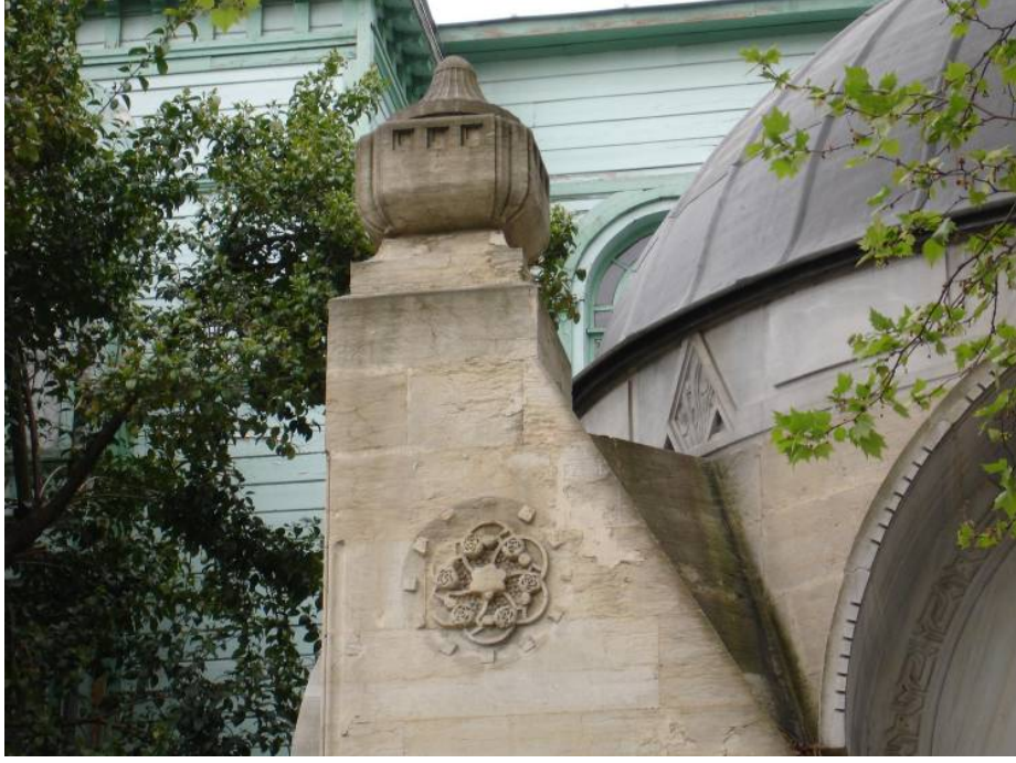
Resim 4.8 Şeyh Zafır türbesi köşe kule detayı
