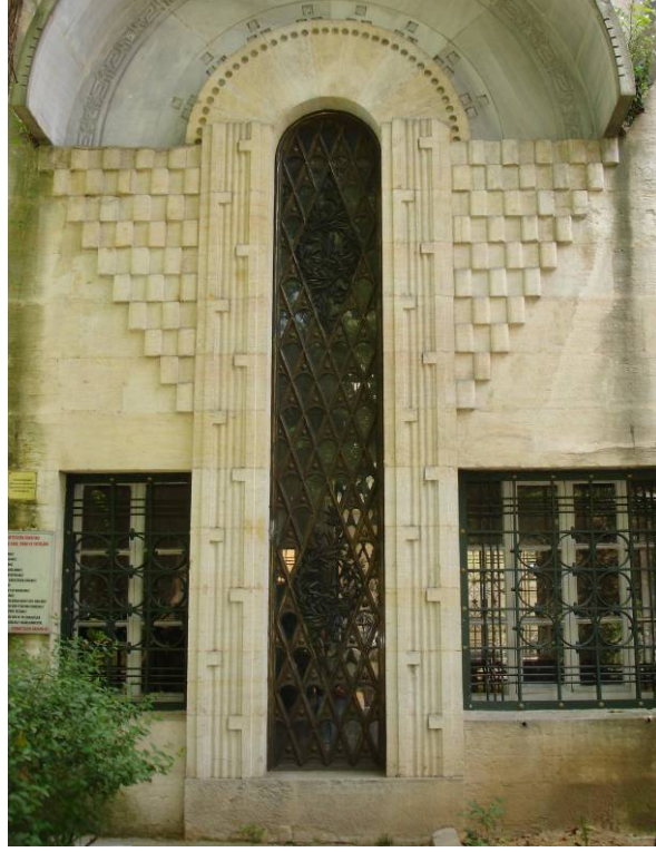
Resim 4.38 Şeyh Zafir türbesinde kemerli pencere düzenlemesi
