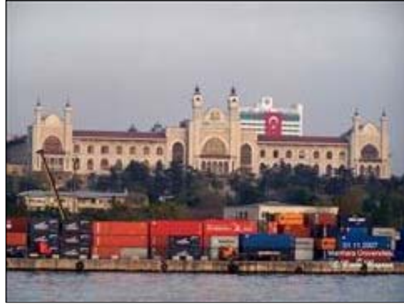
Resim 3.44 Batı cephesinden genel görünüm
