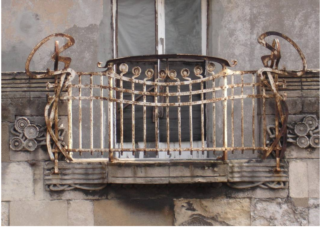
Resim 4.55 Botter apartmanının teras katındaki demir balkon korkulukları
