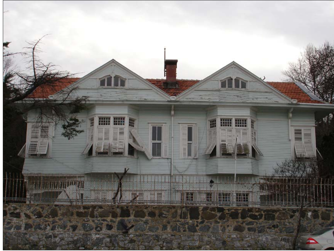
Resim 3.62 Genel görünüm (Kuzey Cephesi)
