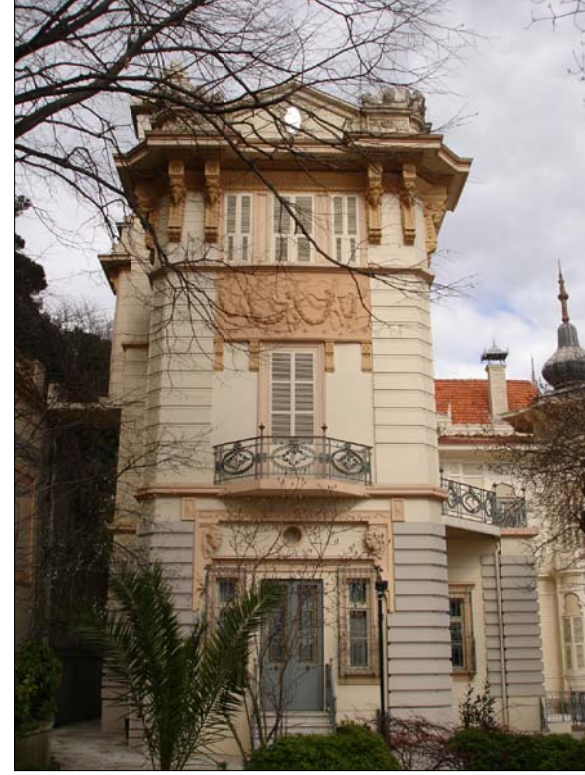
Resim 3.76 Ek binaya ait ön görünüş (Güney cephesi)
