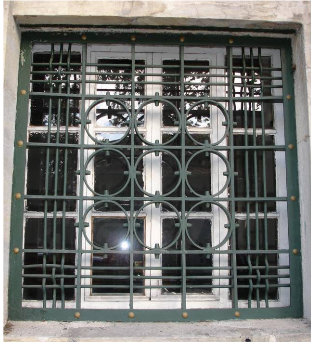
Resim 4.37 Şeyh Zafir türbesinde pencere düzenlemesi
