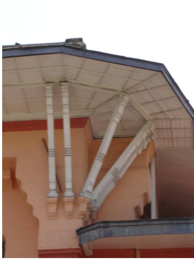
Resim 4.16 Tarım Bakanlığı binasındaki geniş saçak payandaları
