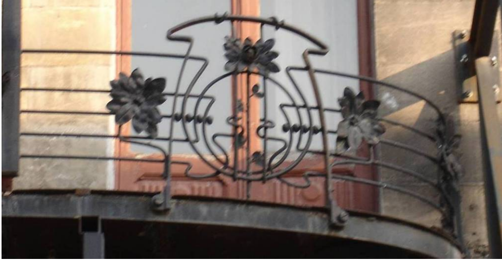
Resim 4.48 Botter apartmanındaki demir balkon korkuluk detayı
