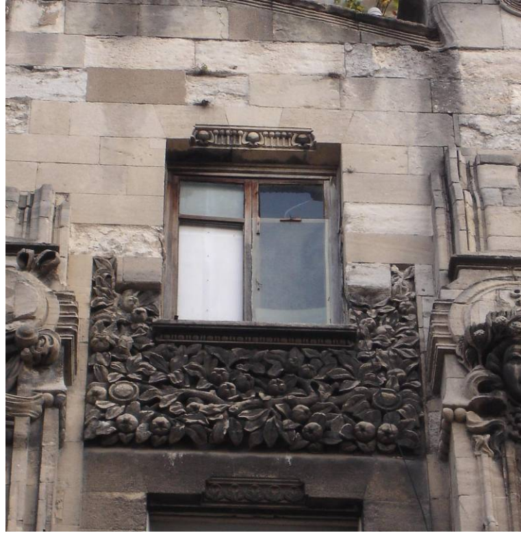
Resim 4.35 Botter apartmanında 4. kat pencere düzenlemesi
