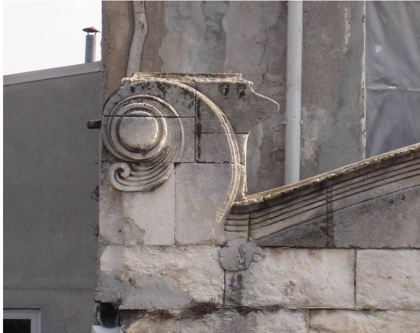
Resim 4.54 Botter apartmanının teras parapetindeki helezon biçimli düzenleme
