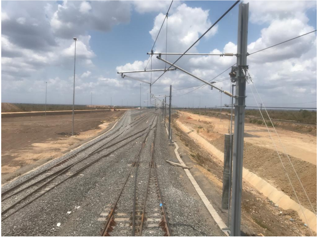
Görsel 2.3. Basıya konsol-hoban takımı saha uygulama örneği
