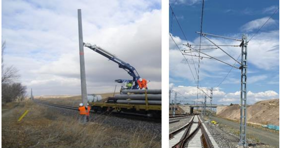
Görsel 2.1. Beton direk(sol), Çelik kafes direk(sağ)
