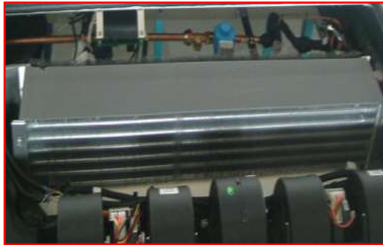
Şekil 2.11 Evaporatör ve radyal fan yerleşimi
