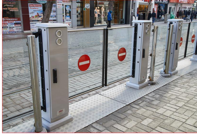
Şekil 3-6: Zemine kabartmalı boya uygulamaları, ışıklı ve sesli uyarı veren üniteler
