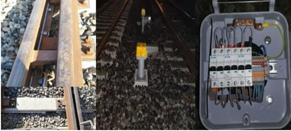
Resim 3.20. Makas ısıtıcı montajı
