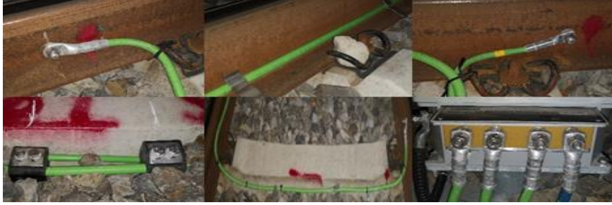
Resim 3.3. S-Loop bond ray devresi montajı
