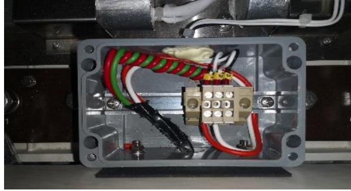
Resim 3.10. A-Tipi ray devresi iç terminasyonu
