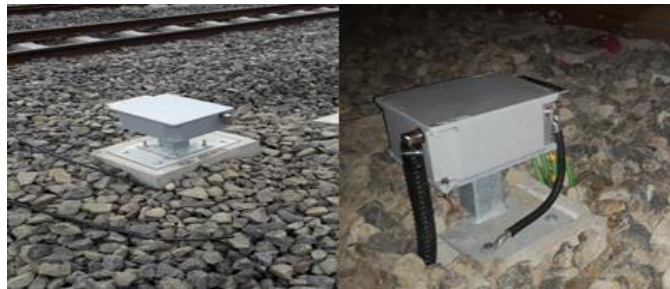
Resim 3.5. S-Loop ayar ünitesi montajı ve topraklaması
