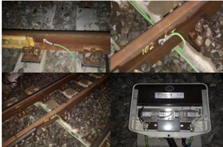
Resim 3.9. A-Tipi ray devresi bağlantısı
