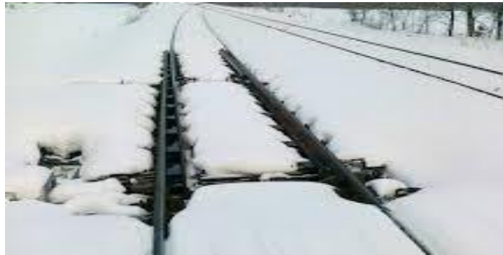
Resim 3.19. Makas ısıtıcı sistemi
