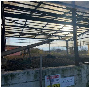
c. Atık su posa ayrıştırma alanı
