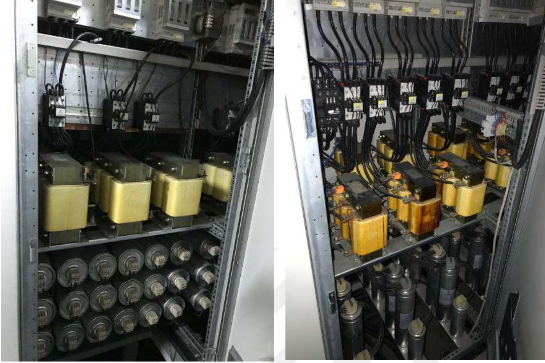
Şekil 7.61. Baskı fabrikasının kompanzasyon panosu görüntüsü
