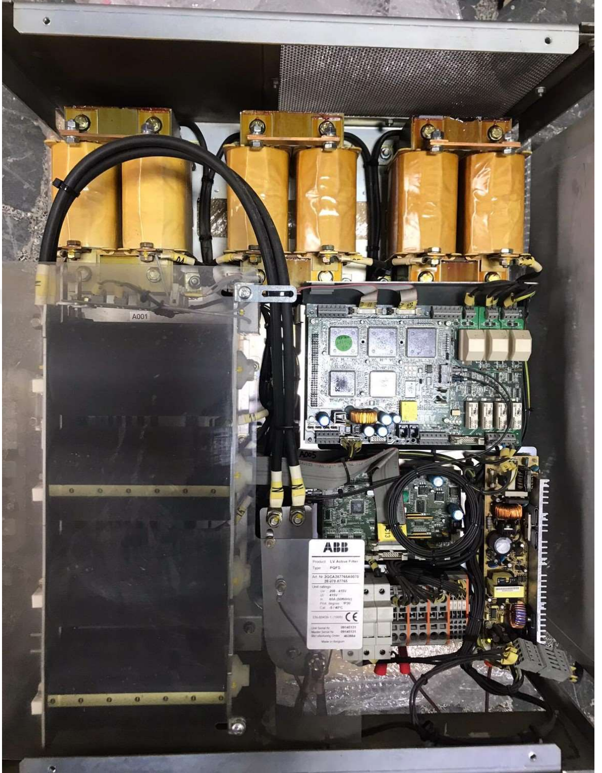
Şekil 5.16. Aktif filtre içyapısı
