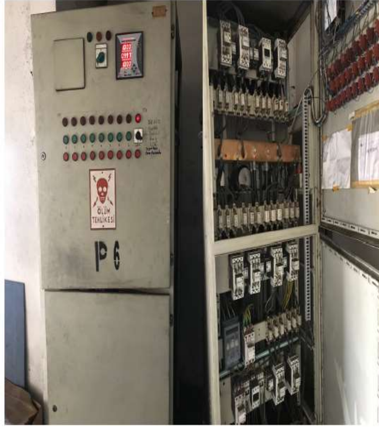
Şekil7.34. Plastik fabrikasının kompanzasyon panosu görüntüsü
