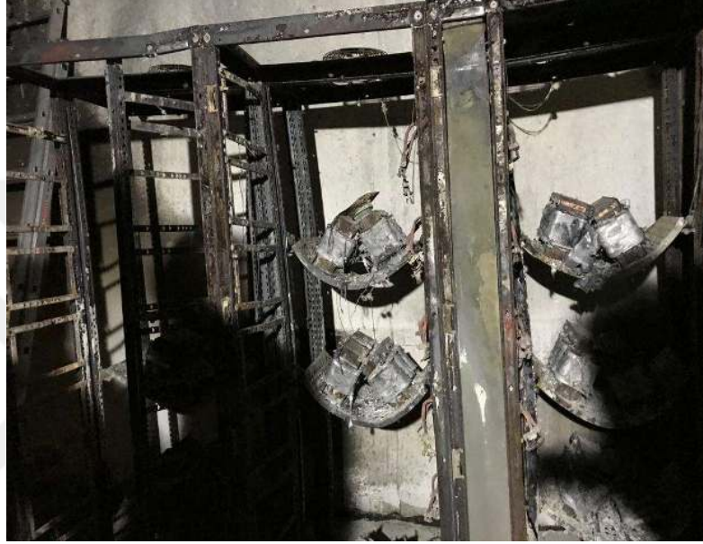
Şekil 7.5. ADP ve kompanzasyon panosunun yanmış hali
