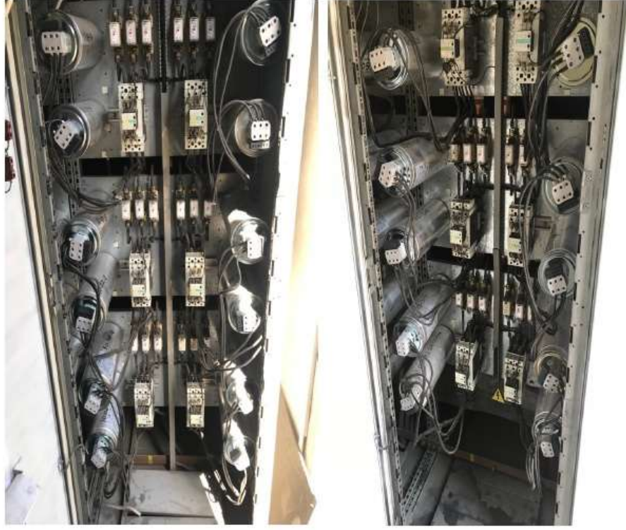
Şekil 7.8. Tekstil fabrikasının kompanzasyon panosu görüntüsü
