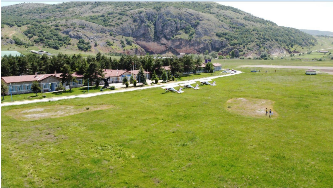
Görsel 3.9. Türk Hava Kurumu İnönü Havacılık Eğitim Merkezi (Araştırmacı tarafından 10.04.2022 tarihinde çekilmiştir).
