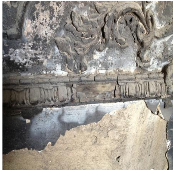
Şekil 4.16 : Yangından tahrip olan şömine, parkeler (solda) ve ahşap bezemeler.
