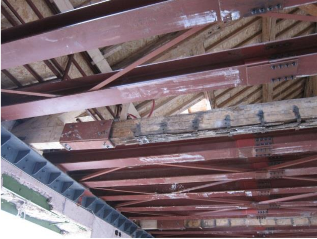
Şekil 4.38 : Taşıyıcı ahşap elemanların güçlendirilme uygulaması sonrası durumu.
