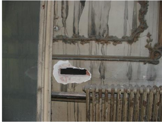
Şekil 4.21 : Metal elemanlarda ve kaloriferlerde korozyon ve çürüme.
