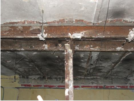
Şekil 4.21 : Metal elemanlarda ve kaloriferlerde korozyon ve çürüme.
