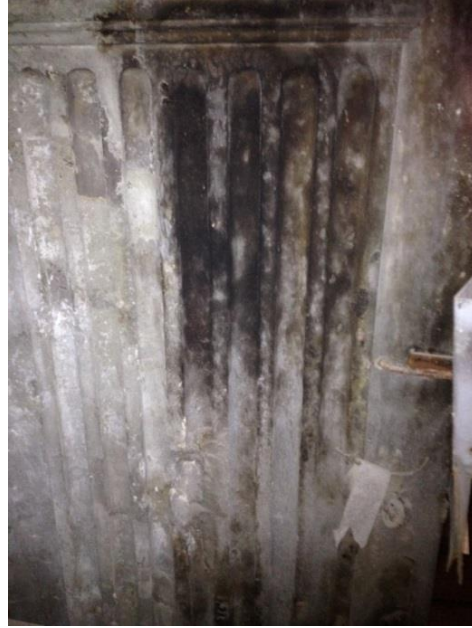
Şekil 4.6 : Mermer yüzeylerde kirlilik ve şekerlenme sebepli aşınmalar.
