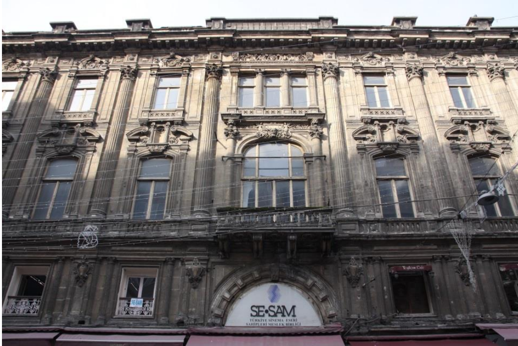
Şekil 4.3 : Serkl Doryan Binası ön cephe fotoğrafı.
