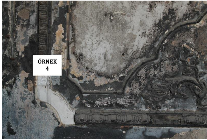
Şekil 4.27 : Alçı motif altındaki ahşap çıtanın yakından görünüşü (sağda) ve yapıdan alındığı yer (solda).
