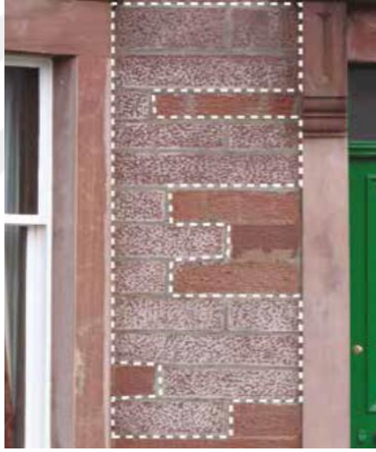
Şekil 2.21. Onarımdaki yüzeyin fazla çalışmasıyla elde edilen yamalı görünüm (Torney, 2016)
