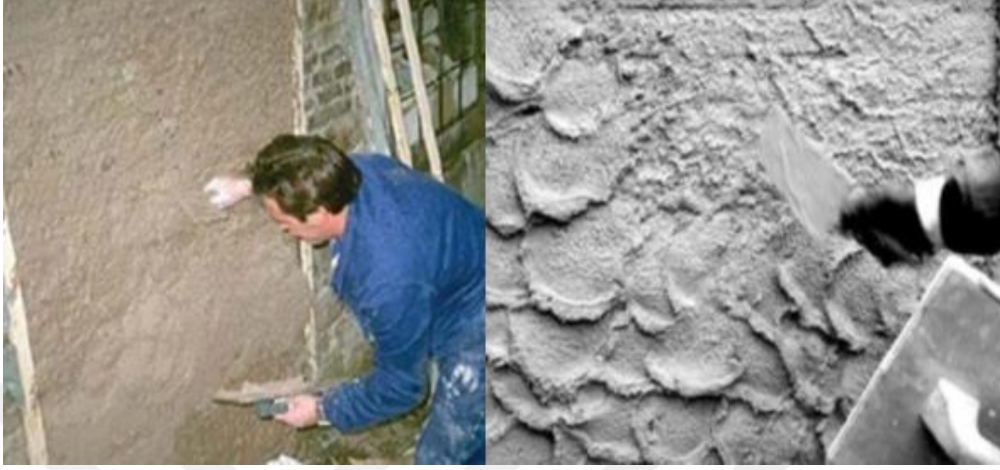
Şekil 2.12. Hidrolik kireç esaslı restorasyon harcının uygulama örneği (Seyhan, 2007; URL-5, 2021)
