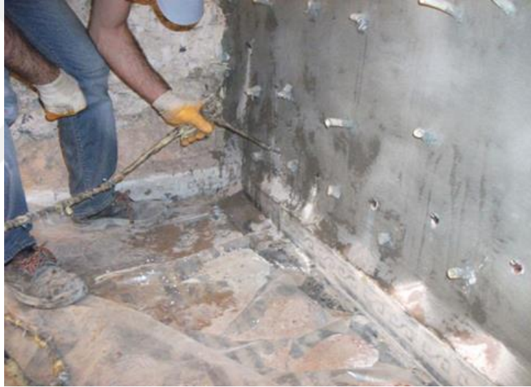
Şekil 2.14. Enjeksiyon restorasyon harcının uygulama örneği (URL-7, 2021)
