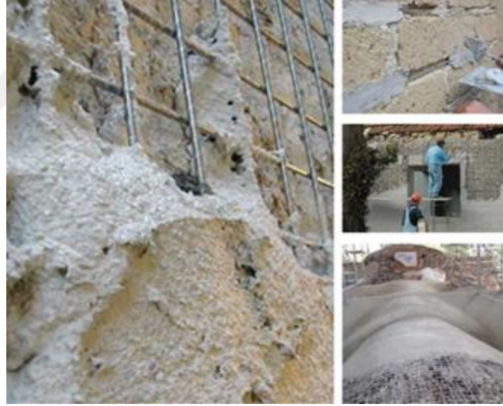
Şekil 2.13. Pozolanik kireç esaslı onarım restorasyon harcının uygulama örneği (URL-6, 2021)
