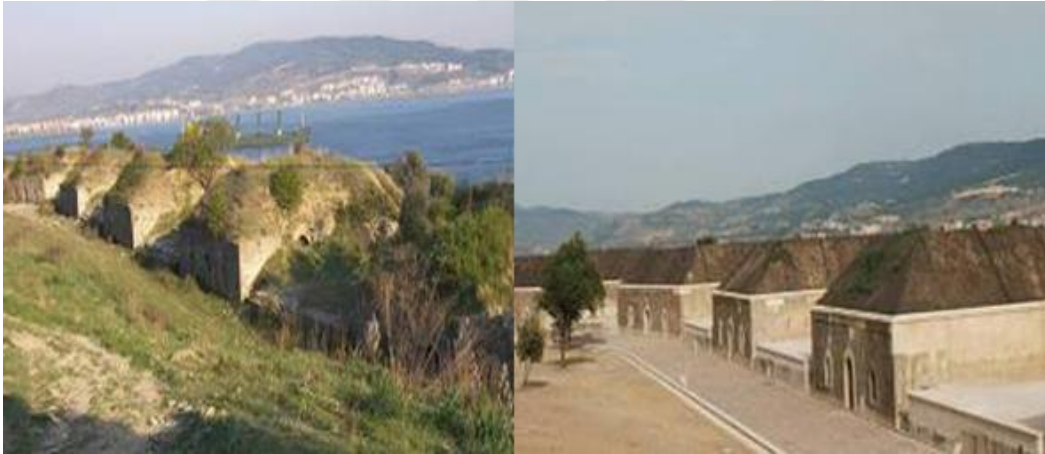
Şekil 2.7. Çanakkale Rumeli Mecidiye Tabyası projelendirilmesi ve restorasyonu (URL-4, 2018)
