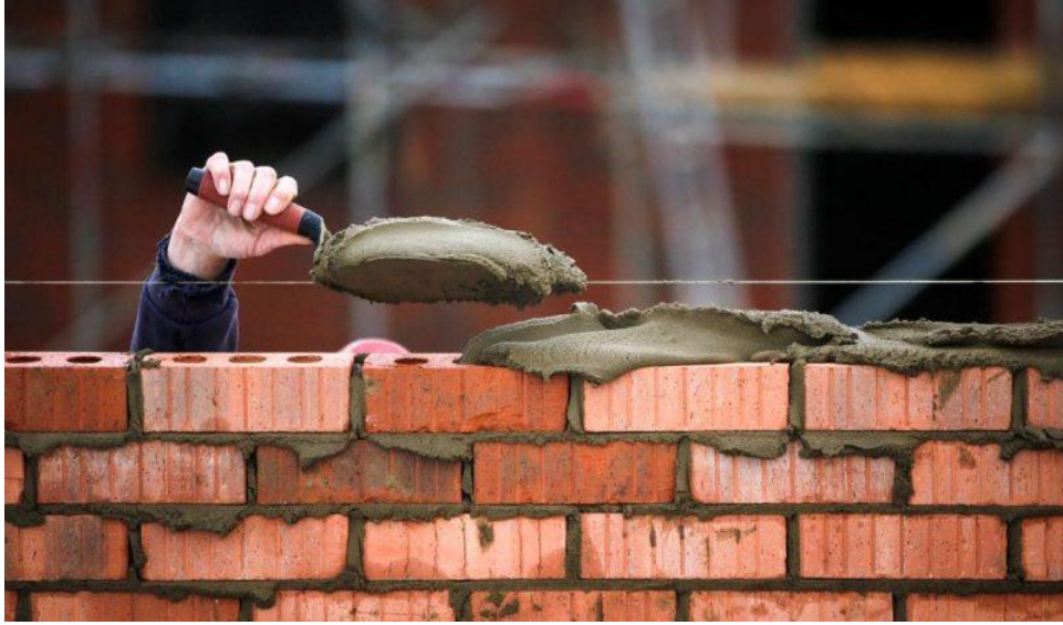
Şekil 2.1. Duvar örülmesi sırasında harç uygulaması (URL-1, 2019)
