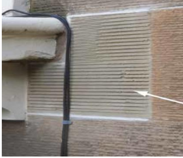
Şekil 2.18. Onarımdaki yüzey örneği (Torney, 2016)
