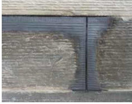
Şekil 2.20. Restorasyon harcının uyumsuz görünümü (Torney, 2016)
