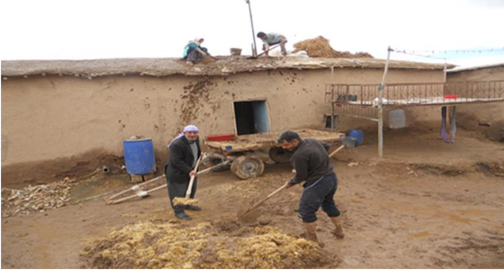
Şekil 2.2. Kerpiç evlerde çamur harcı kullanımı (URL-2, 2019)
