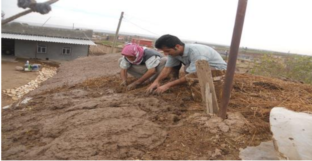
Şekil 2.3. Kerpiç evlerde çamur harcı kullanımı (URL-2, 2019)
