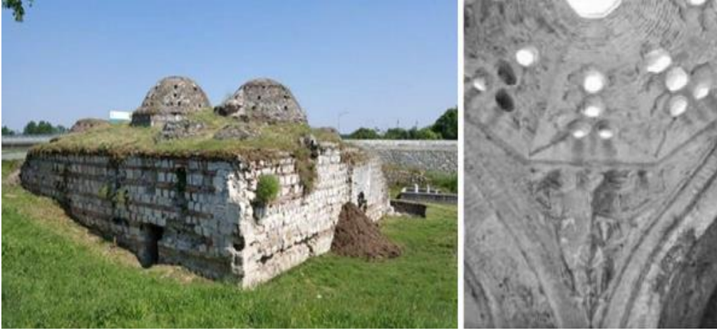
Şekil 2.5. Edirne Gazi Mihal Hamamı ve kubbelerinde kullanılan horasan sıva (Kılıç, 2007)
