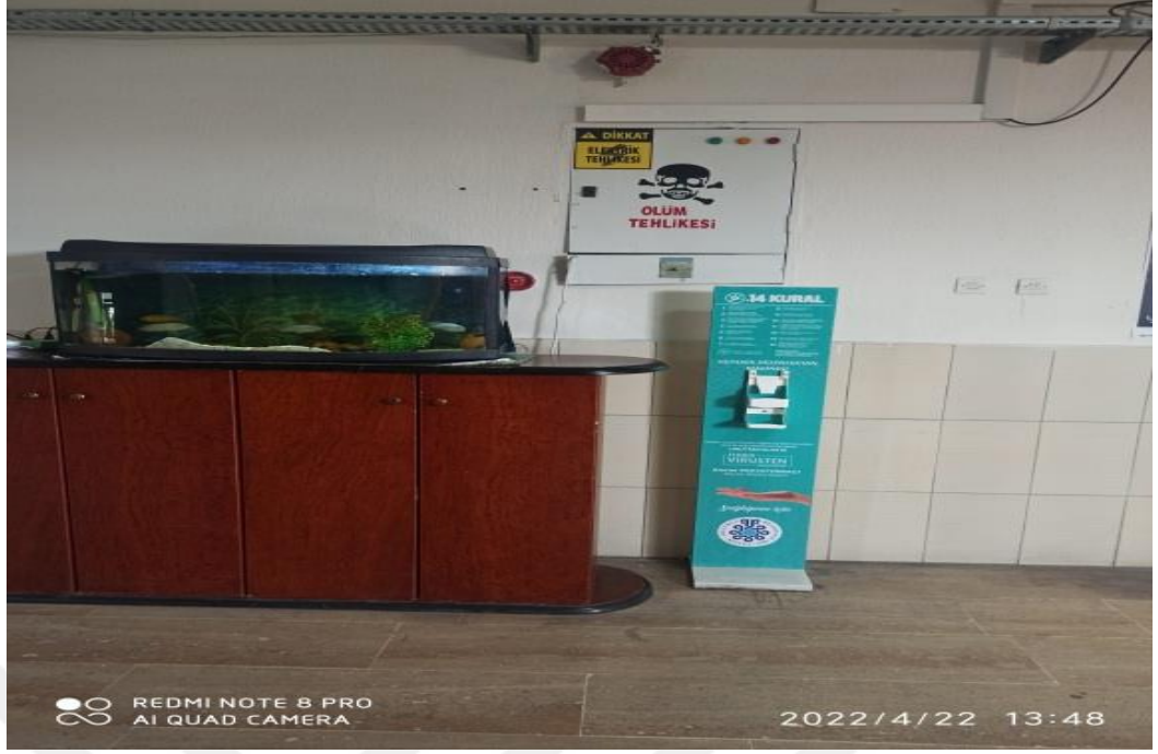
Şekil 4.3. Elektrik pano önlerinin engellenmesi.
