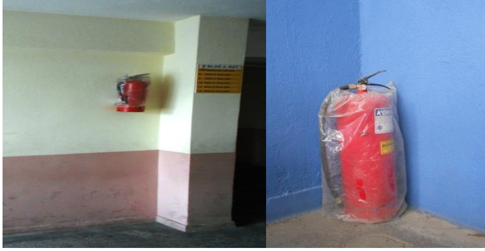
Şekil 4.13. Yangın tüplerinin asılma hizası yerden çok yüksekte veya yerde.
