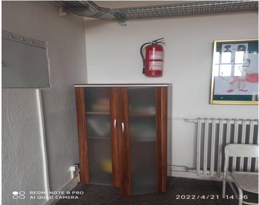
Şekil 4.3. Elektrik pano önlerinin engellenmesi.
