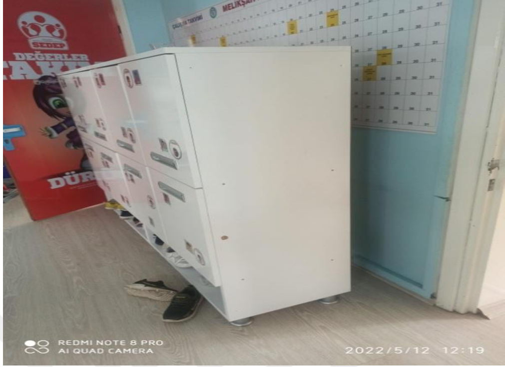
Şekil 4.38. Koridorlardaki dolapların sabitlenmemesi.
