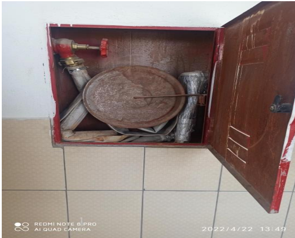
Şekil 4.5. Yangın sisteminin aktif olmaması.
