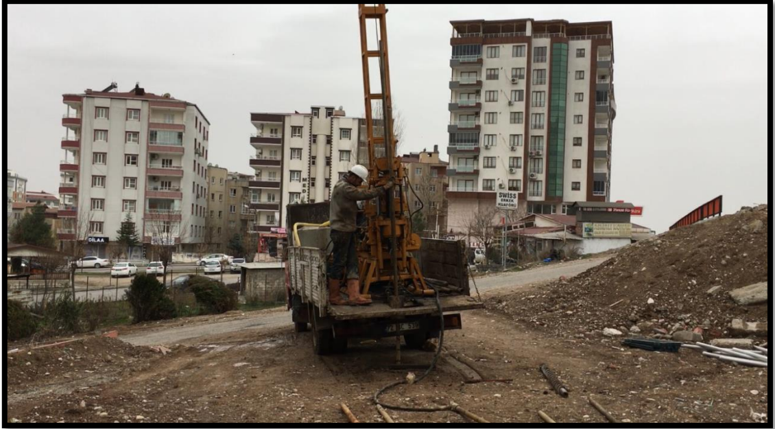
Şekil 5.12. İnceleme alanında yapılan sondaj çalışmaları
