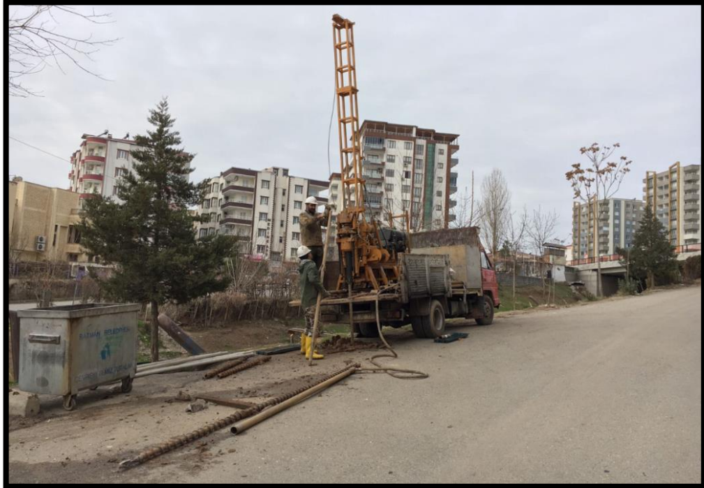
Şekil 5.13. İnceleme alanında yapılan sondaj çalışmaları
