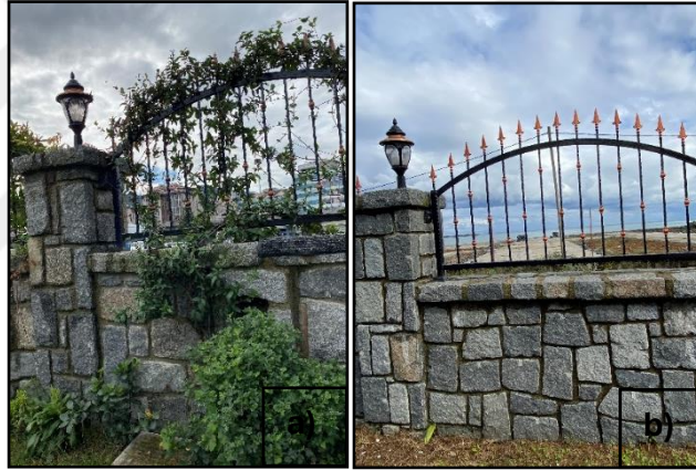
Şekil 10. Alandaki sınır duvarlarına ait görseller (a. duvar, b. örme duvar)
