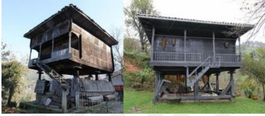
Şekil 18. Karma yapı sistemine örnek serenderler (Felek, 2020)
