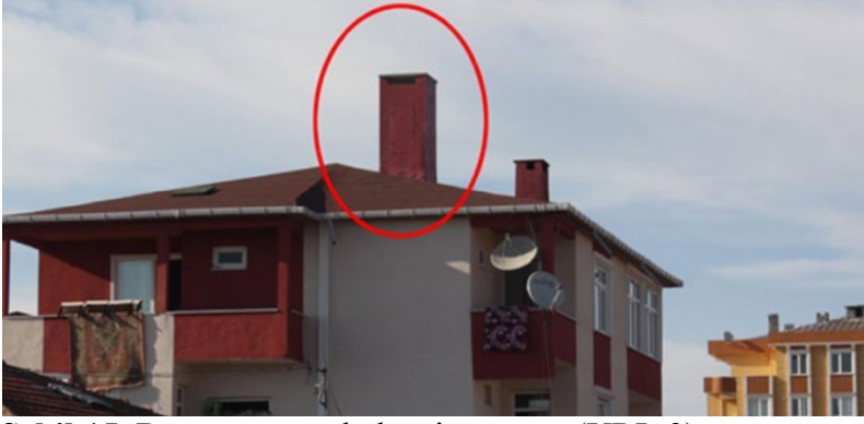
Şekil 15. Baca görünümlü baz istasyonu (URL-3)
