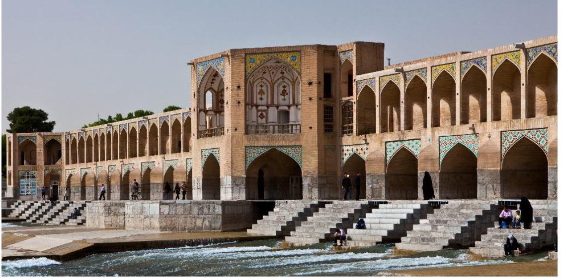
Görsel 2 : Khaju Köprüsü 17. YY İsfahan, İran
