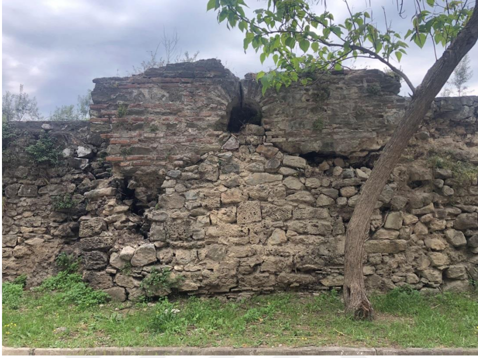
Resim 23: Su terazisi kuzey cephesi
