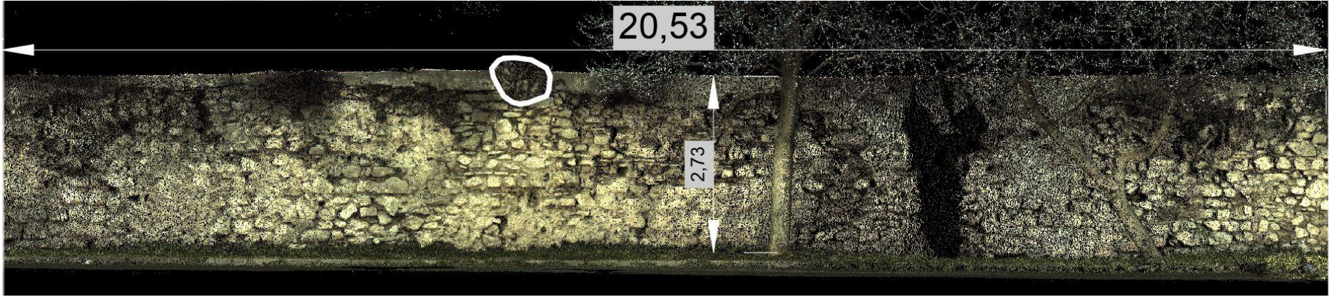
Resim 60: Lafke Kapı su kemerinde mevcut durum
