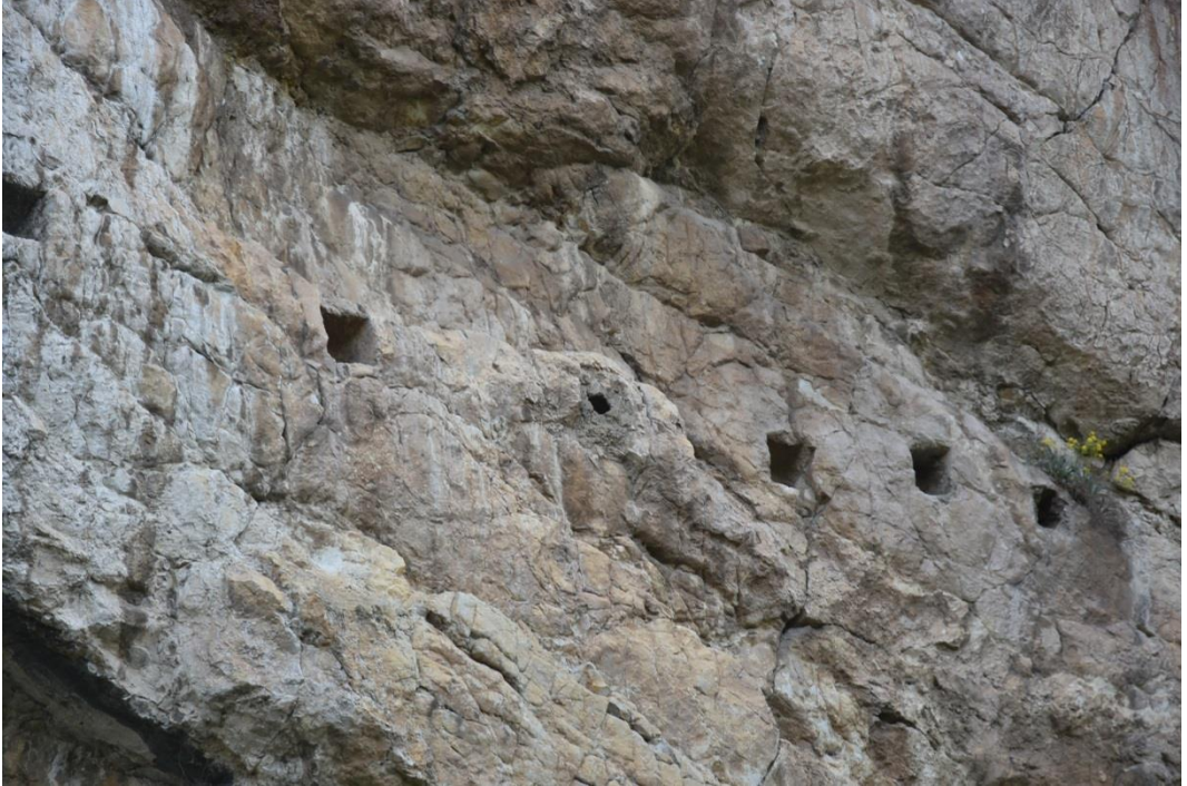
Resim 8: Dırazali Mahallsei, Baraj Mevki’inde bulunan hatıl delikleri (Bursa ve İlçeleri Kültür Envanteri Projesi Arşivi)
