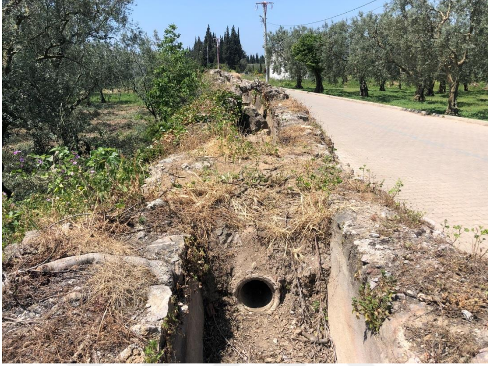
Resim 21: Specusa eklenen beton boru
