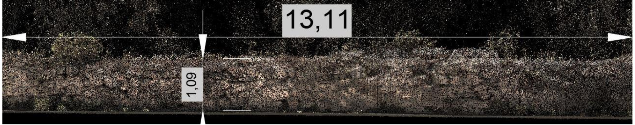
Resim 31: Lafke Kapı su kemerinde mevcut durum
