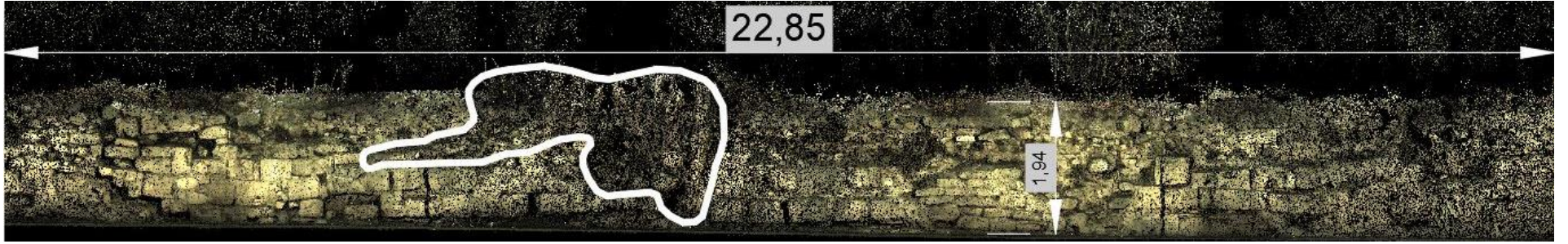
Resim 48: Lafke Kapı su kemerinde mevcut durum
