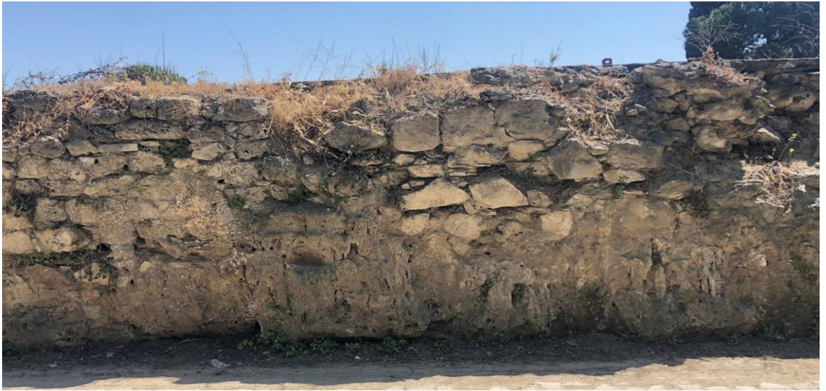
Resim 4: Su kemeri duvarlarındaki kireç tabakaları
