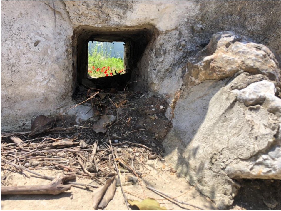
Resim 22: Specus duvarında köylüler tarafından kaçak su alımı için açılan kare delik
