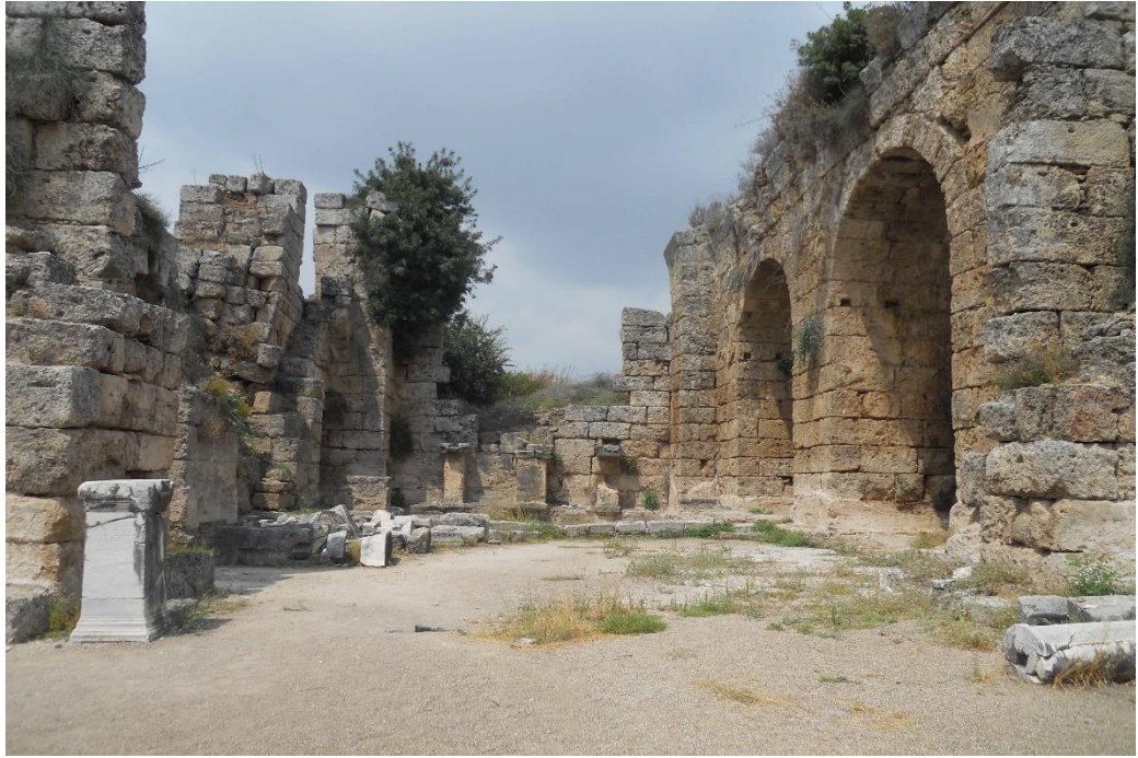
Görsel 35: Perge Güney Hamam VIII no'lu Mekân. Doğudan Görünüş
