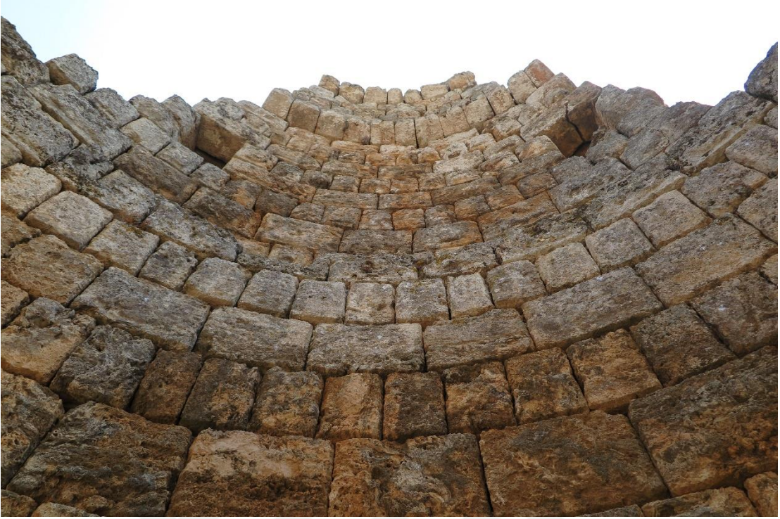
Görsel 12: Batı Kuleinin İçerisinden İsodomik Duvar Örgü Tekniği Görünümü
