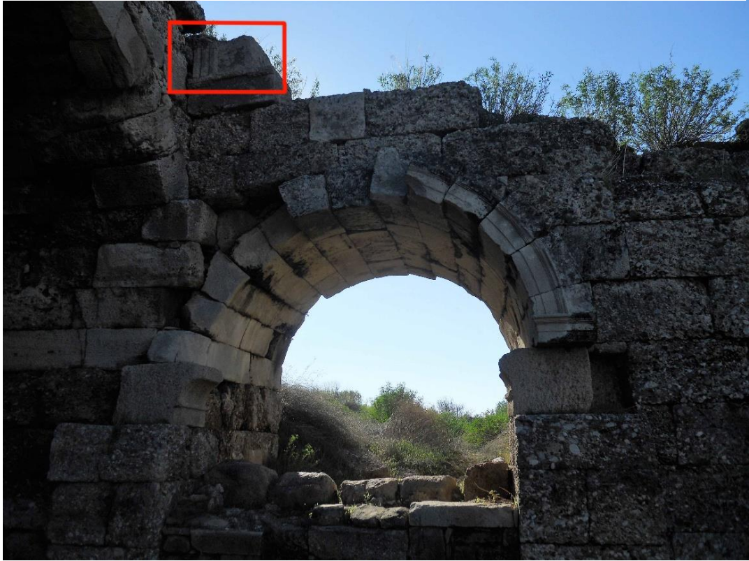
Görsel 47: Side Doğu Kapısı. Güneydoğu Köşedeki Saçaklığa Ait İnsitu Blok
