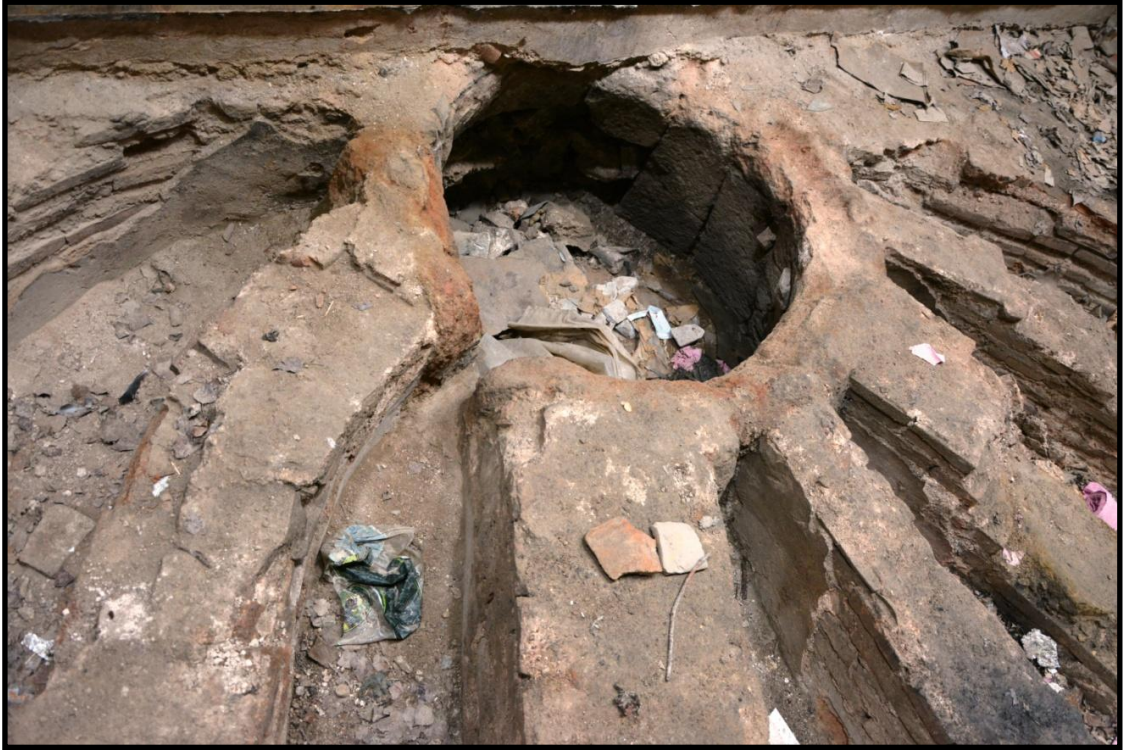
Foto 515. Mecidiye-Karasu Abdülmecid Hamamı'nın Sıcaklık Bölümündeki Kazanın Oturduğu Özel Bölüm
