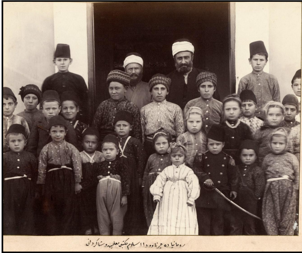
Foto 32. Karasu (Çernavoda) İslam Mektebi Muallimin ve Şakirdanı
