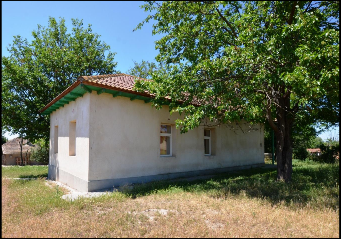
Foto 373. Siliştea (Taşpınar) Köyü Camii'nin Güneydoğu Cephesi
