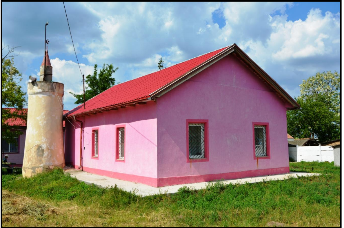
Foto 287. Ciocarla De Sus (Küçük Bülbül) Köyü Camii'nin Güneybatı Cephesi
