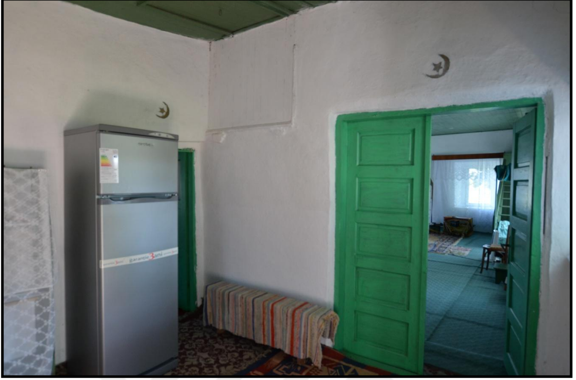
Foto 132. Moşneni (Pervel) Köyü Camii Harime Geçiş Mekânı
