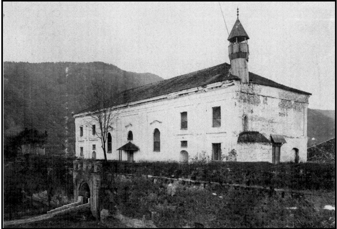
Foto 4. Ada Kale Camii Onarım Sonrasındaki Durumu
