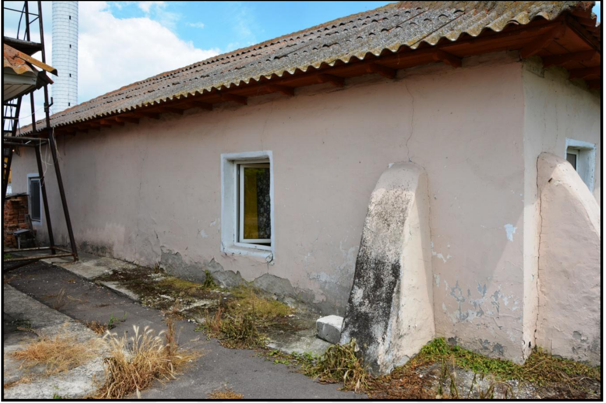
Foto 340. Valu Lui Traian (Asana-Hasanlar) Köyü Camii'nin Batı Cephesi
