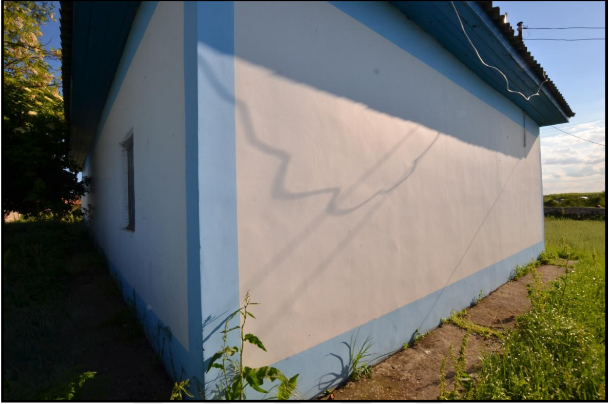
Foto 354. Osmancea (Osman Fakih-Osmança) Köyü Camii'nin Kuzeydoğu Cephesi
