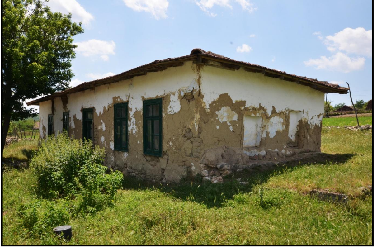
Foto 365. Abrud Köyü Camii'nin Kuzeydoğu Cephesi
