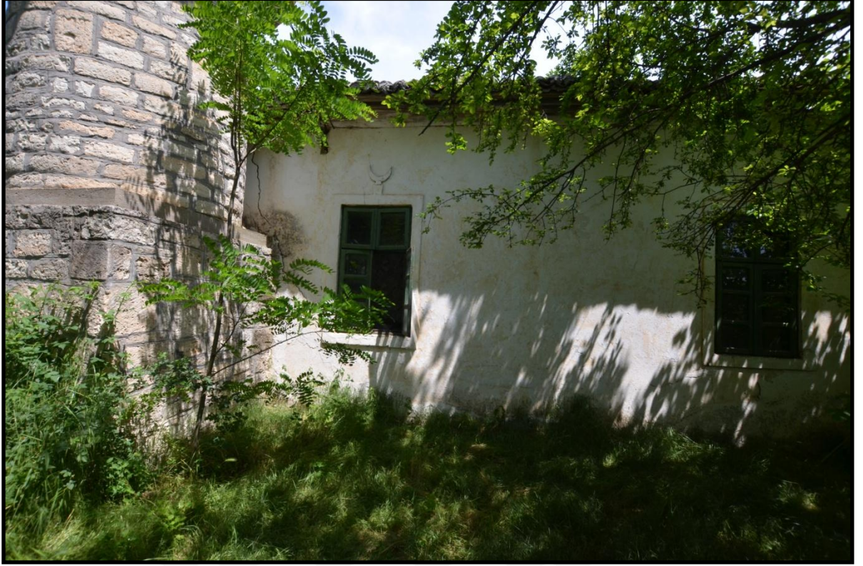
Foto 324. Cotu Vaii (Kırağı-Kiracı) Köyü Camii'nin Batı Cephesi
