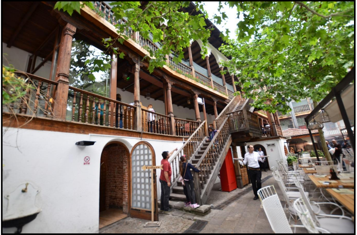
Foto 498. Bükreş Manuk Han'ın Avlu İçi Kuzey Cephesi
