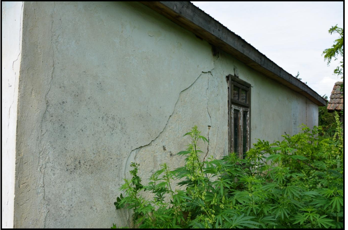
Foto 420. Baraganu (Osmanfakı) Köyü Camii'nin Doğu Cephesi
