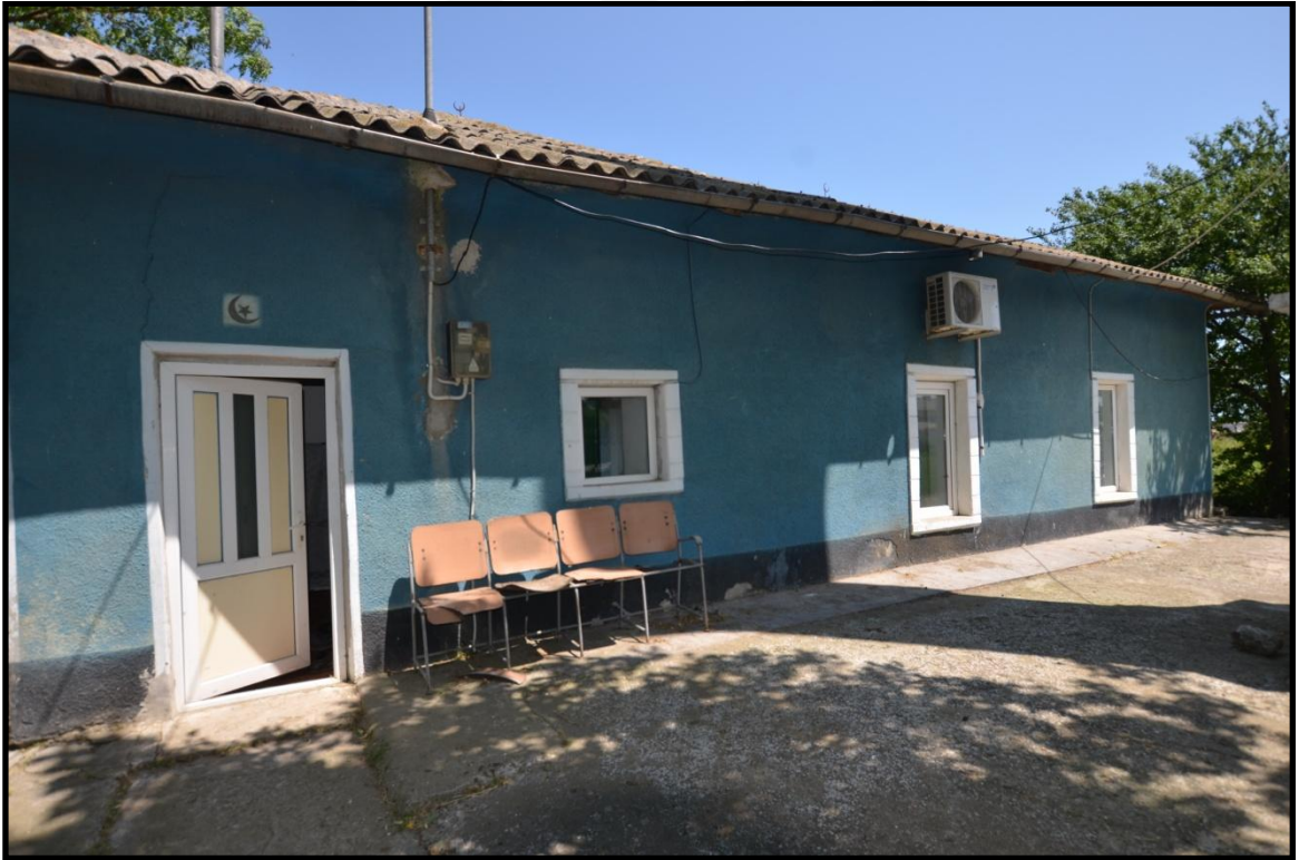
Foto 131. Moşneni (Pavel) Köyü Camii'nin Batı Cephesi
