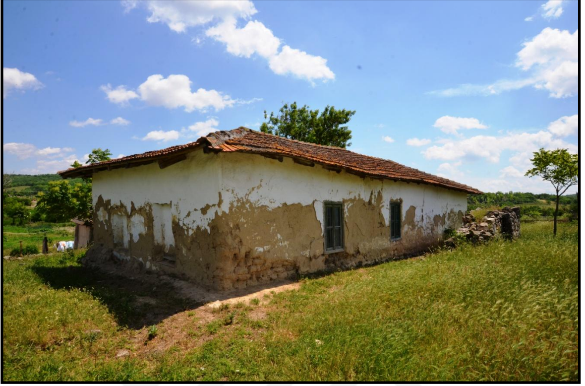
Foto 364. Abrud Köyü Camii'nin Kuzeybatı Cephesi
