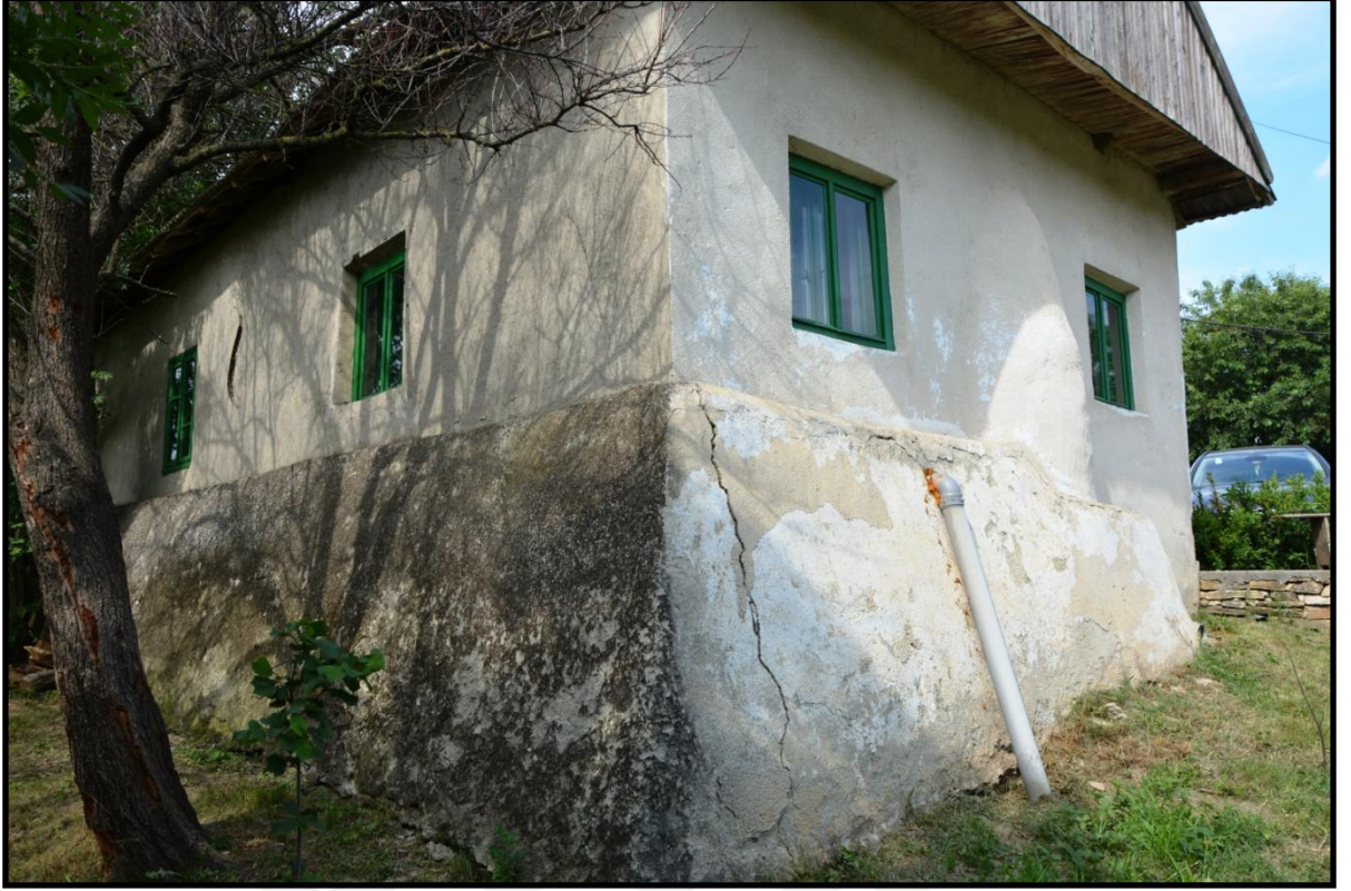
Foto 425. Ciucurova (Çukurova) Köyü Camii'nin Güneybatı Cephesi
