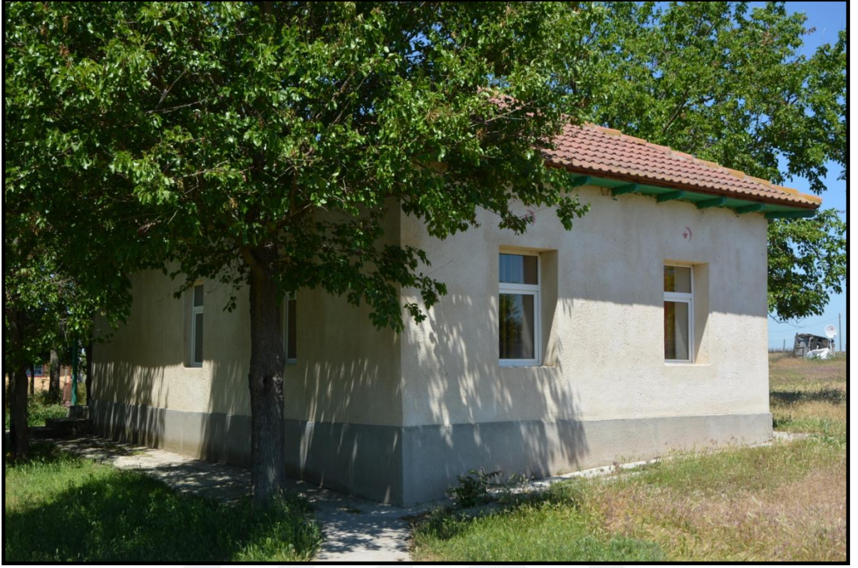
Foto 372. Siliştea (Taşpınar) Köyü Camii'nin Güneybatı Cephesi
