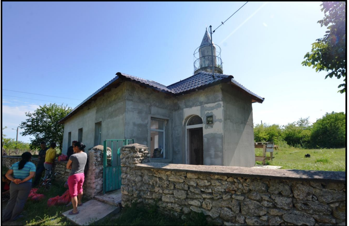
Foto 125. Hagieni (Hacılar) Köyü Camii'nin Kuzeydoğu Cephesi
