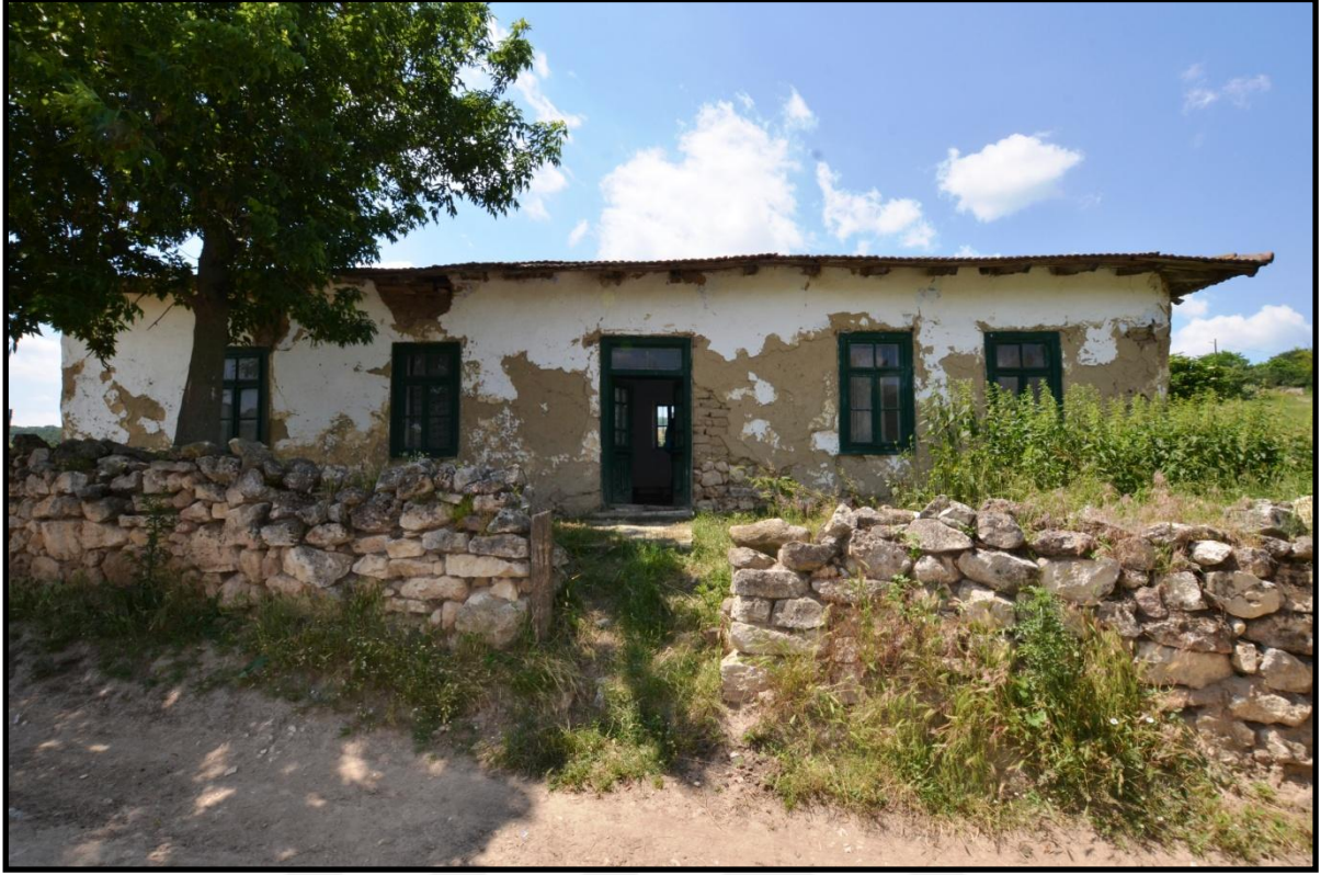
Foto 362. Abrud Köyü Camii
