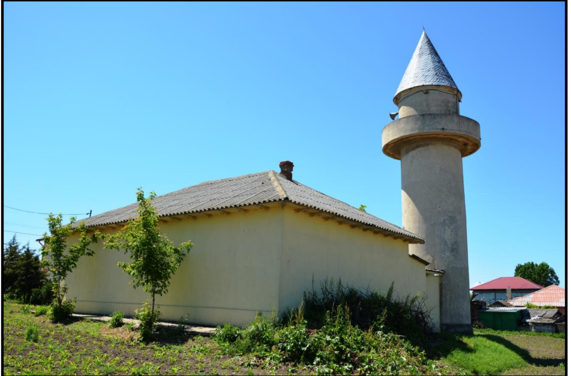
Foto 313. Agigea-Acica (Aziziye) Köyü Camii'nin Kuzeydoğu Cephesi
