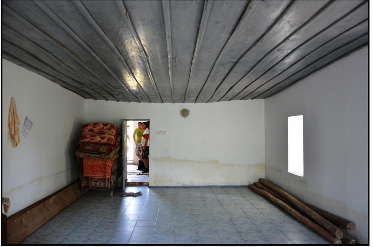
Foto 296. Gherghina (Defçe) Köyü Camii Kuzey Duvarı
