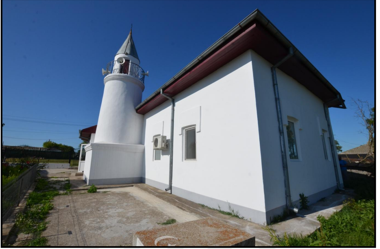
Foto 358. Dulcești (Küçük Tatlıcak) Köyü Camii'nin Güneybatı Cephesi
