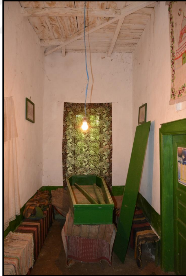
Foto 327. Cotu Vahi (Kırağı-Kiracı) Köyü Camii'nin Harime Geçiş Koridoru
