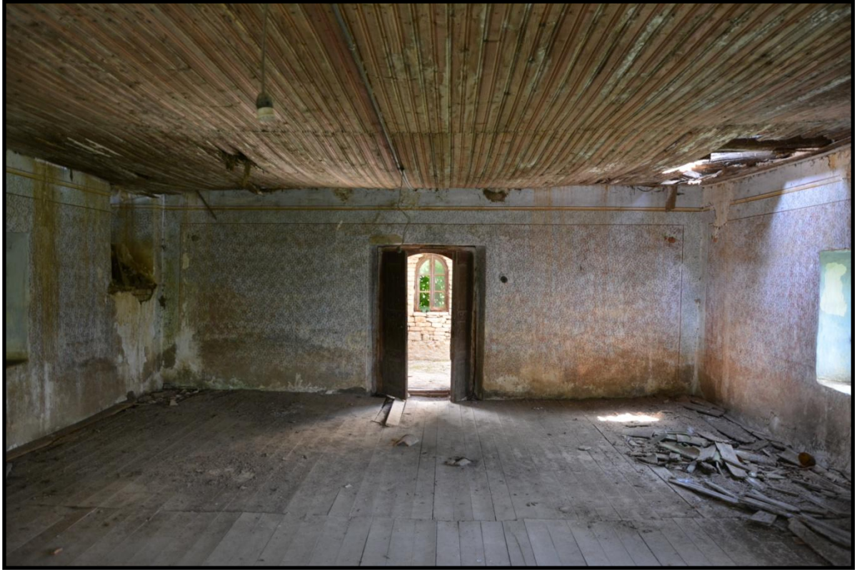
Foto 219. Albești (Akbaş) Köyü Camii Kuzey Duvarı
