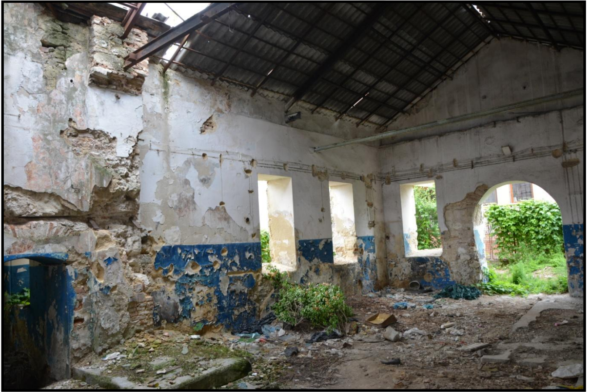
Foto 509. Mecidiye-Karasu Abdülmecid Hamamı Soyunmalık Bölümünün Güneydoğu Duvarı
