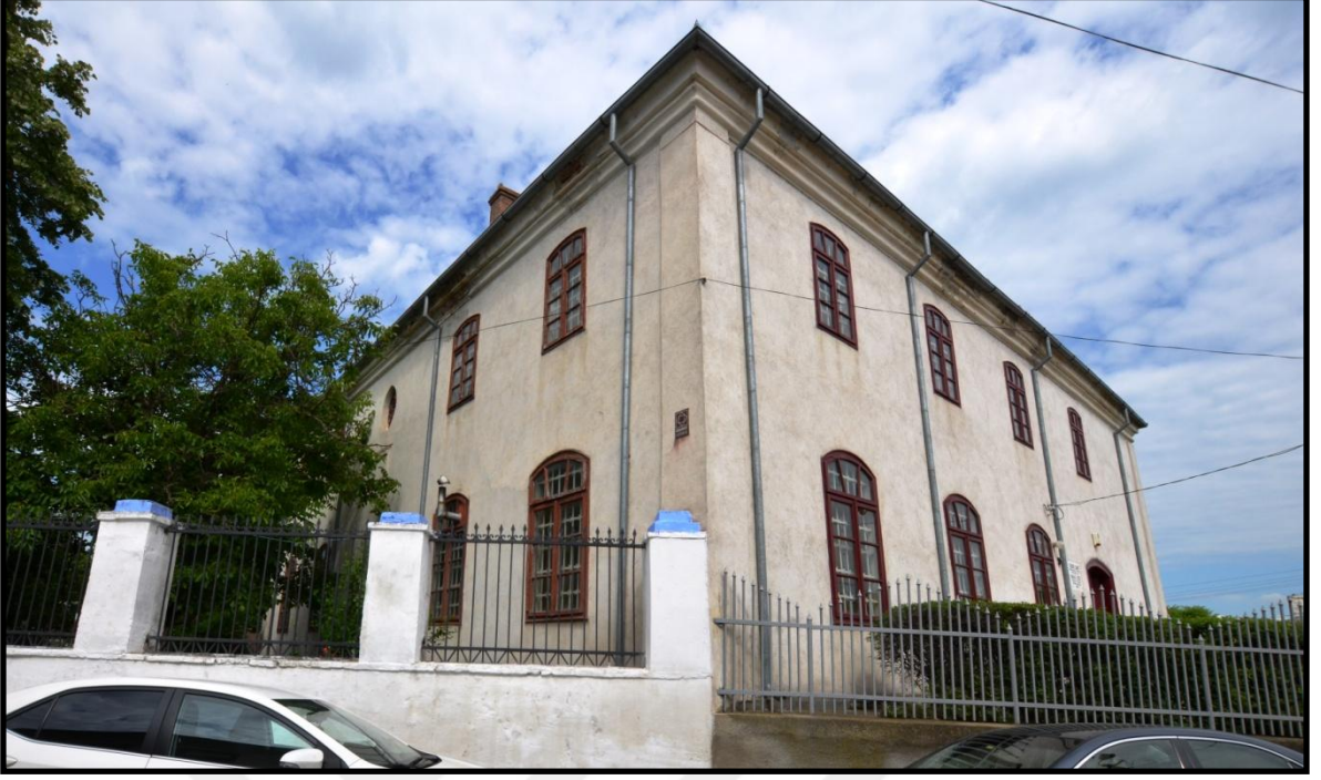
Foto 190. Tulça Aziziye Camii'nin Güneydoğu Cephesi
