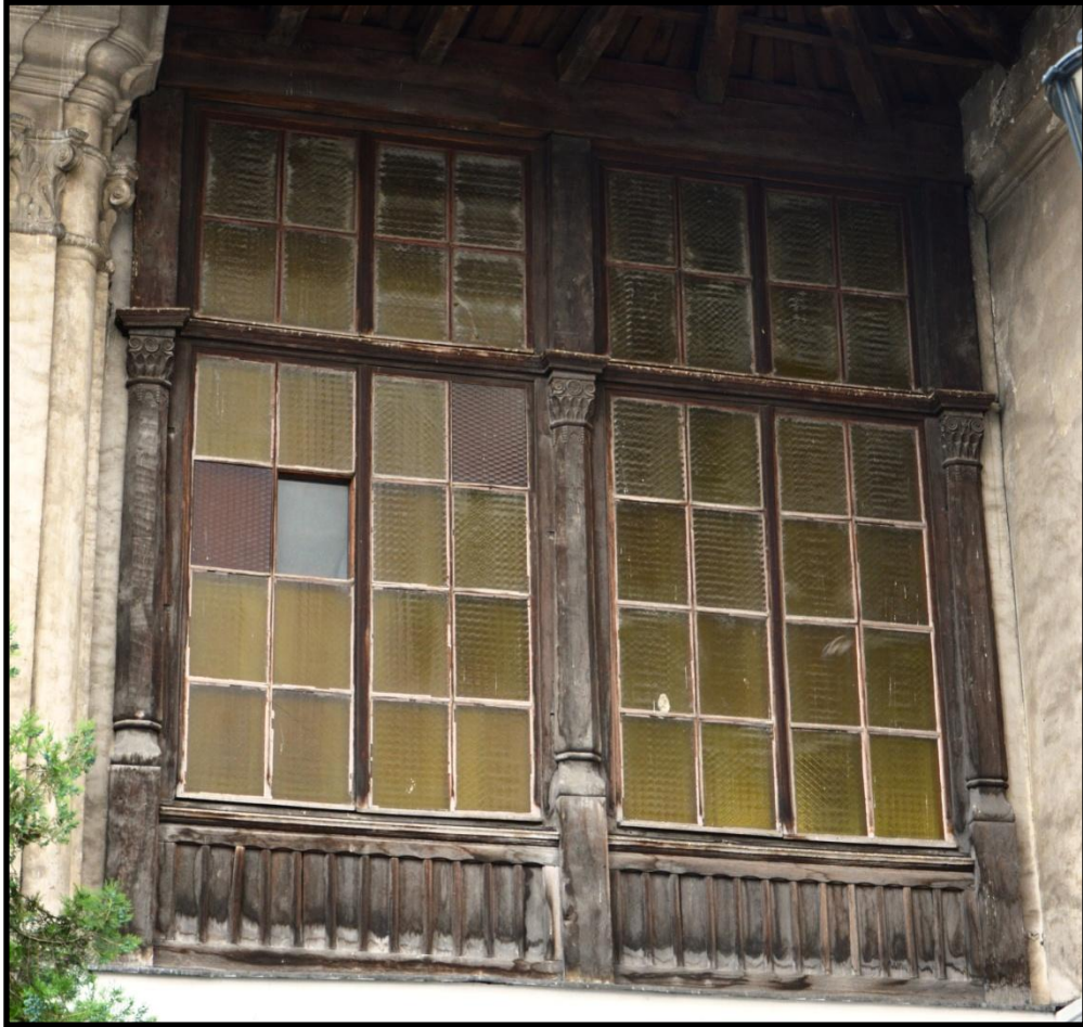
Foto 490. Bükreş Manuk Han'ın Kuzey Kanadının Güney Köşesindeki Camekân
