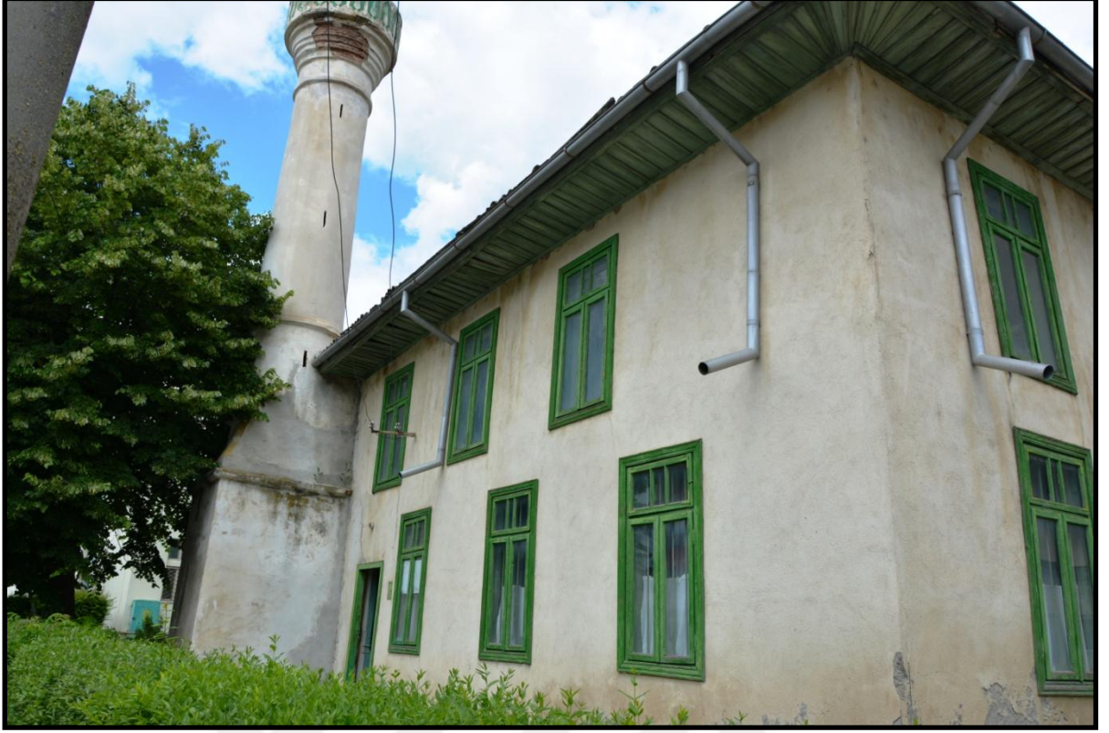
Foto 202. İshakça Mahmud Yazıcı Camii'nin Batı Cephesi
