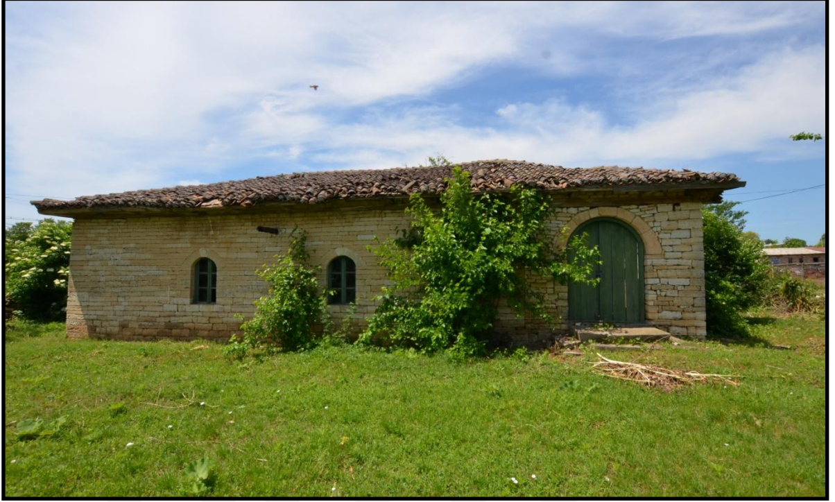
Foto 214. Albești (Akbaş) Köyü Camii'nin Doğu Cephesi
