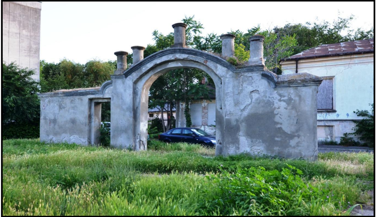
Foto 504. Galati (Kalas) Türk Han Kapısı'nın Batı Cephesi
