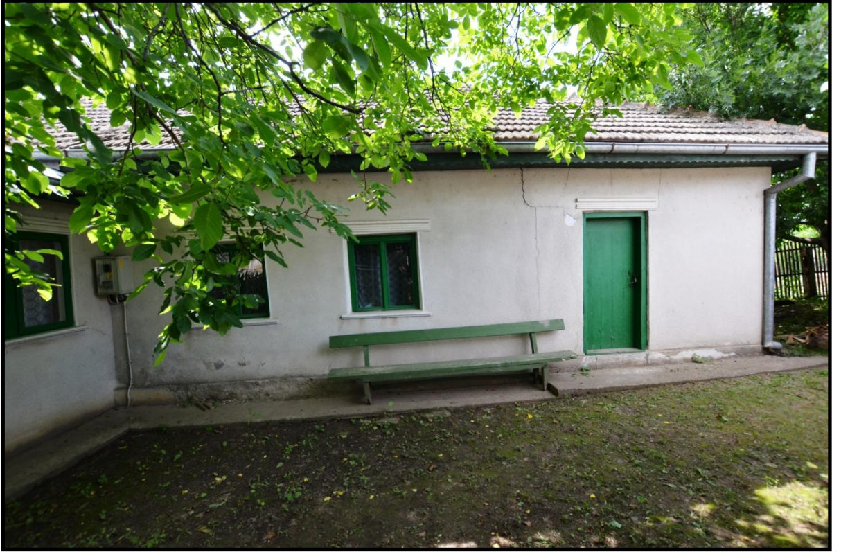
Foto 426. Ciucurova (Çukurova) Köyü Camii'nin Doğu Cephesi
