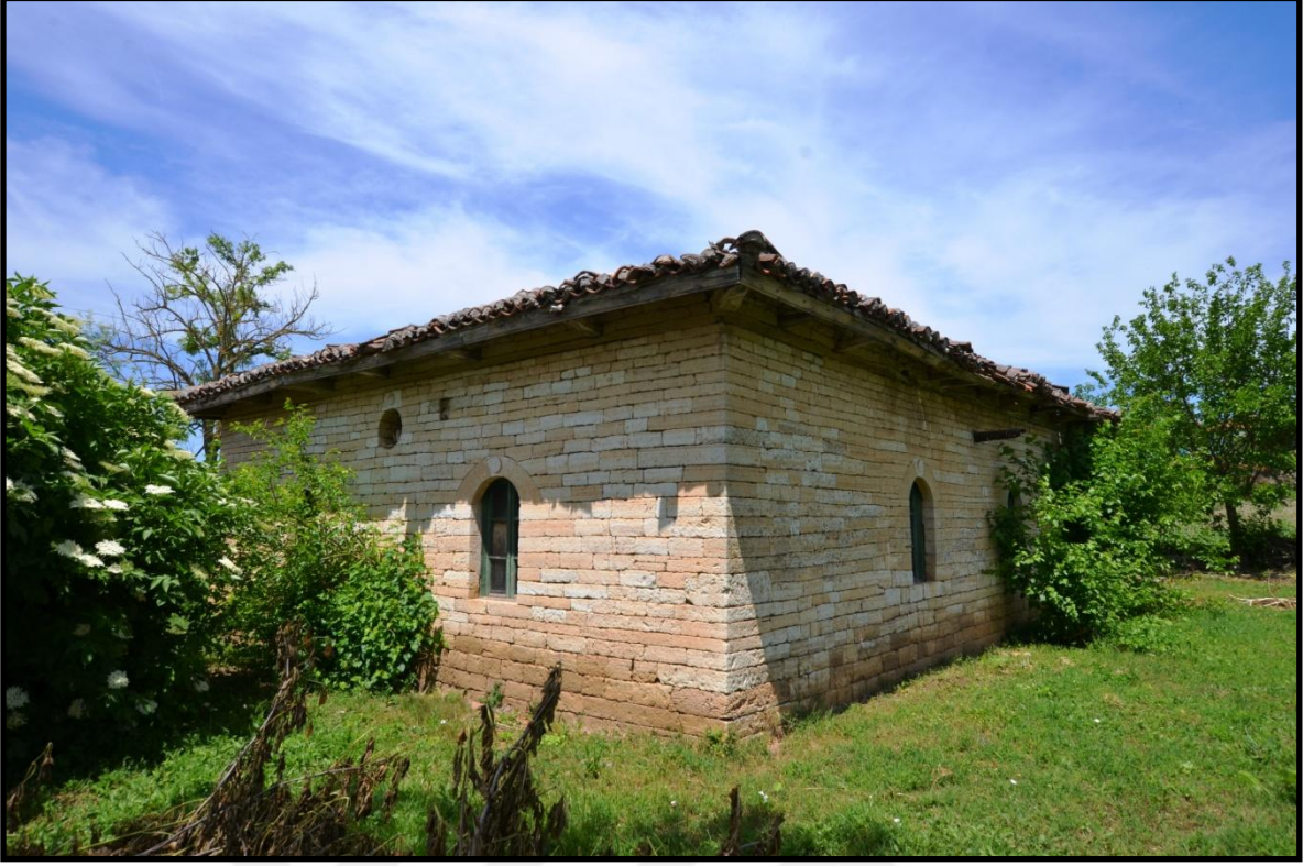
Foto 212. Albeşti (Akbaş) Köyü Camii'nin Güneydoğu Cephesi
