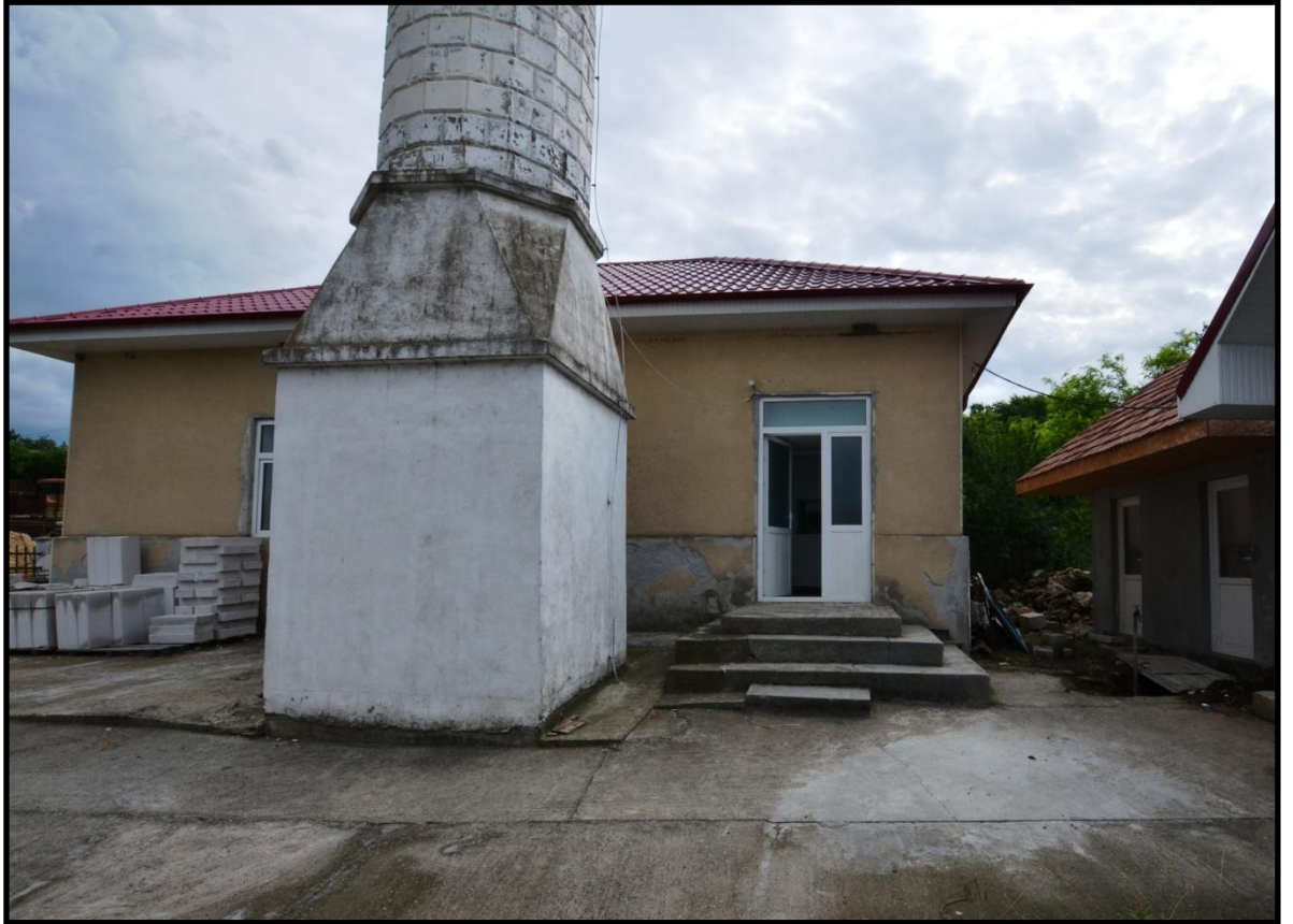
Foto 273. Independenta (Bayramdede) Köyü Camii'nin Doğu Cephesi
