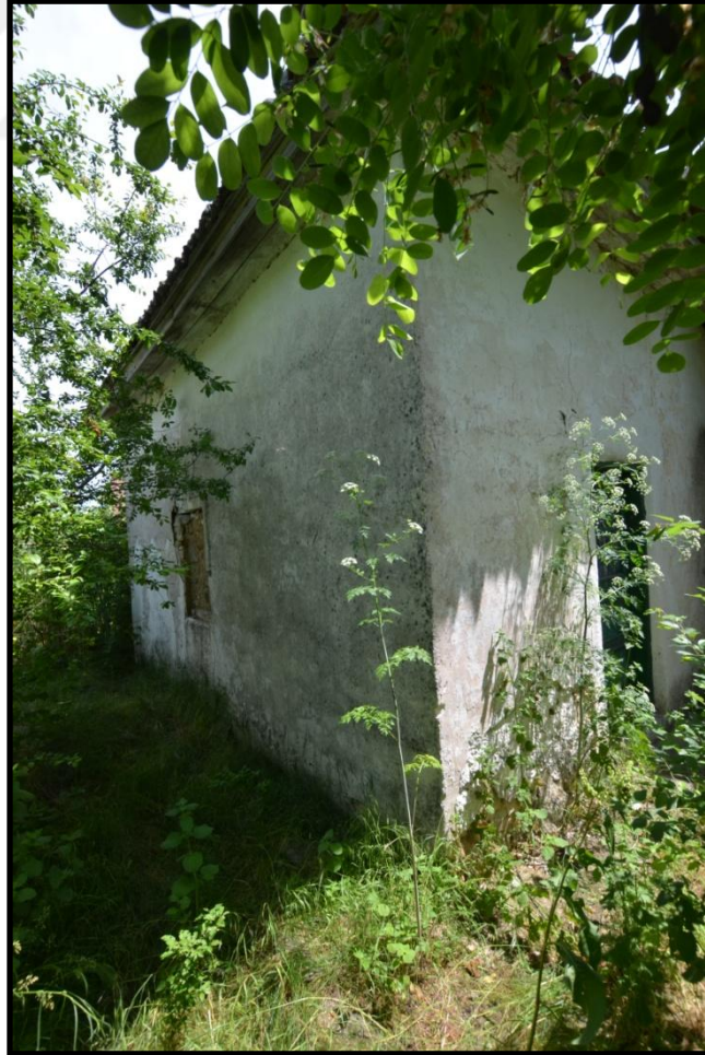
Foto 325. Cotu Vaii (Kırağı-Kiracı) Köyü Camii'nin Kuzeybatı Cephesi
