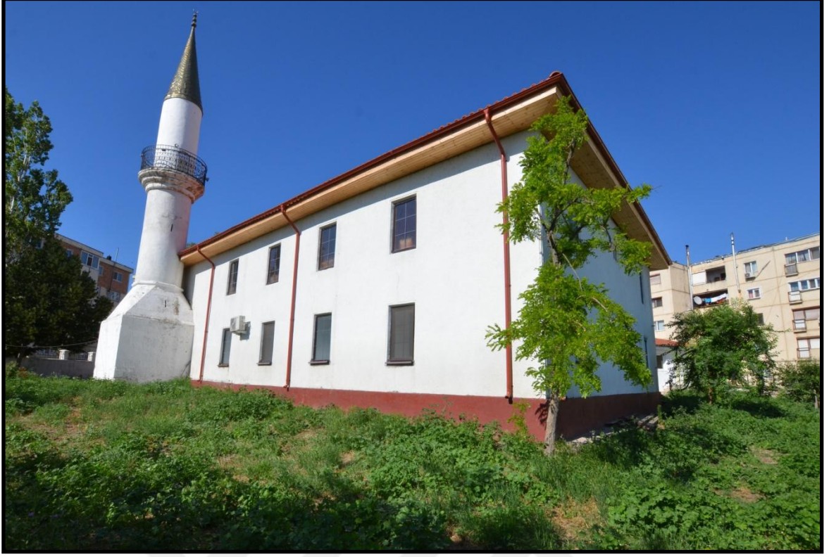
Foto 86. Hırşova Sultan Mahmud Camii Güneybatı Cephe
