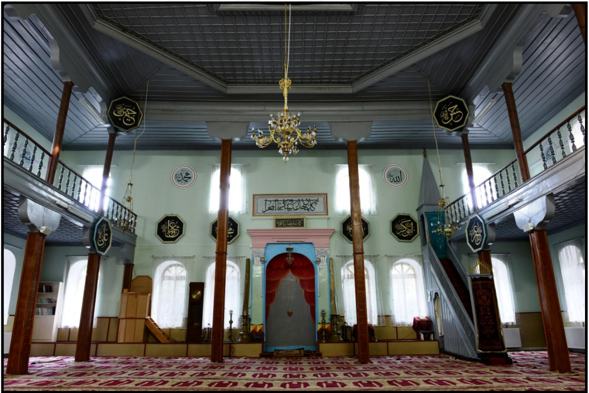
Foto 182. Mecidiye-Karasu Abdülmecid Camii Güney Duvarı
