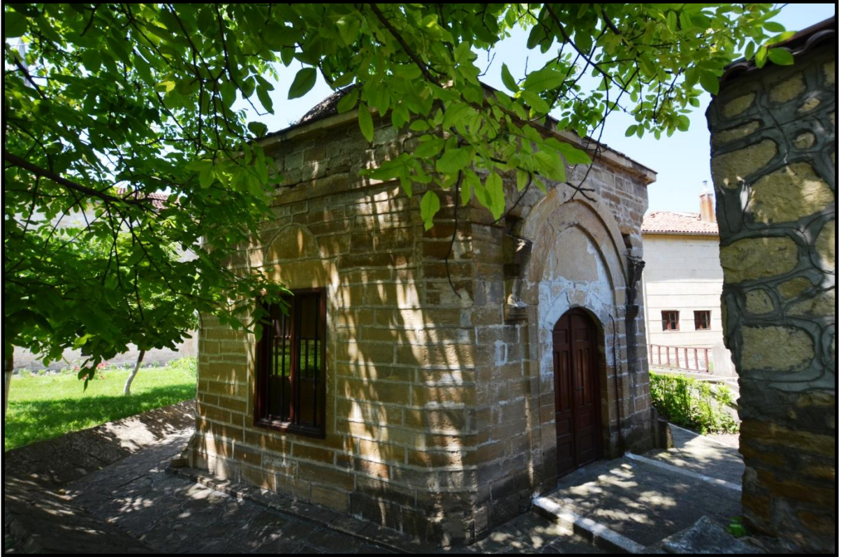
Foto 432. Babadağ Gazi Ali Paşa Türbesi'nin Güneydoğu Cephesi
