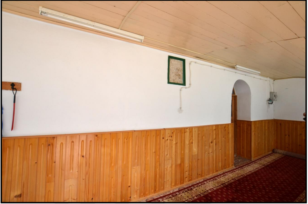
Foto 260. Tuzla Köyü Camii'nin Doğu Cephesinin Kuzey Köşesindeki Harime Giriş Kapısı
