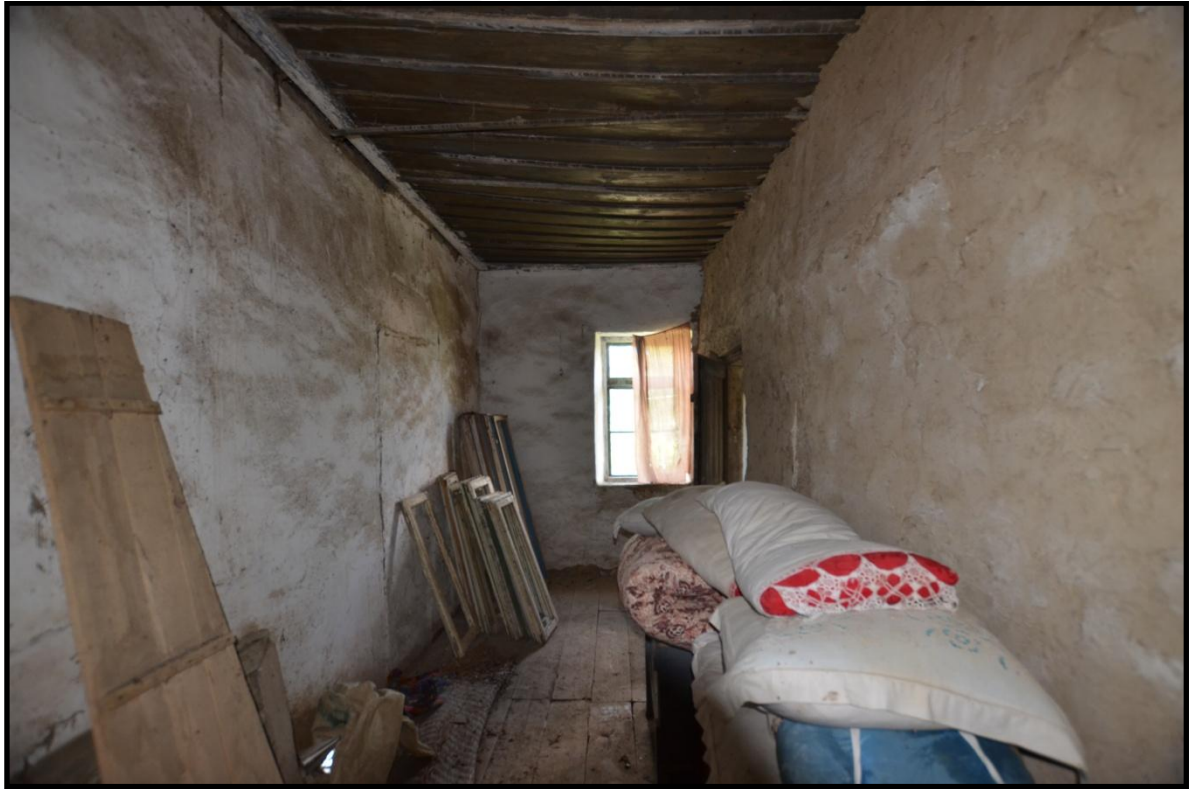
Foto 367. Abrud Köyü Camii'nin Kuzeyindeki Depo Olarak Kullanılan Mekan
