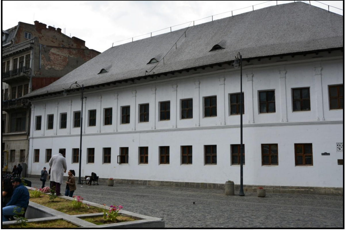
Foto 483. Bükreş Manuk Han'ın Kuzey Cephesinin Doğu Kanadı
