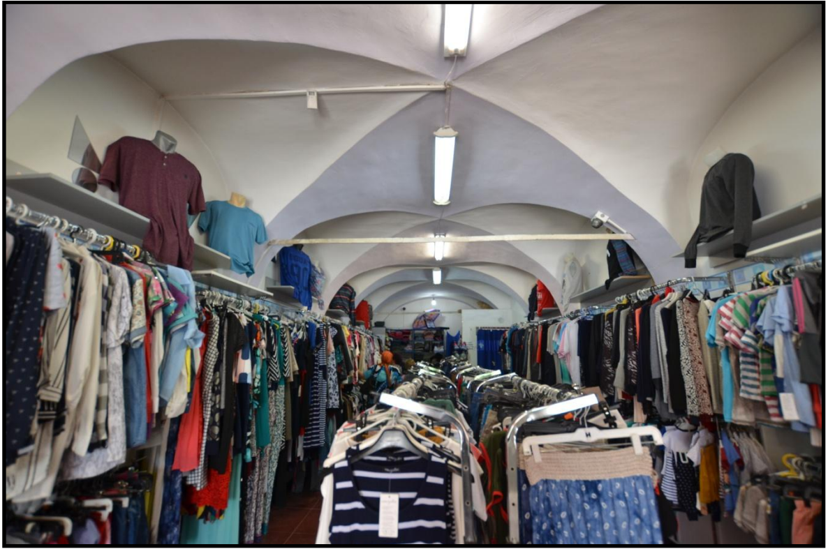
Foto 478. Lipova Türk Hamı'nın Zemin Kat Dükkânlarını Örtün Çapraz Tonoşlar
