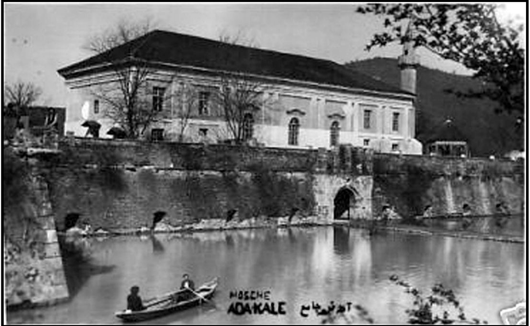
Foto 2. Ada Kale Camii
