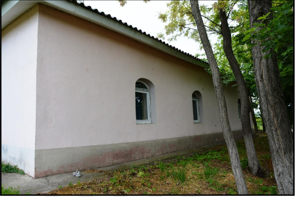
Foto 147. Valea Dacilor (Hendek Karakuyusu) Köyü Camii'nin Doğu Cephesi
