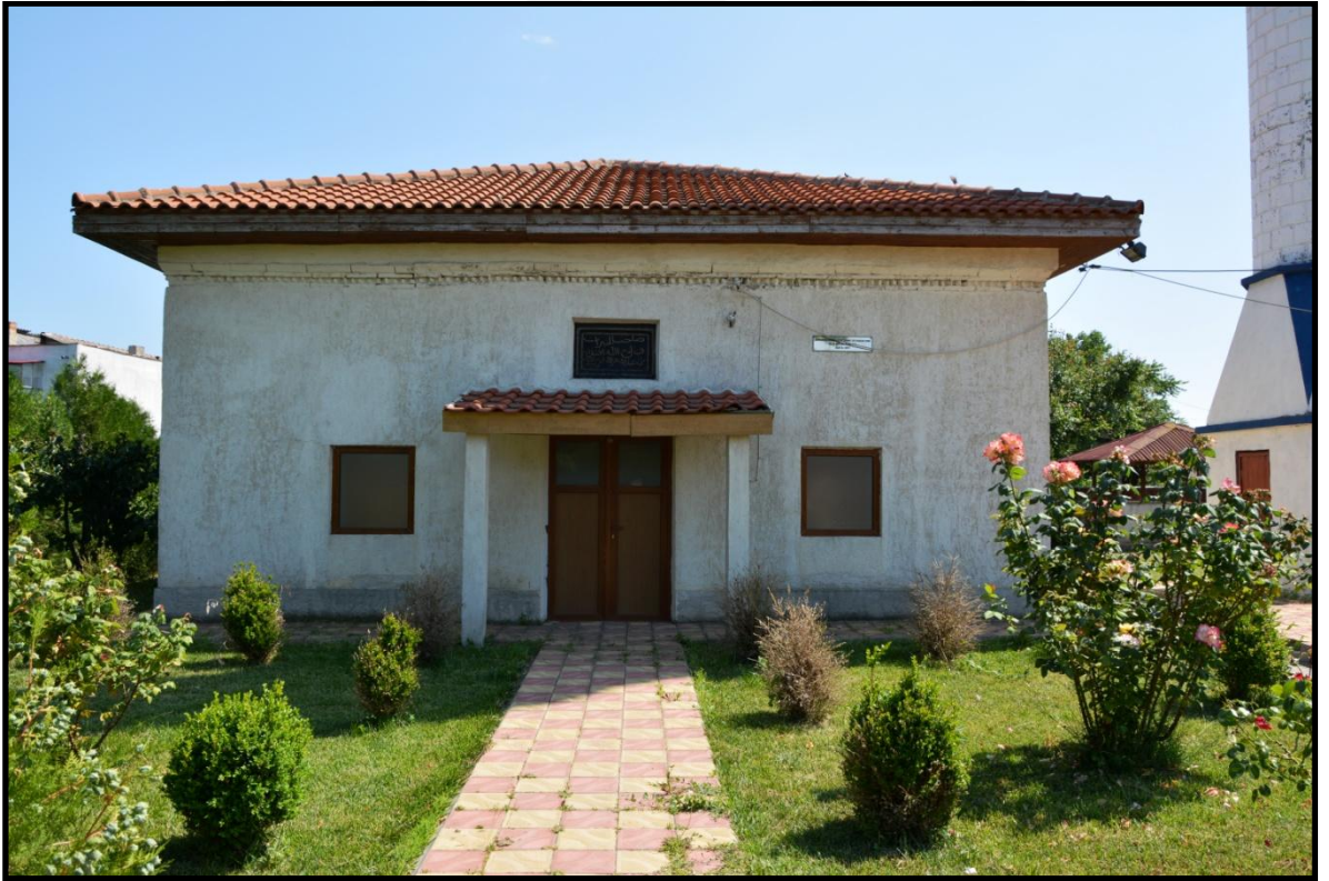
Foto 297. Pecineaga (Gelincik) Köyü Camii
