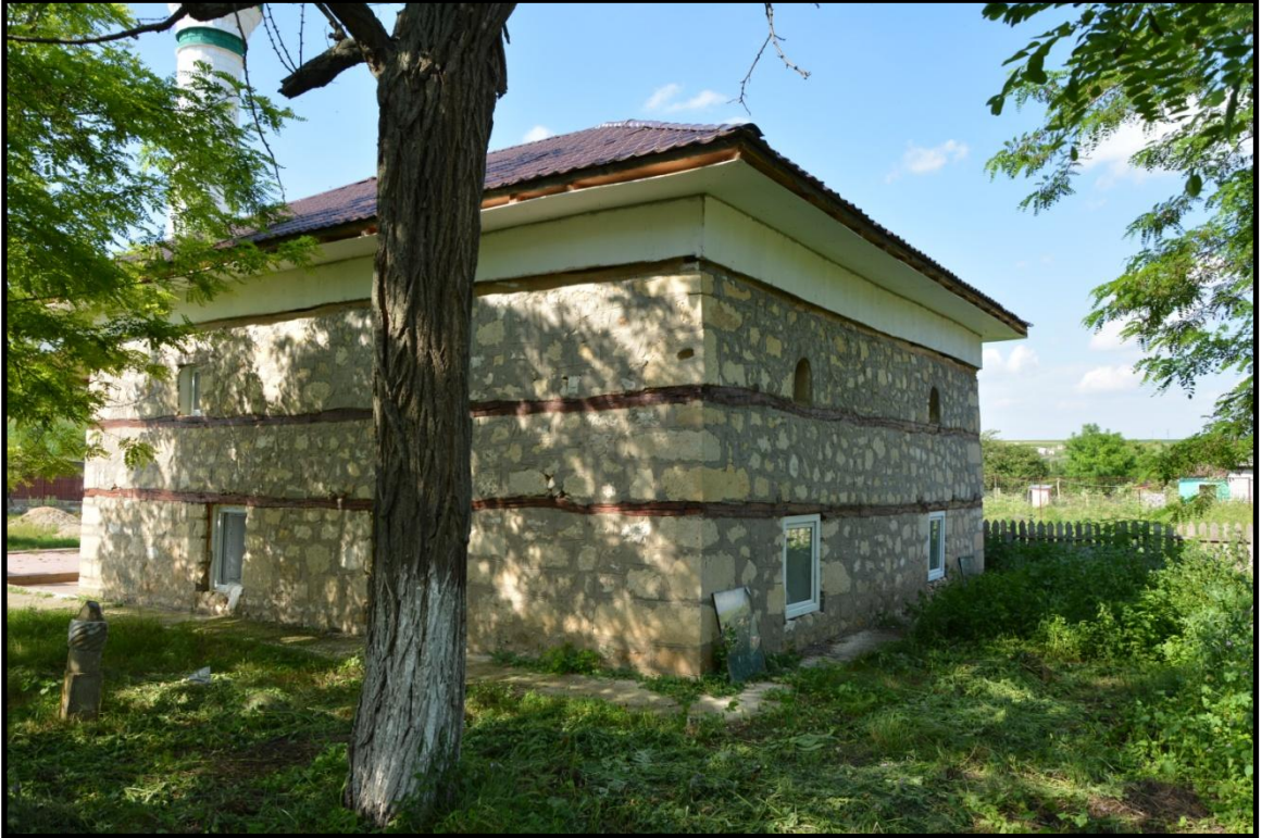
Foto 115. Faurei (Kalaycı) Köyü Camii'nin Güneybatı Cephesi
