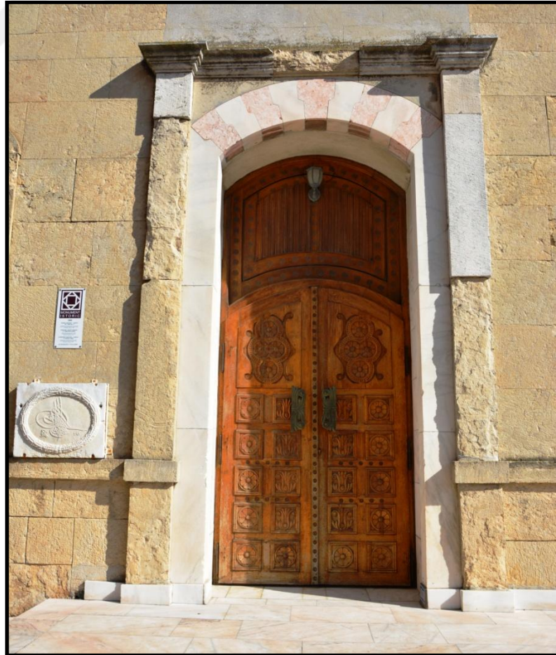
Foto 237. Köstence Hünkâr Cami'sine Giriş Kapısı
