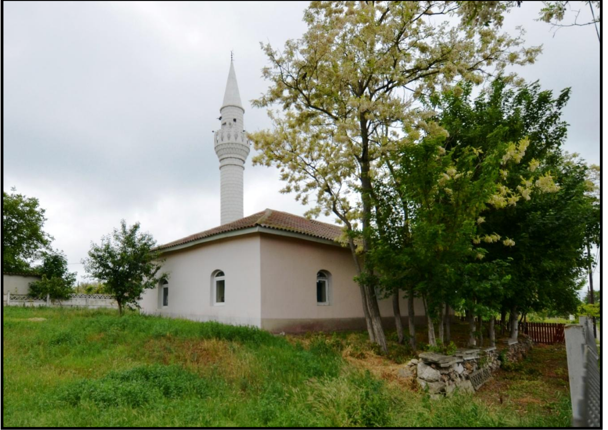
Foto 146. Valea Dacilor (Hendek Karakuyusu) Köyü Camii'nin Güneydoğu Cephesi
