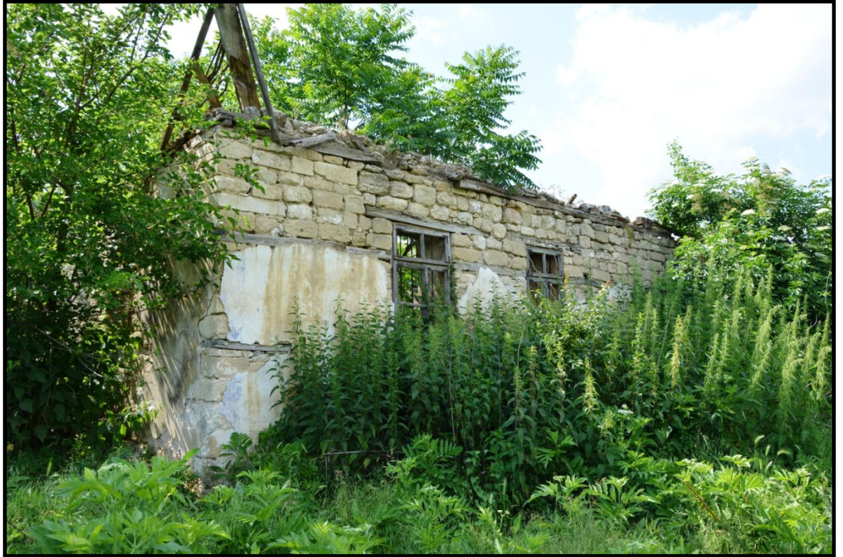
Foto 283. Brebeni (Çukurköy) Köyü Camii'nin Doğu Cephesi
