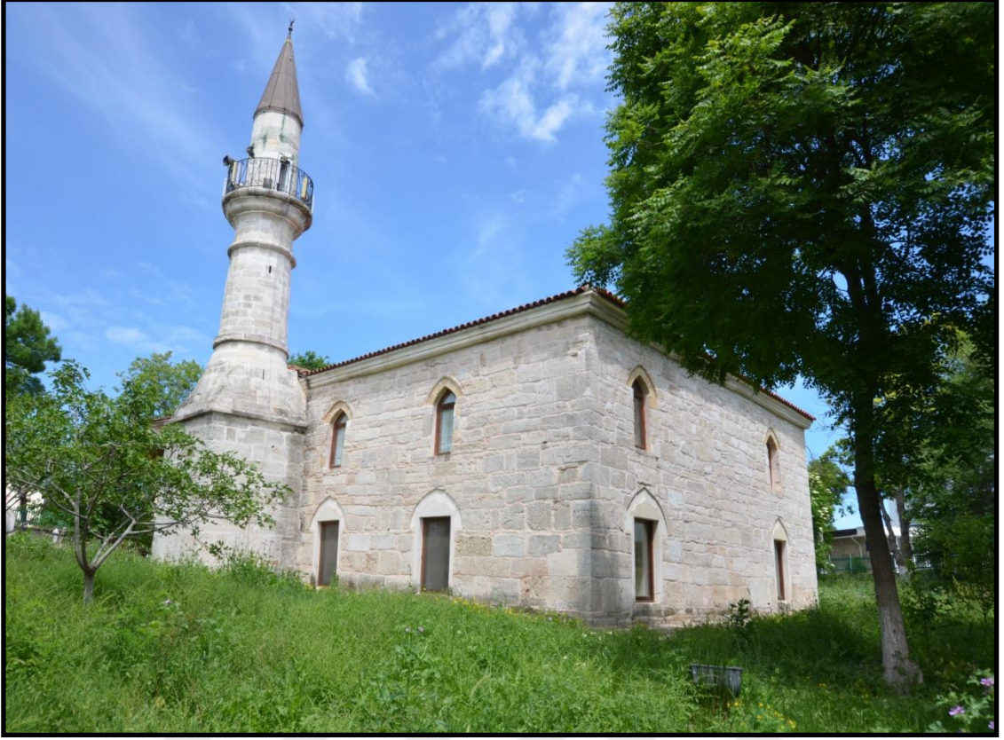
Foto 43. Mangalya Esmahan Sultan Camii'nin Güneybatı Cephesi
