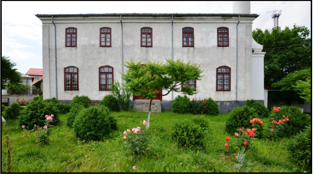
Foto 191. Tulça Aziziye Camii'nin Kuzey Cephesi
