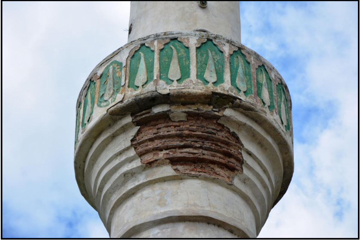
Foto 203. İshakça Mahmud Yazıcı Camii'nin Minare Şerefesinden Detay
