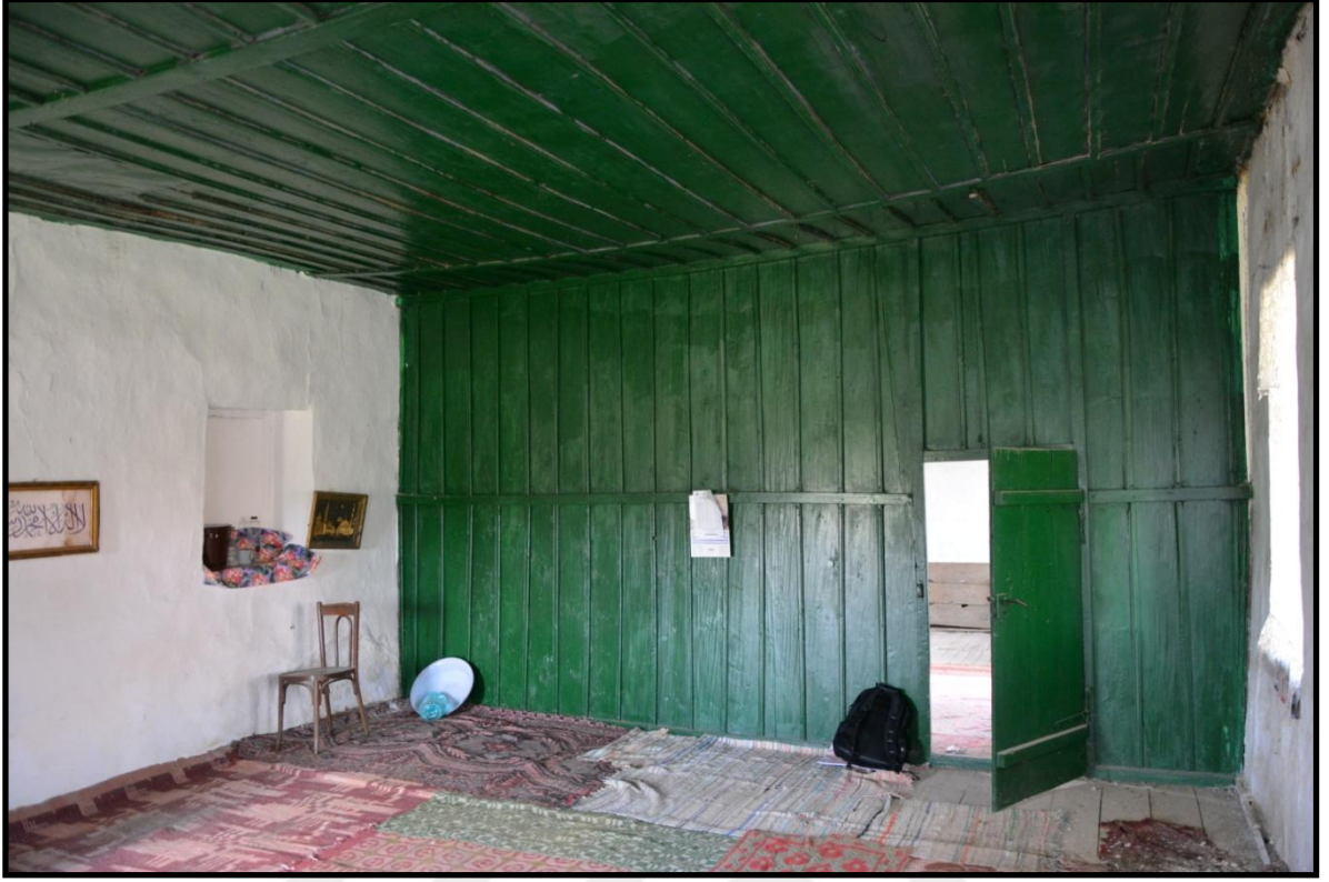
Foto 370. Abrud Köyü Camii Kuzey Duvarı
