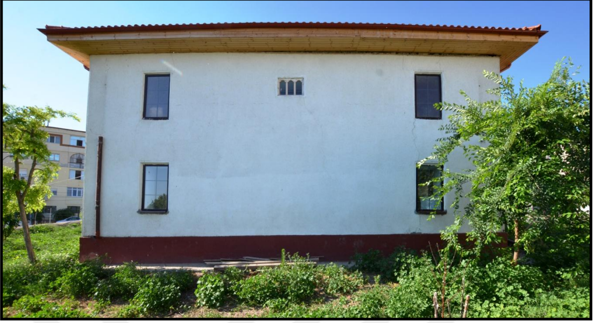
Foto 88. Hırşova Sultan Mahmud Camii Güney Cephe
