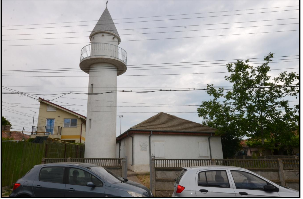
Foto 151. Palazu Mare (Palaz) Köyü Camii
