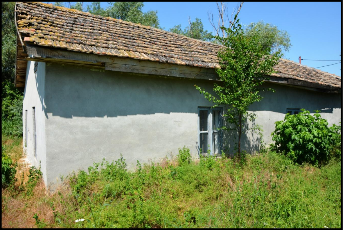
Foto 293. Gherghina (Defçe) Köyü Camii'nin Doğu Cephesi
