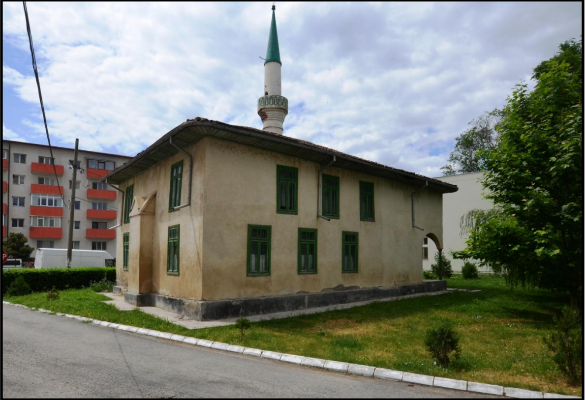
Foto 201. İshakça Mahmud Yazıcı Camii'nin Güneydoğu Cephesi
