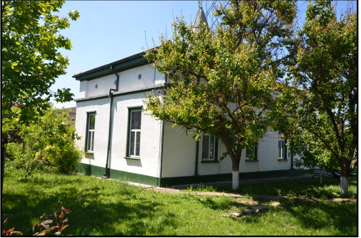
Foto 157. Köstence-Anadolchioi (Anadolu-Anadol Köy) Camii'nin Güneydoğu Cephesi
