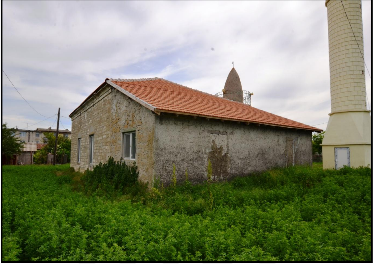
Foto 224. Negru Voda (Kara Ömer) Köyü Camii'nin Kuzeydoğu Cephesi
