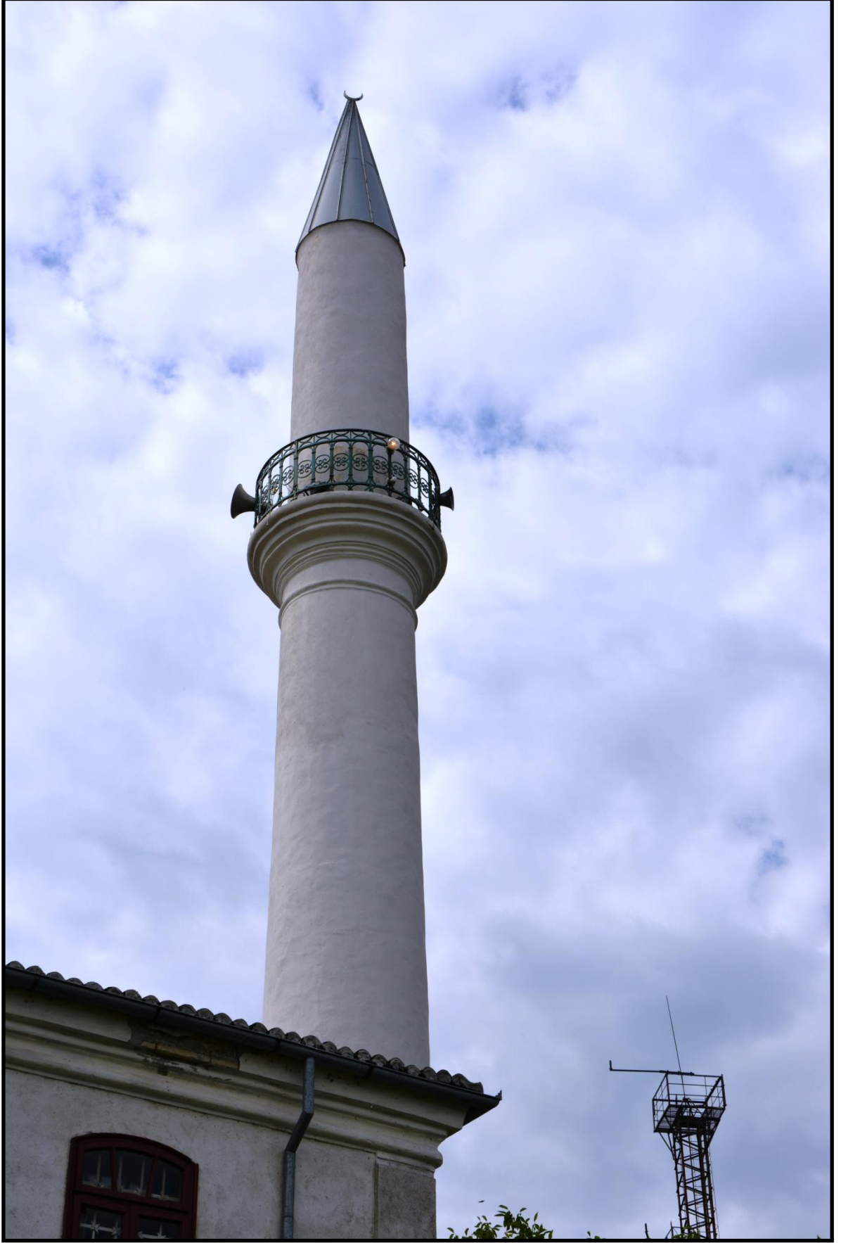
Foto 189. Tulça Aziziye Camii'nin Minaresi
