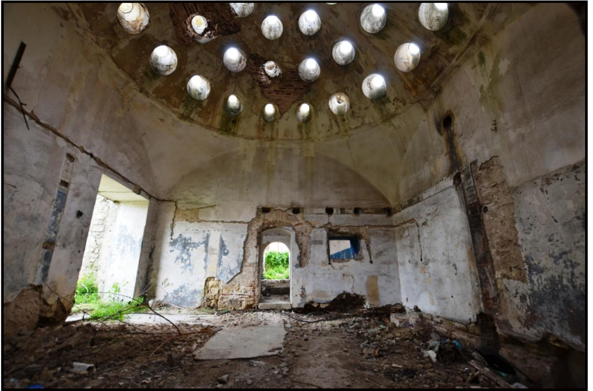
Foto 511. Mecidiye-Karasu Abdülmecid Hamamı'nın Sıcaklık Bölümü
