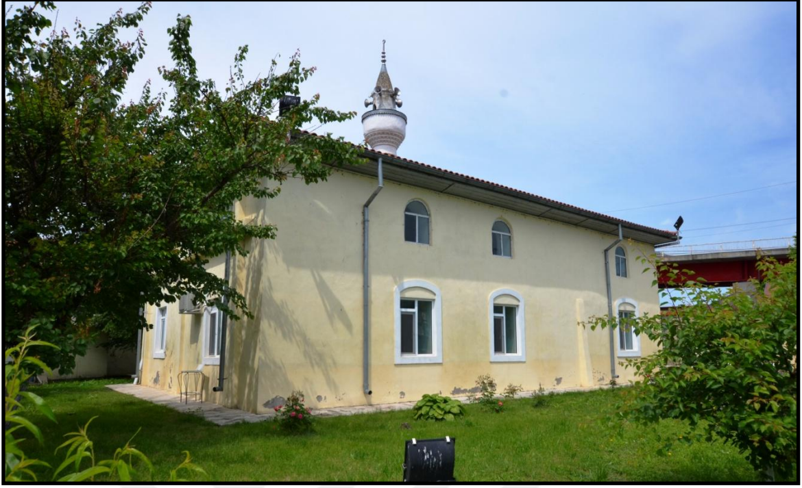
Foto 74. Çernavoda (Boğazköy) Hünkâr Camii'nin Güneydoğu Cephesi
