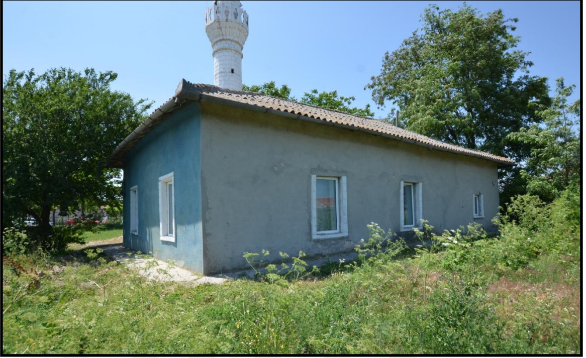
Foto 130. Moşneni (Pavel) Köyü Camii'nin Güneydoğu Cephesi
