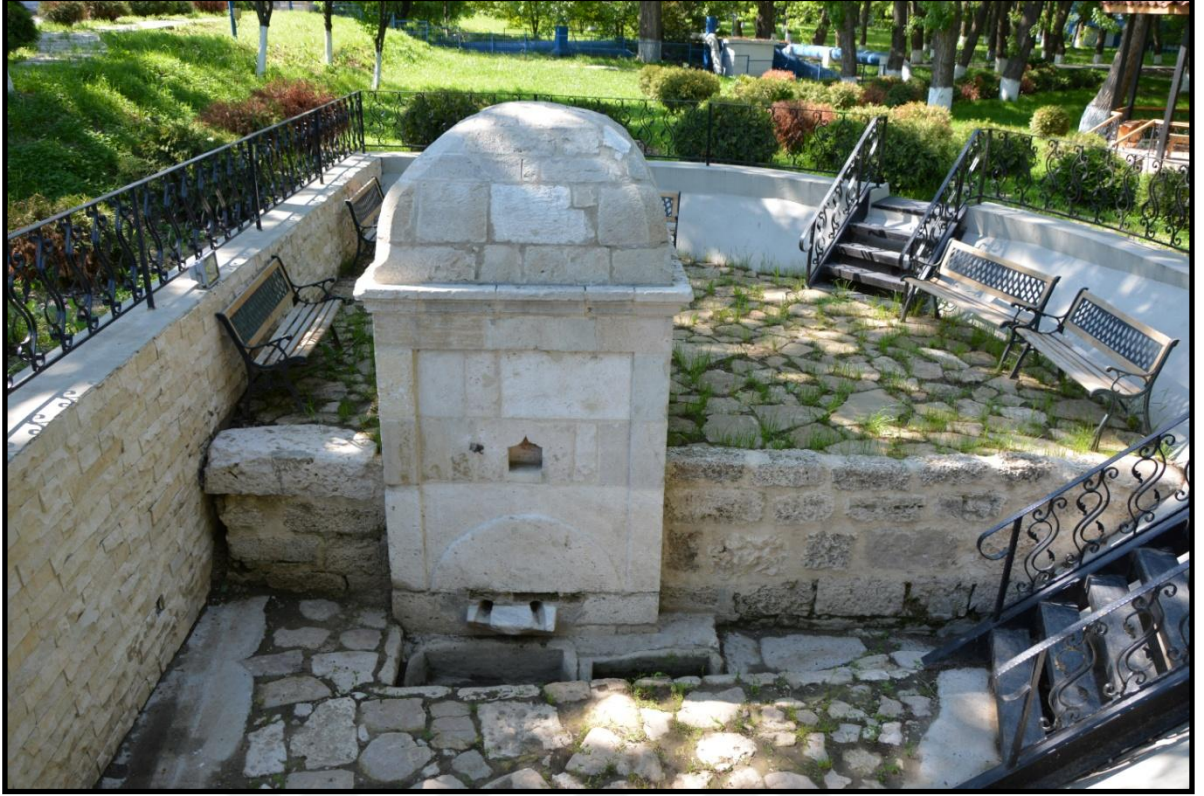
Foto 447. Köstence Sultan Abdülaziz Çeşmesi'nin Restorasyon Sonrası Durumu
