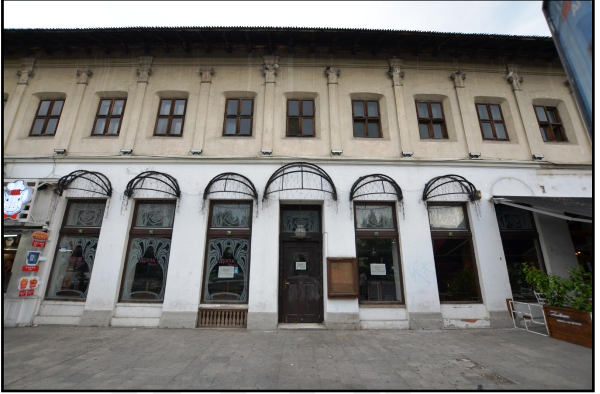
Foto 493. Bükreş Manuk Han'ın Güneybatı Cephesinden Detay
