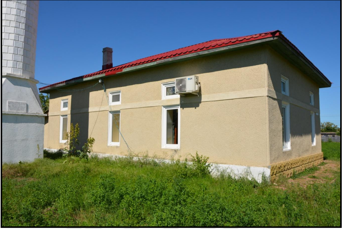
Foto 415. Topraisar (Toprakhisar) Köyü Camii'nin Güneybatı Cephesi
