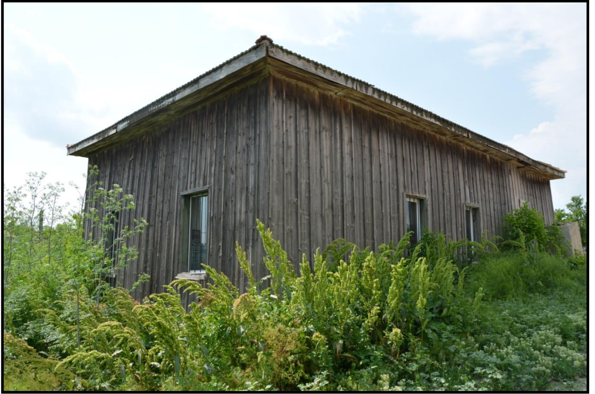
Foto 229. Gradina (Dokuzsupu) Köyü Camii'nin Güneydoğu Cephesi
