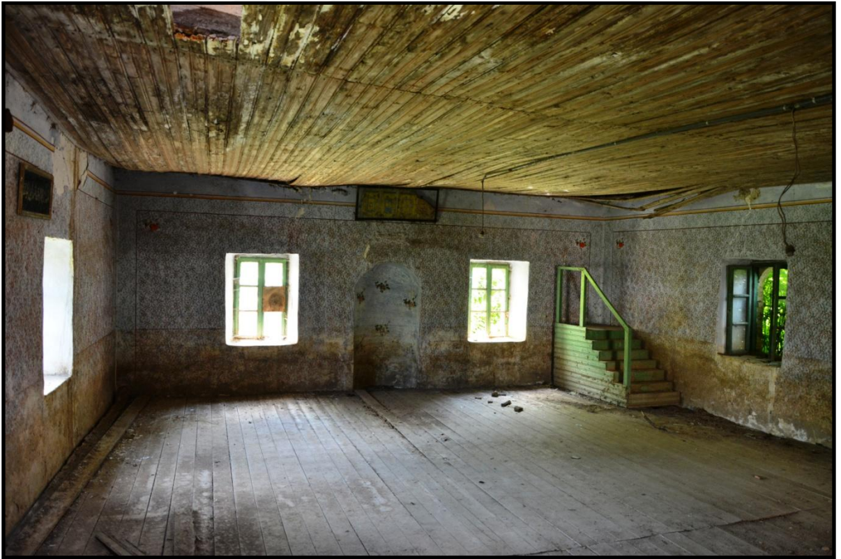
Foto 217. Albeşti (Akbaş) Köyü Camii Güney Duvarı
