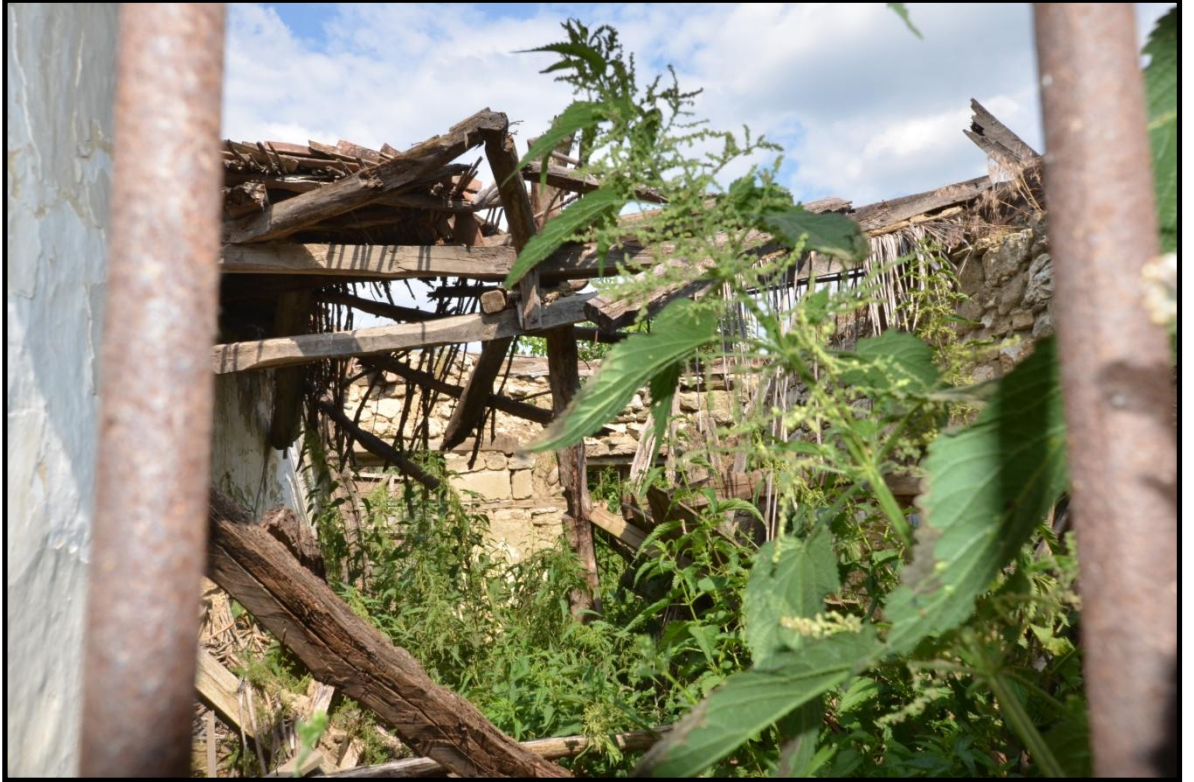
Foto 285. Brebeni (Çukurköy) Köyü Camii'nin Harim Bölümü
