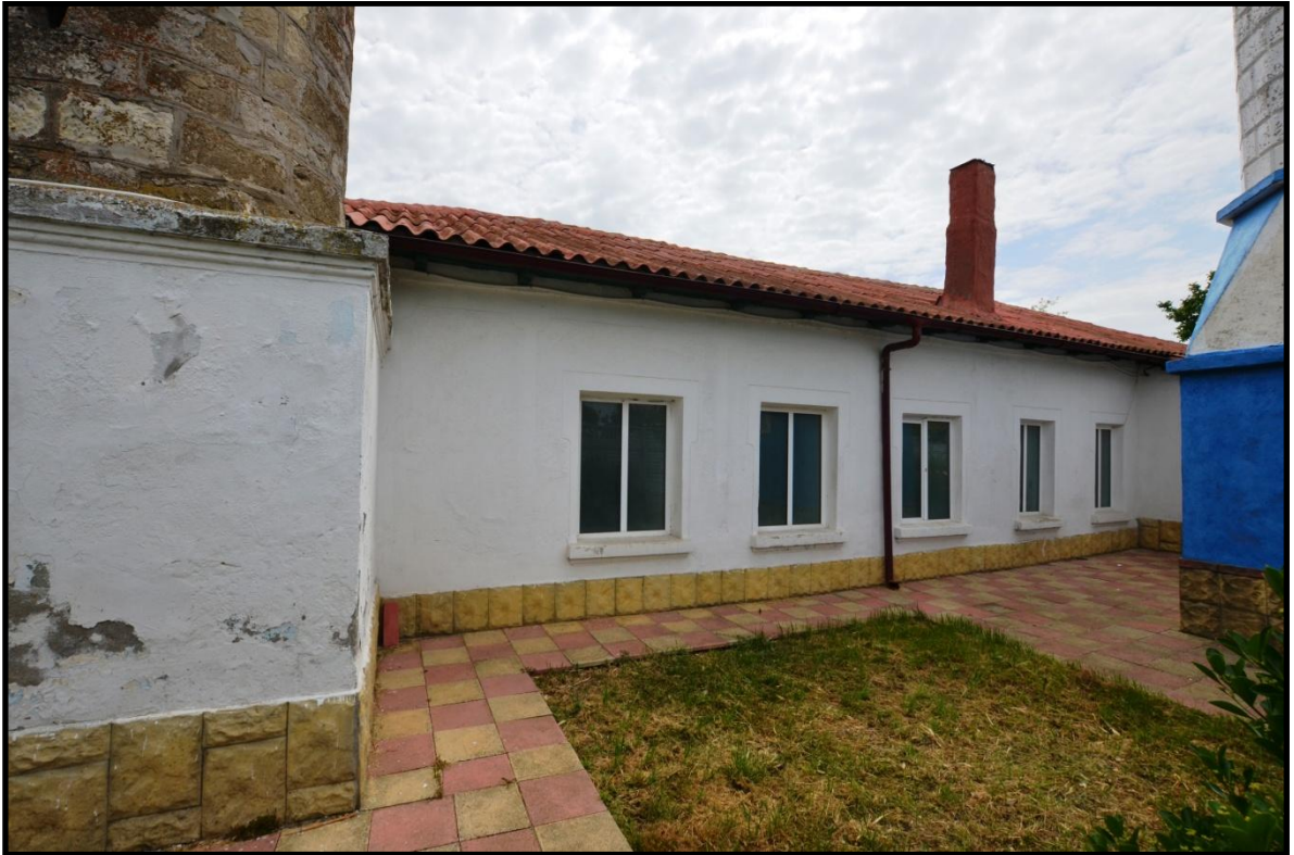
Foto 257. Tuzla Köyü Camii'nin Batı Cephesi
