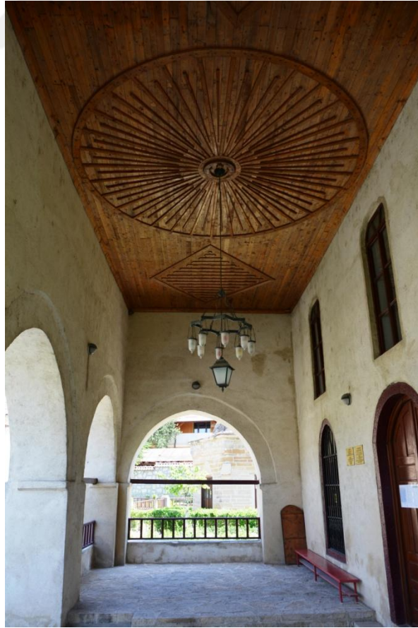
Foto 65. Babadağ Gazi Ali Paşa Camii Son Cemaat Mahalli
