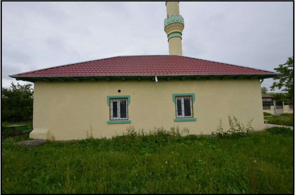
Foto 307. Poarta Alba (Ala Kapı) Köyü Camii Doğu Cephesi
