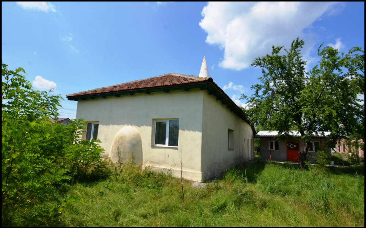
Foto 347. Mihail Kogalniceanu (Kara Murat) Köyü Camii'nin Güneydoğu Cephesi
