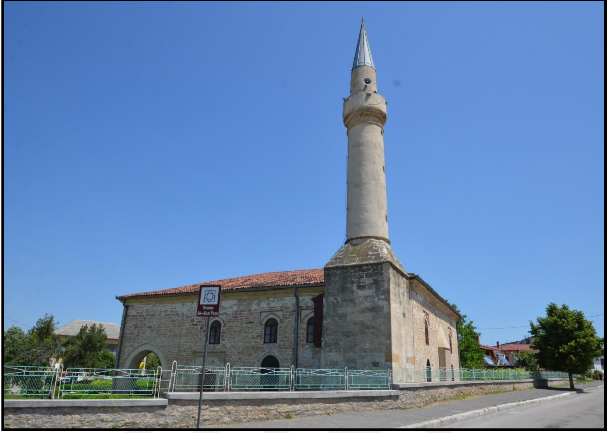
Foto 64. Babadağ Gazi Ali Paşa Camii Güneybatı Cephesi
