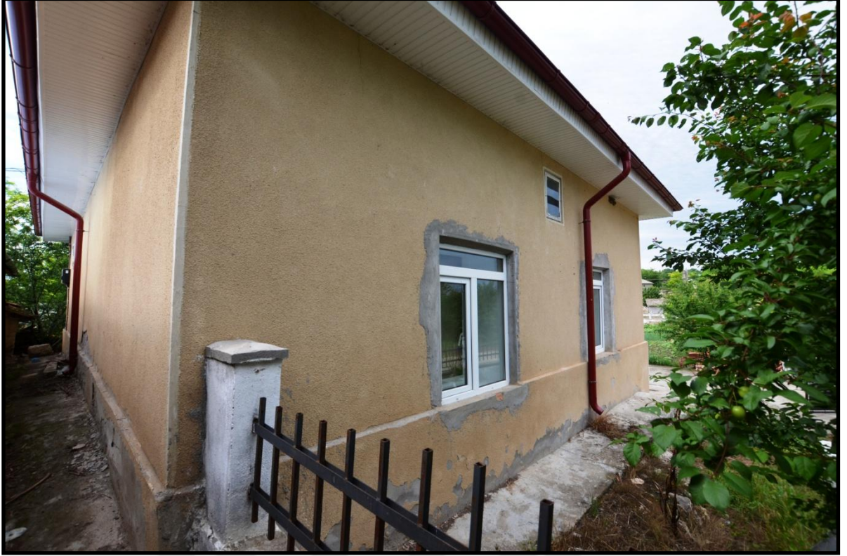
Foto 272. Independenta (Bayramdede) Köyü Camii'nin Güneybatı Cephesi
