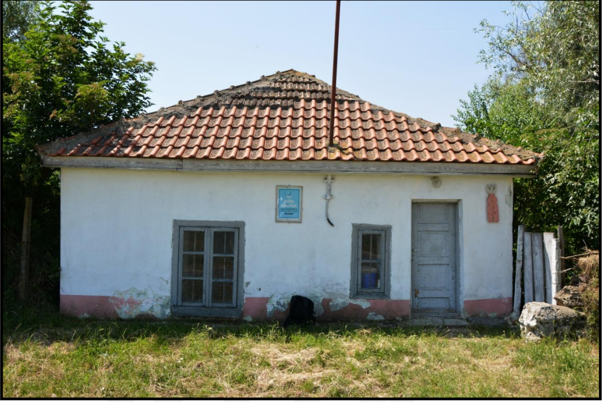
Foto 292. Gherghina (Defçe) Köyü Camii
