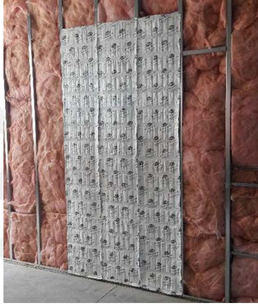
Şekil 2.3. Bir BioFDM'nin duvar zarfına tipik entegrasyonu
