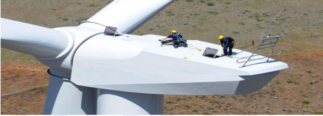
Şekil 1.16. Rüzgar Türbini bakım çalışmaları (Url-14)
