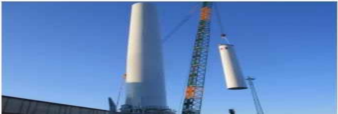
Şekil 1.14. Türbin kulelerinin montajı (Yavuz ve Özbay, 2020)
