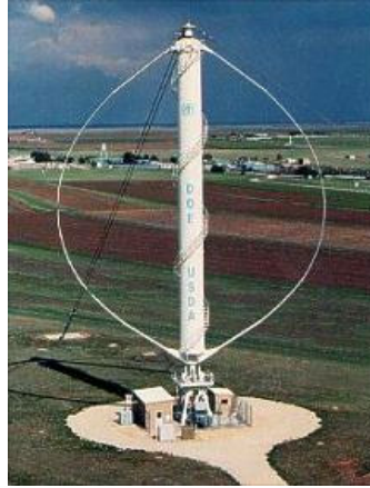
Resim 3.1. Dikey eksenli darrieus rüzgar türbini
