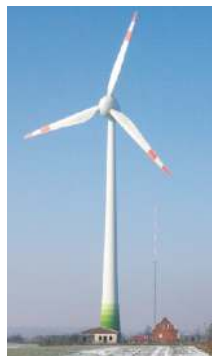
Resim 3.2. Yatay eksenli rüzgar türbini- Enercon E-112. 4,5 MW
