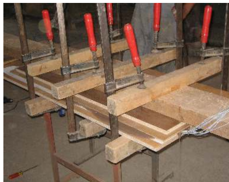
Resim 4.15. Kalıpların mengene ile sıkılması
