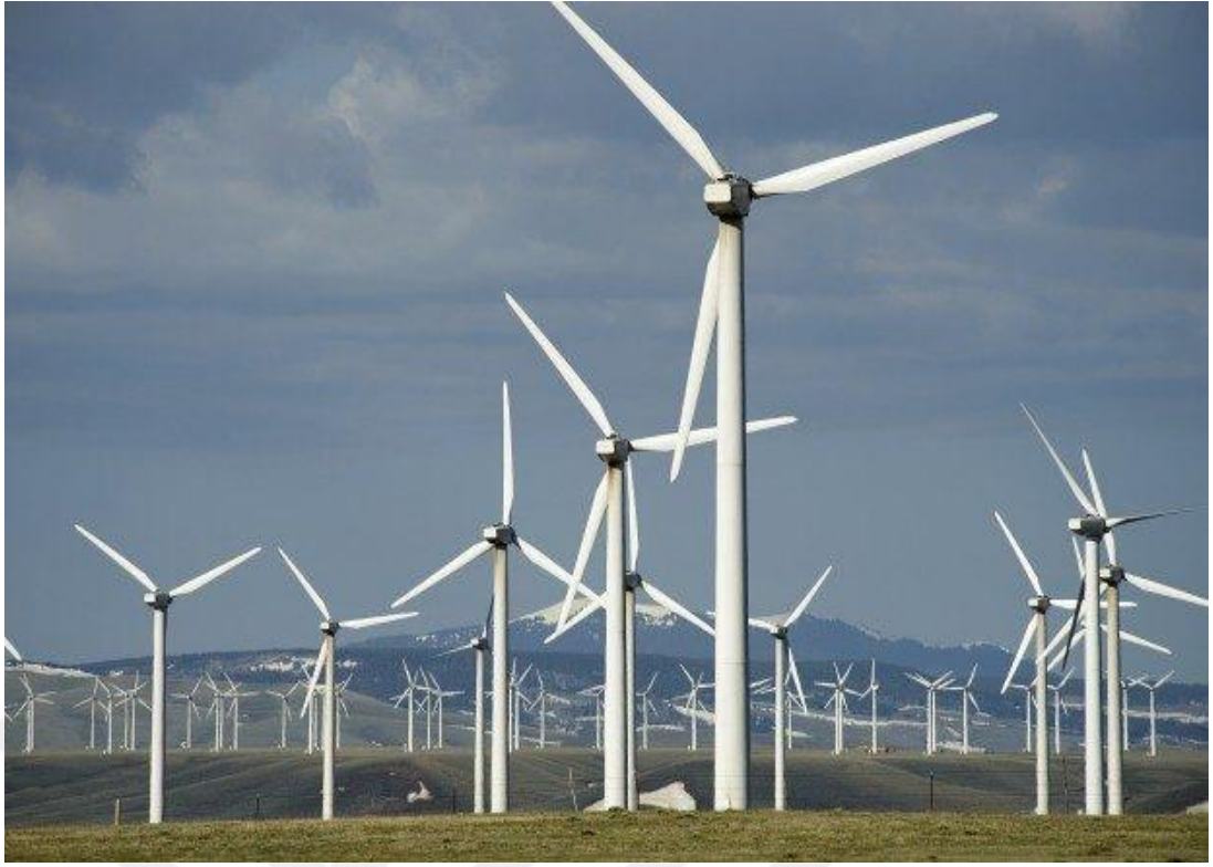
Şekil 21. Rüzgâr enerji santrali
